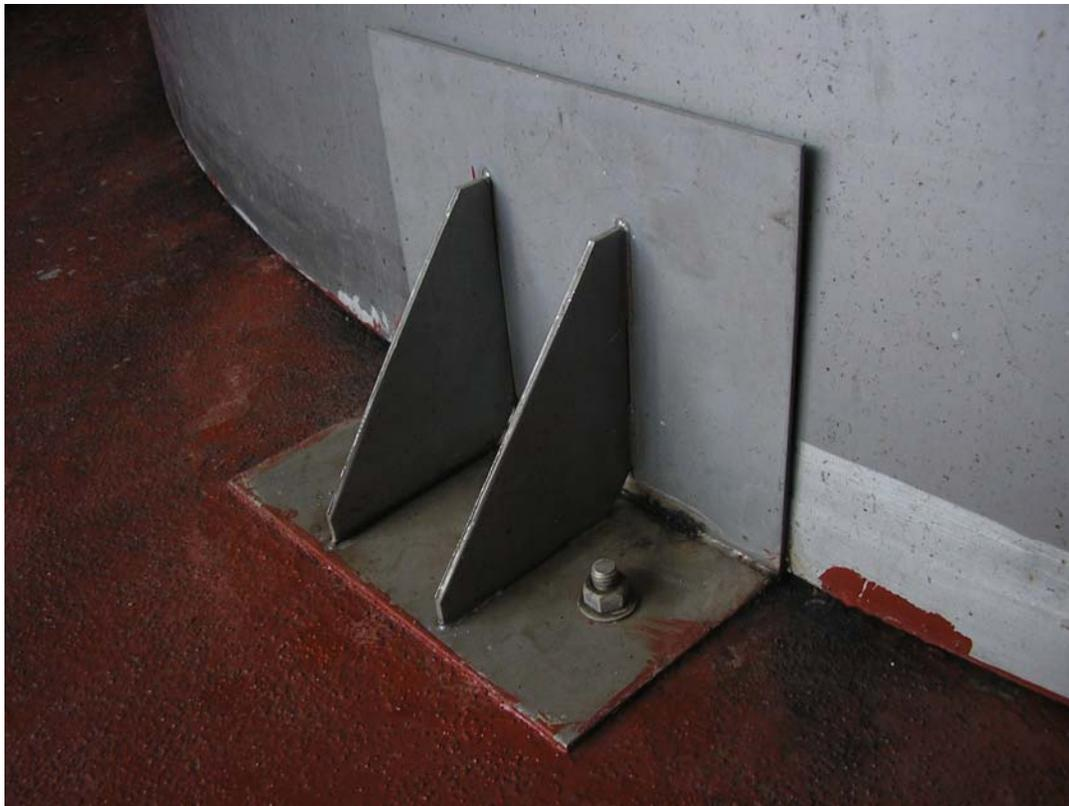
Figura 3.12: Cuba A145, estanque apoyado con sistema de topes
