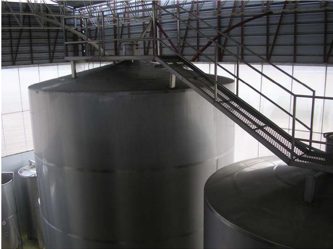
Figura 49: Cuba A32, estanque apoyado con topes A32, la pasarela produjo el pandeo del techo del estanque, además de ser muy peligrosa para transitar por la inclinación que presenta
