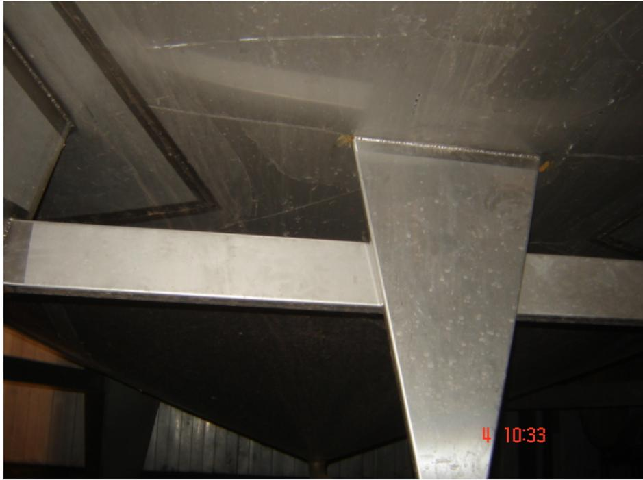
Figura 3.38: Cuba A112, patas apoyadas, la foto muestra el sistema de arriostramientos para la estabilidad de las patas, en este caso el fondo solo se soportaba sobre las patas
