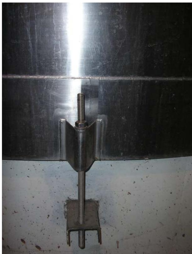
Figura 3.7: Cuba A21, anclado mediante falda de anclaje
