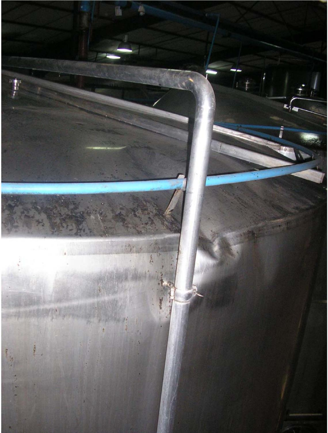
Figura 3.35: Cuba A17, simplemente apoyado, falla por operación, falla en el centro del techo por mal diseño de este, los ángulos en la foto se agregaron después para rigidizar el techo ya que este era incapaz de auto-soportarse, aún son insuficientes
