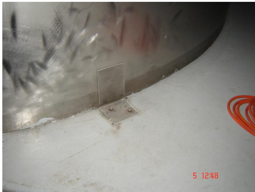
Figura 3.40: Cuba A155, el estanque contaba con 4 topes, equidistantes y con pernos de 3 [mm]
