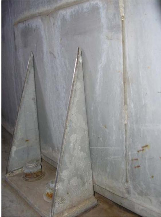
Figura 3.41: Cuba A11, estanque apoyado, el estanque contaba con 14 topes a distancias distintas
