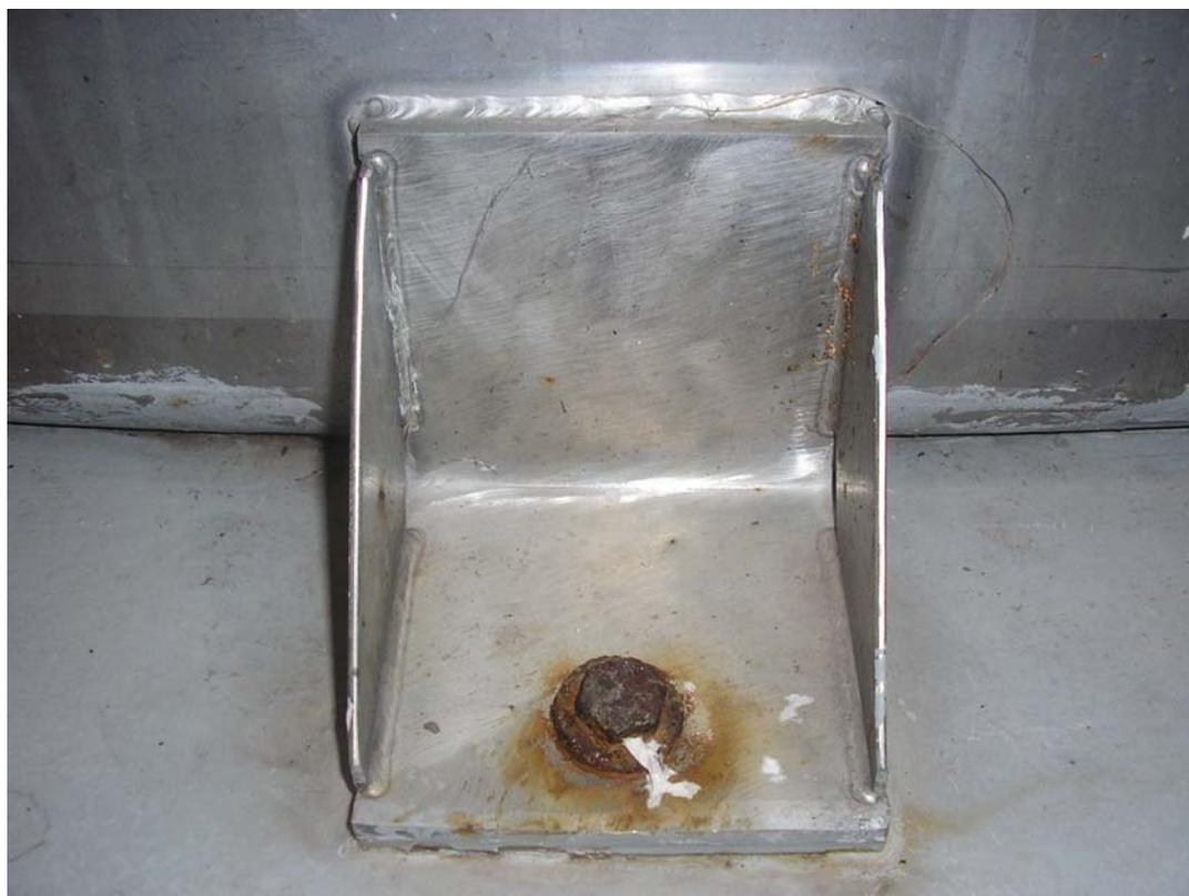
figura 3.6: Cuba A62, anclado mediante silla de anclaje
