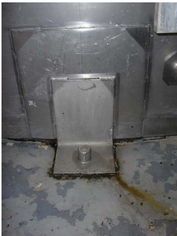
Figura 3.5: Cuba A131, anclado mediante silla de anclaje
