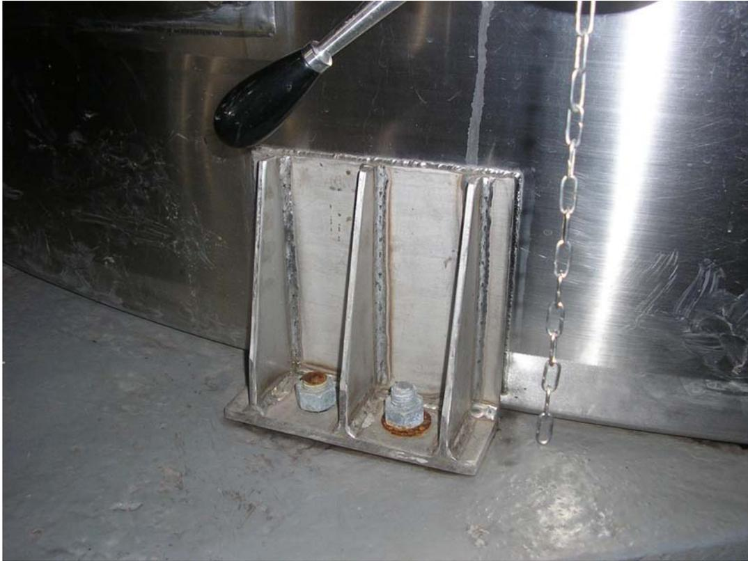
Figura 3.9: Cuba A02, anclado mediante silla de anclaje
