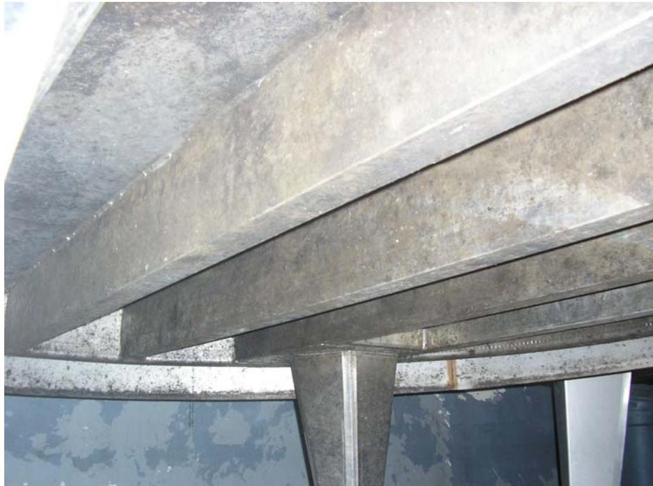
Figura 3.39: A1312, patas apoyadas, la foto muestra el sistema de envigado que soporta el fondo del estanque y le da estabilidad a las patas
