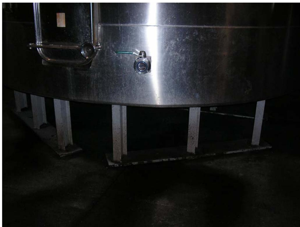
Figura 3.14: Cuba A133, estanque apoyado con sistema de falda sobre plataforma de patas
