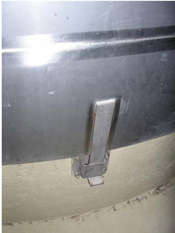
Figura 3.10: Cuba A75, falda de anclaje
