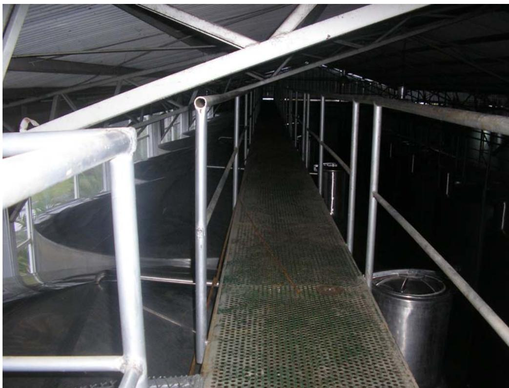
Figura 3.48: Cuba A51, pasarela sobre estanques, simplemente apoyados, la pasarela es demasiado baja para estar de pie
