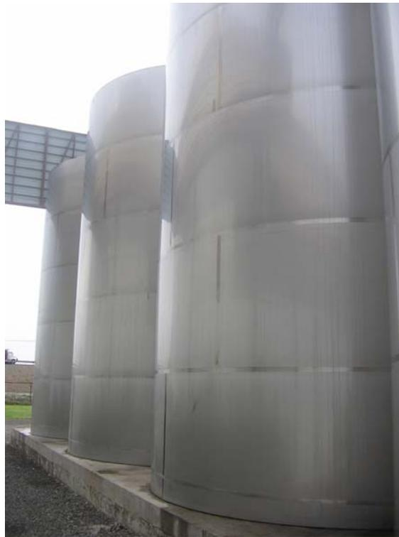
Figura 3.42: A31, estanques apoyados con una falda, estanques de 7,5 [m] de altura con una falda de máxima altura de 30 [cm], 2,5 [mm] de espesor
