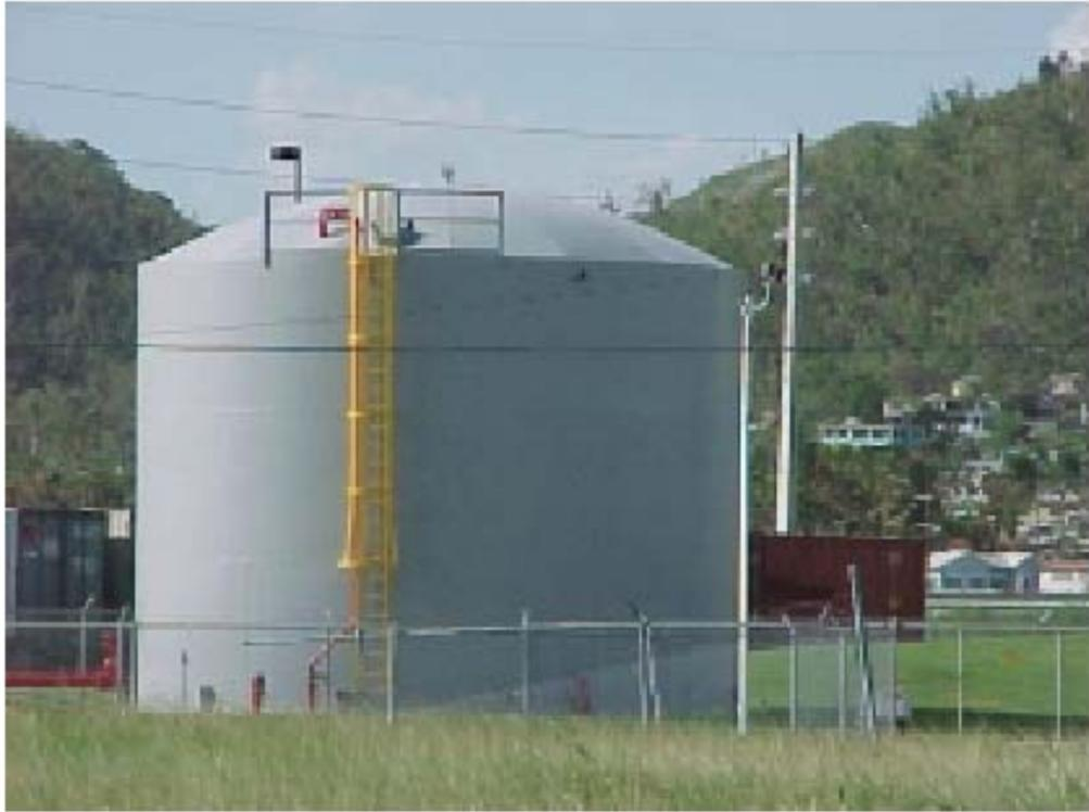
Figura 2.4: Estanque con techo tipo paraguas
