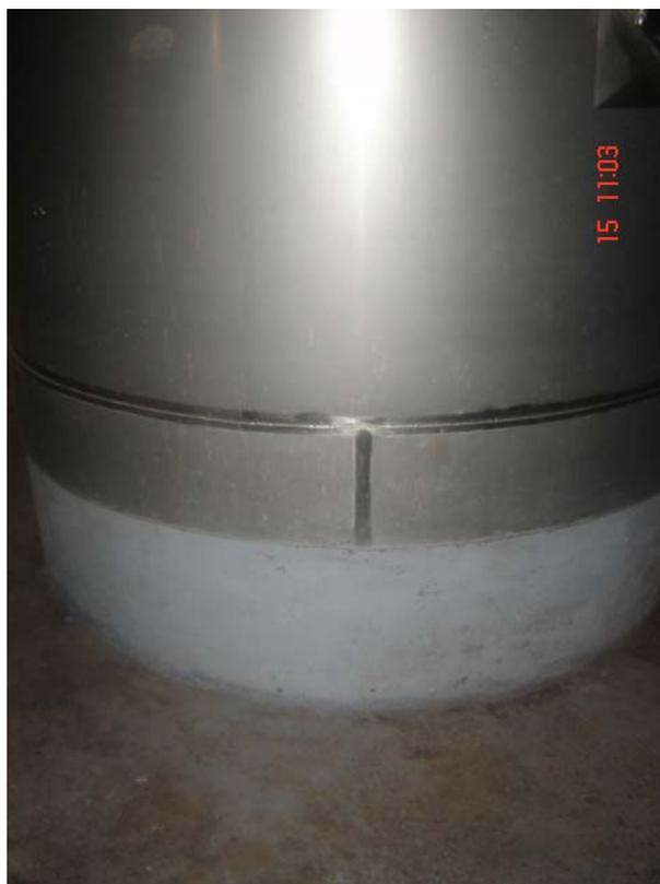
Figura 3.13: Cuba A85, estanque apoyado con sistema de falda
