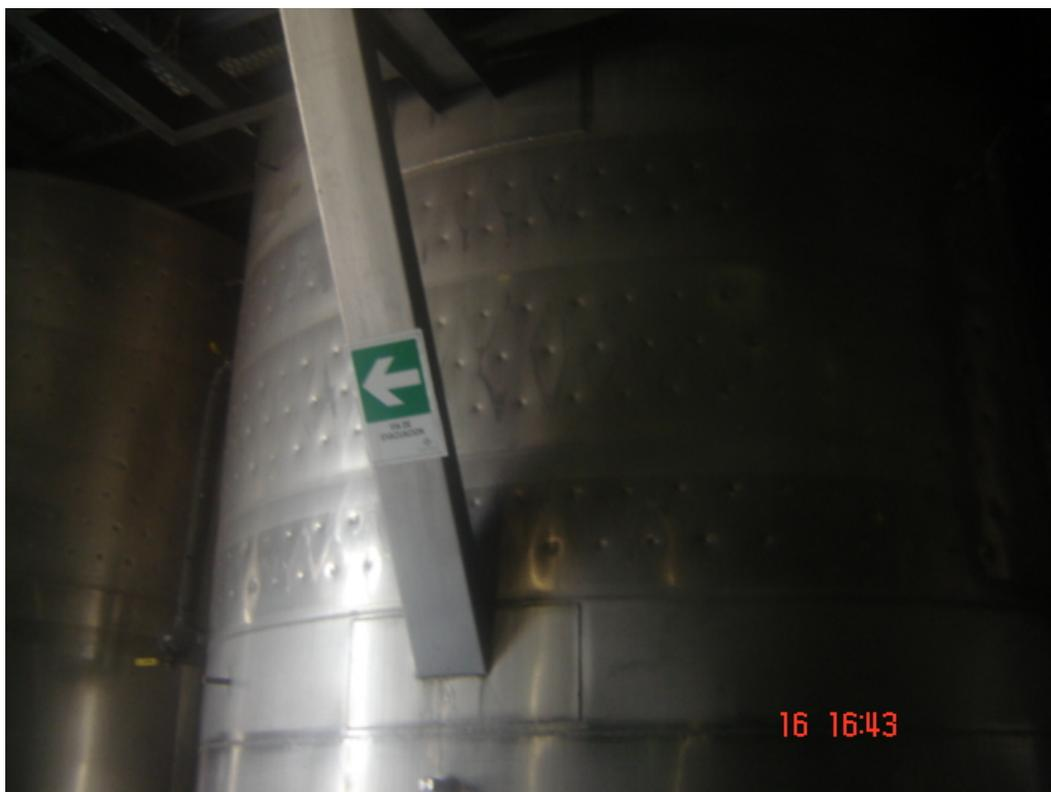
Figura 3.47: Cuba A46, estanque anclado, pasarela apoyada en el manto
