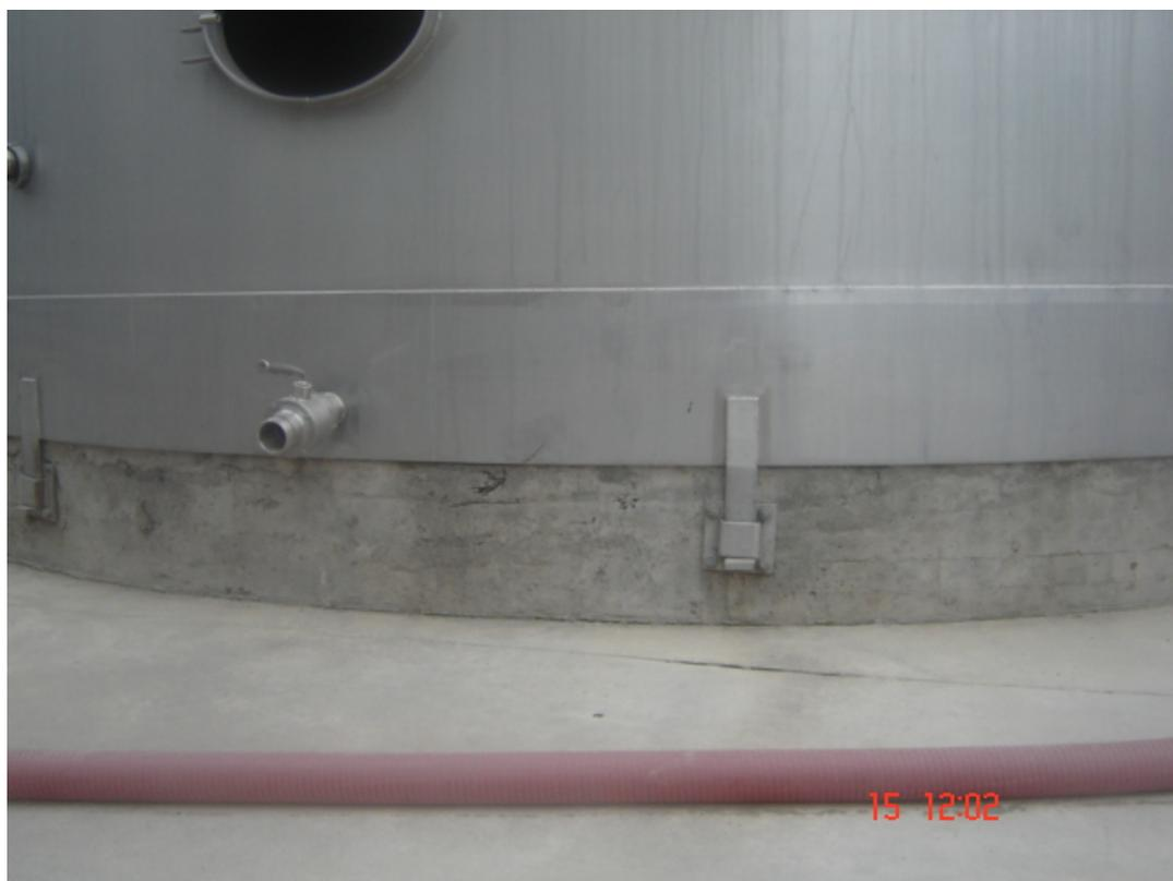
Figura 3.8: Cuba A91, anclado mediante falda de anclaje
