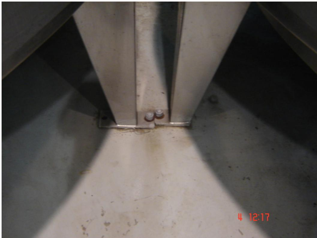
Figura 3.36: Cuba A103, patas ancladas una sobre otra, con pernos de 1/2" pulgada
