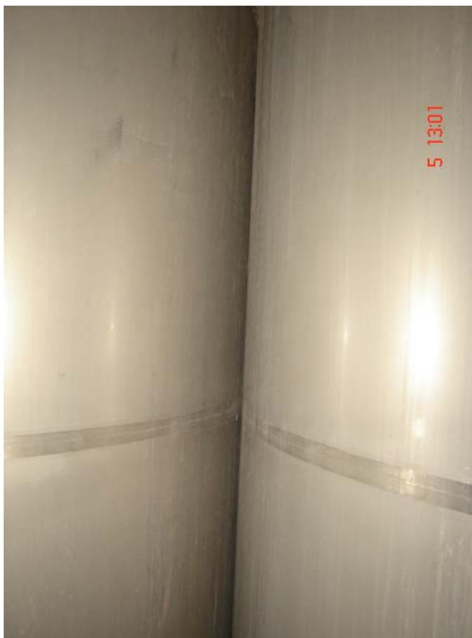
Figura 3.44: A154, estanques apoyados con topes, separación nula
