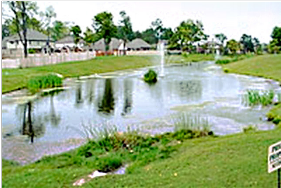
FIGURA 6.1 ESTANQUE DE INFILTRACIÓN.
