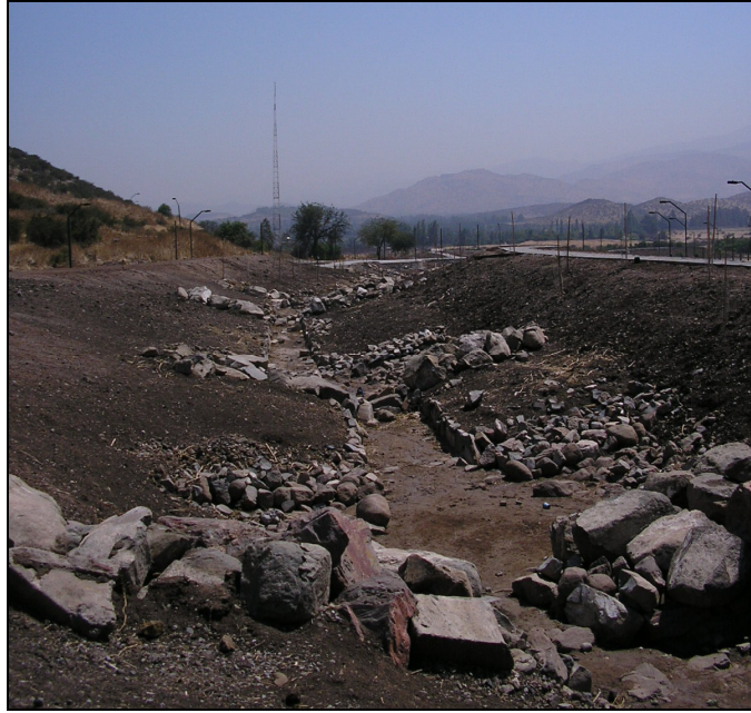
FIGURA 6.4 CAUCE NATURAL MEJORADO, QUEBRADA ON2, CONDOMINIO LA RESERVA, VALLE DE CHICUREO.
