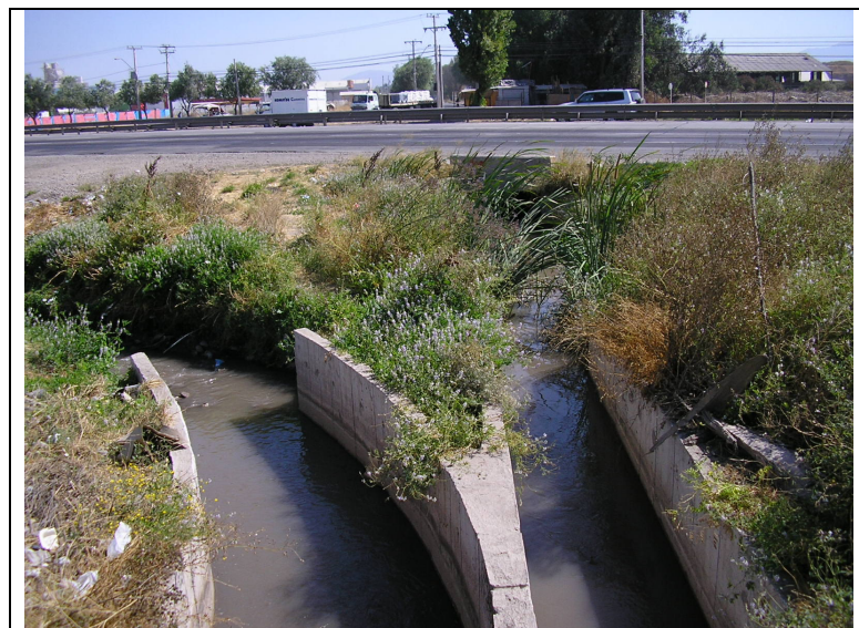
FIGURA 2.3 ESTERO LOS PATOS EN LLEGADA A RUTA 5 NORTE.
