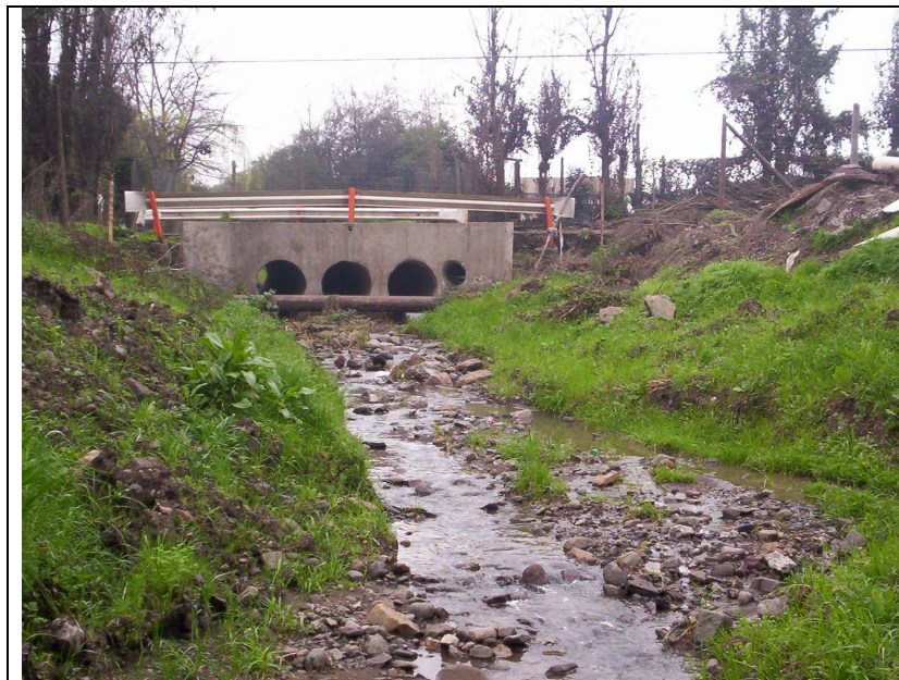
FIGURA 2.1 QUEBRADA LA NIPA, EN CRUCE CON CALLE LOS ALGARROBOS.
