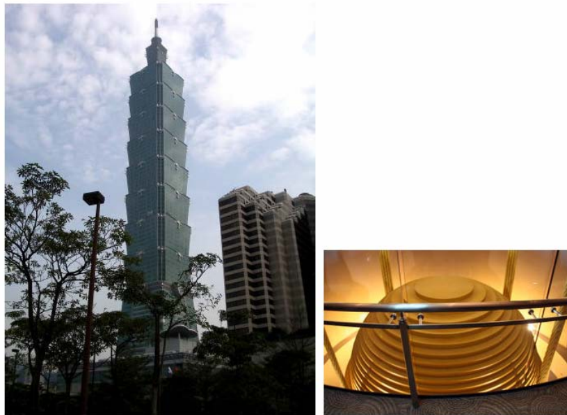
Figura 1.1: Torre Taipei 101 y disipador de masa sintonizada, Taipei, China
