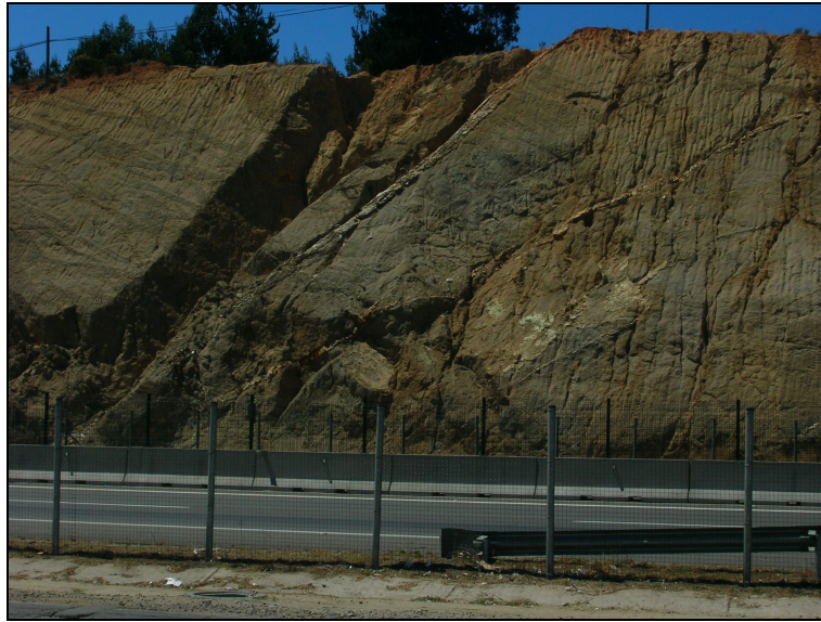
Fig 33 “Km 98.300 inestabilidad típica en plano de debilidad heredado ”
