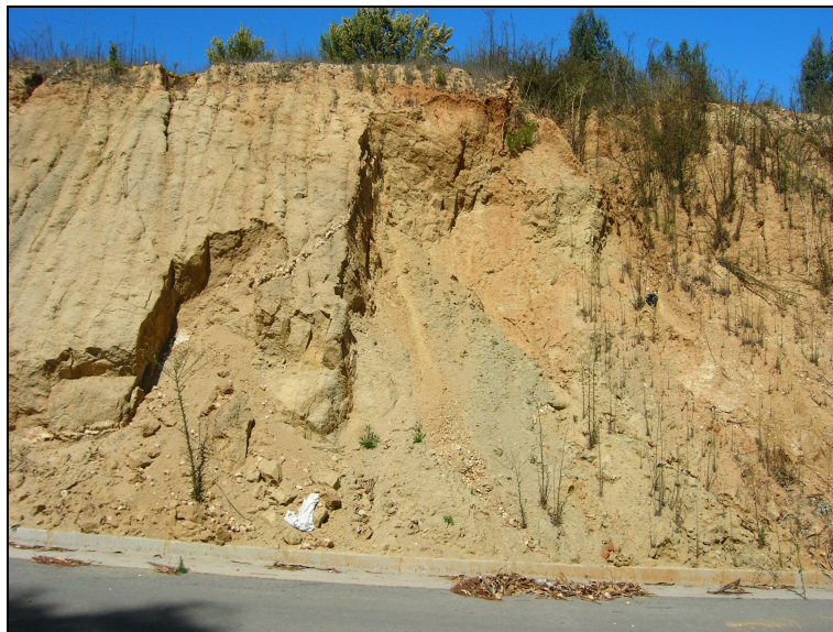
Fig 34 “Km 98.300 desprendimiento ”
