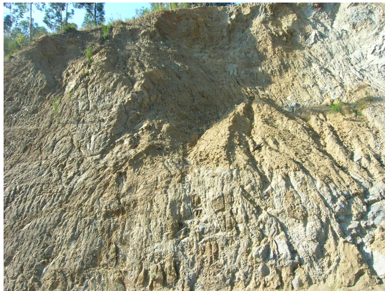
Fig 40 “Km 105.400 detalle de diaclasas y falla en este kilometraje”
