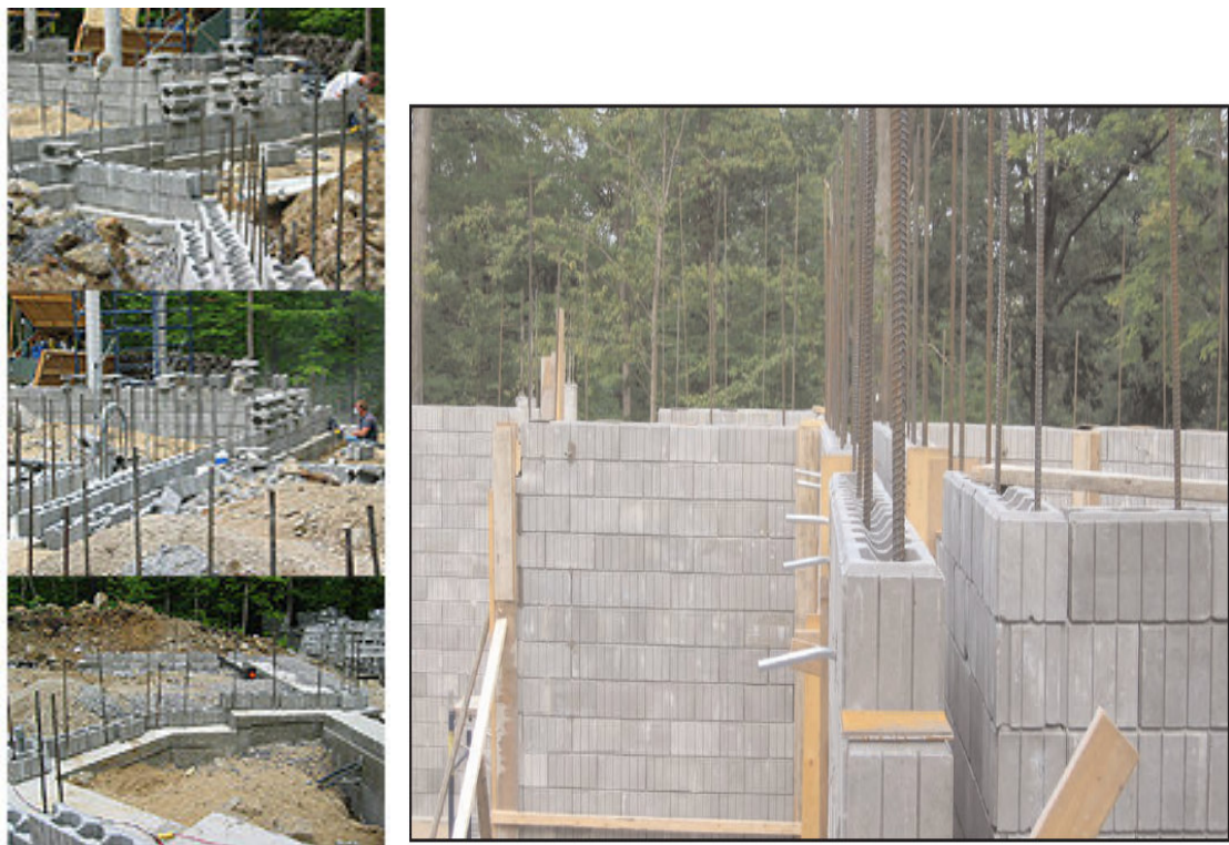
Figura N° 39: Refuerzo vertical en construcción de muros utilizando albañilería de bloque sin mortero
