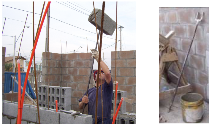
Figura N° 4: Levantamiento de un bloques utilizando una herramienta.
