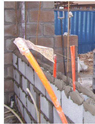
Figura N° 19: Colocación y posicionamiento de ductos y cañerías para instalaciones.
