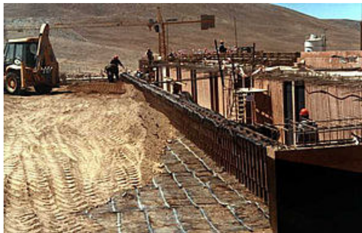
Figura N° 45: Colocación del estabilizado sobre la geogrilla, por detrás del bloque, para luego ser compactado y avanzar a la siguiente capa.
