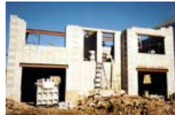
Imágenes del procedimiento constructivo utilizando el sistema de bloques Sparlock.
