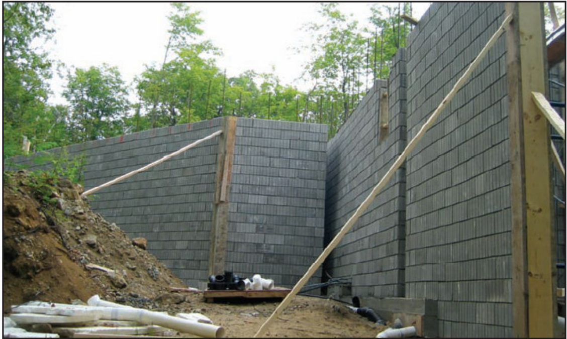
Figura N° 38: Arriostramiento de muros para mantener verticalidad.
