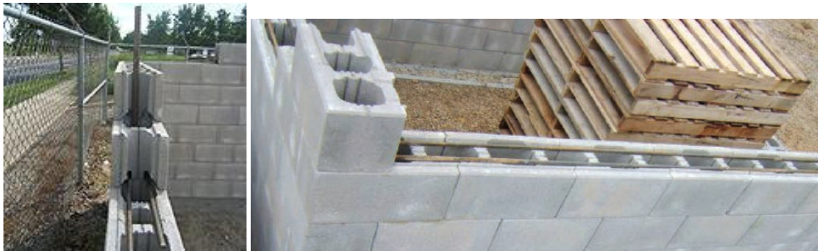
Figura N° 40: Refuerzo horizontal en construcción de muros utilizando albañilería de bloque sin mortero
