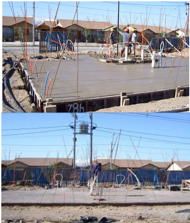
Figura N° 3: Tensores ya instalados sobre el cemento.
