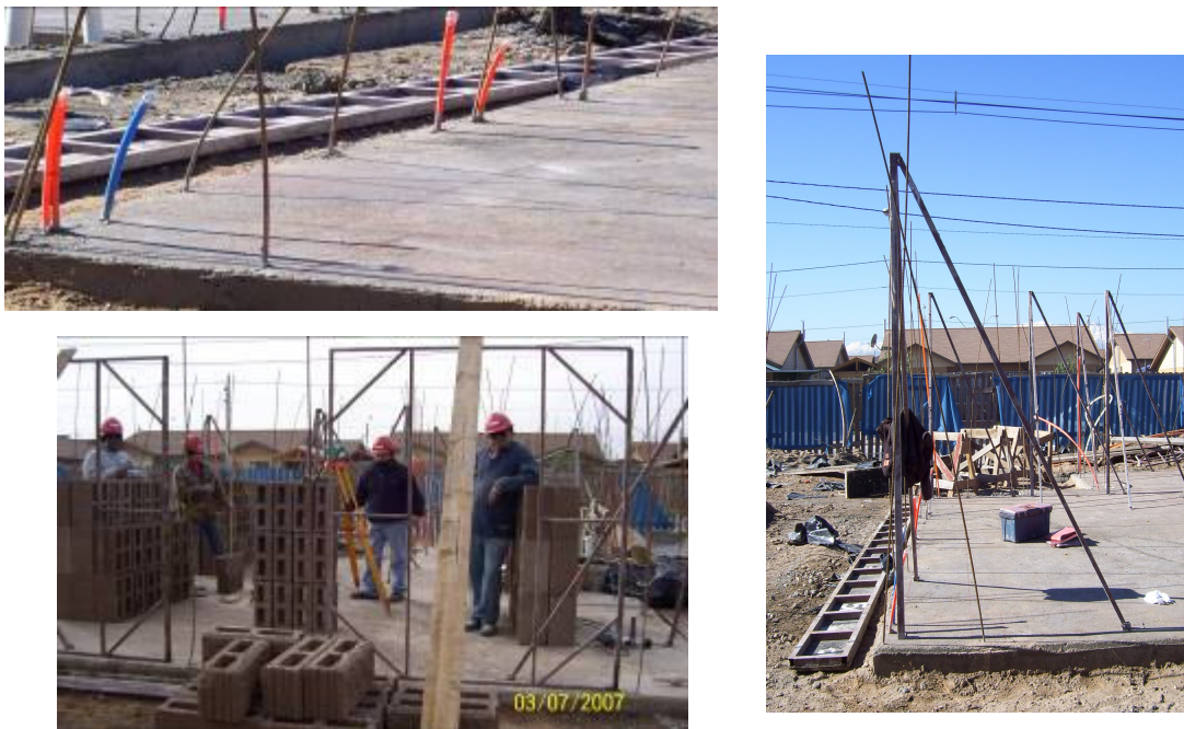
Figura N° 5: Trazado e instalación de escantillones y premarcos de rasgos de puertas y ventanales.
