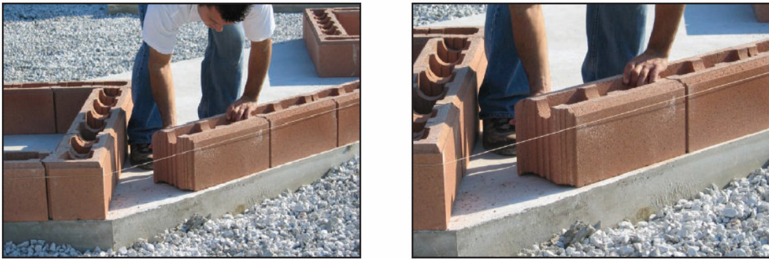
Figura N° 34: Prueba de calce de bloques.
