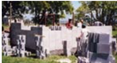
Imágenes del procedimiento constructivo utilizando el sistema de bloques Sparlock.
