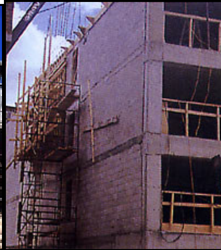
Imágenes del procedimiento constructivo utilizando el sistema de bloques Haener.
