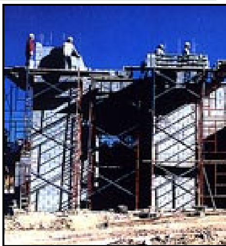
Imágenes del procedimiento constructivo utilizando el sistema de bloques Haener.
