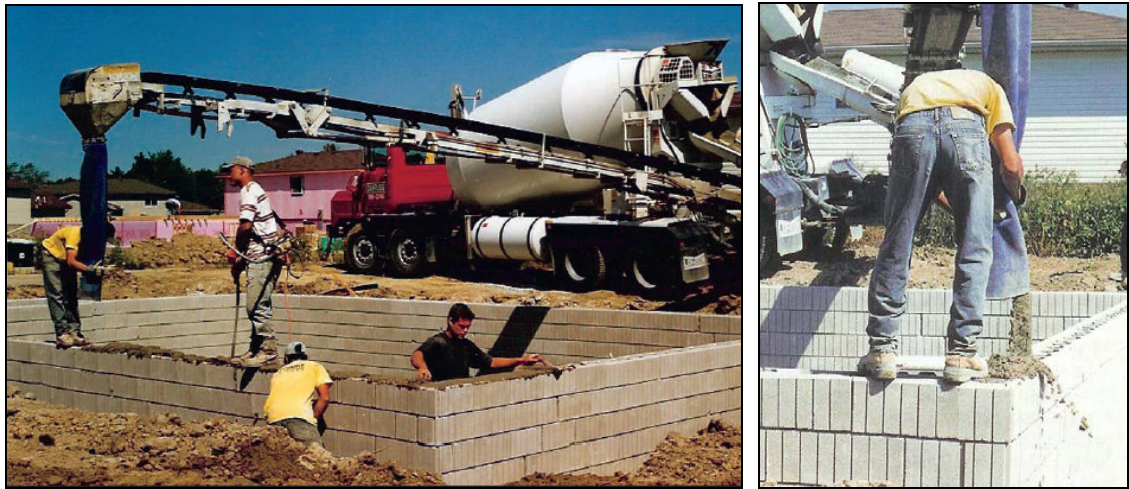
Figura N° 43: Relleno de muros mediante bombeo.
