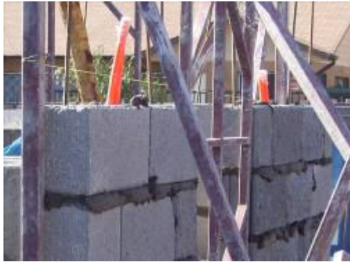
Figura N° 19: Colocación y posicionamiento de ductos y cañerías para instalaciones.
