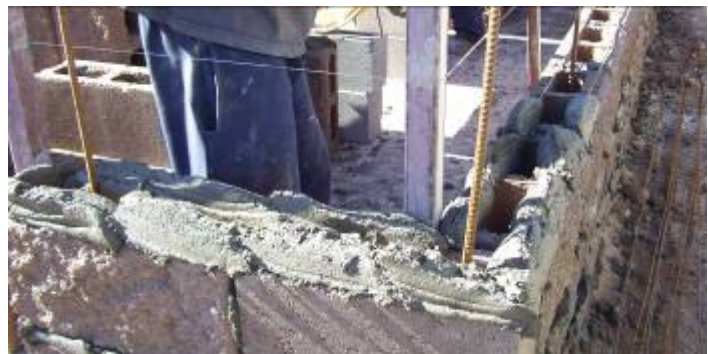
Figura N° 17: Colocación de escalerillas.
