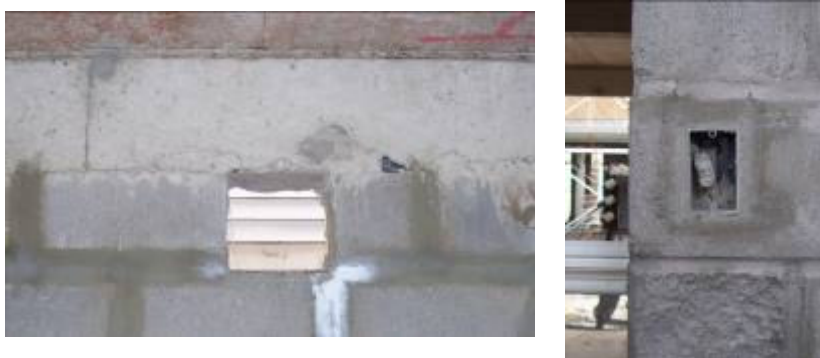
Figura N° 20: Ejemplos de conexiones exteriores.
