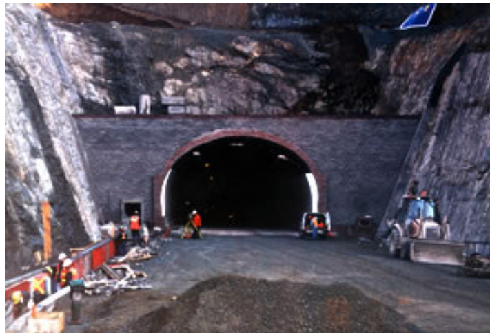
Túnel Lo Prado, año 2001.
