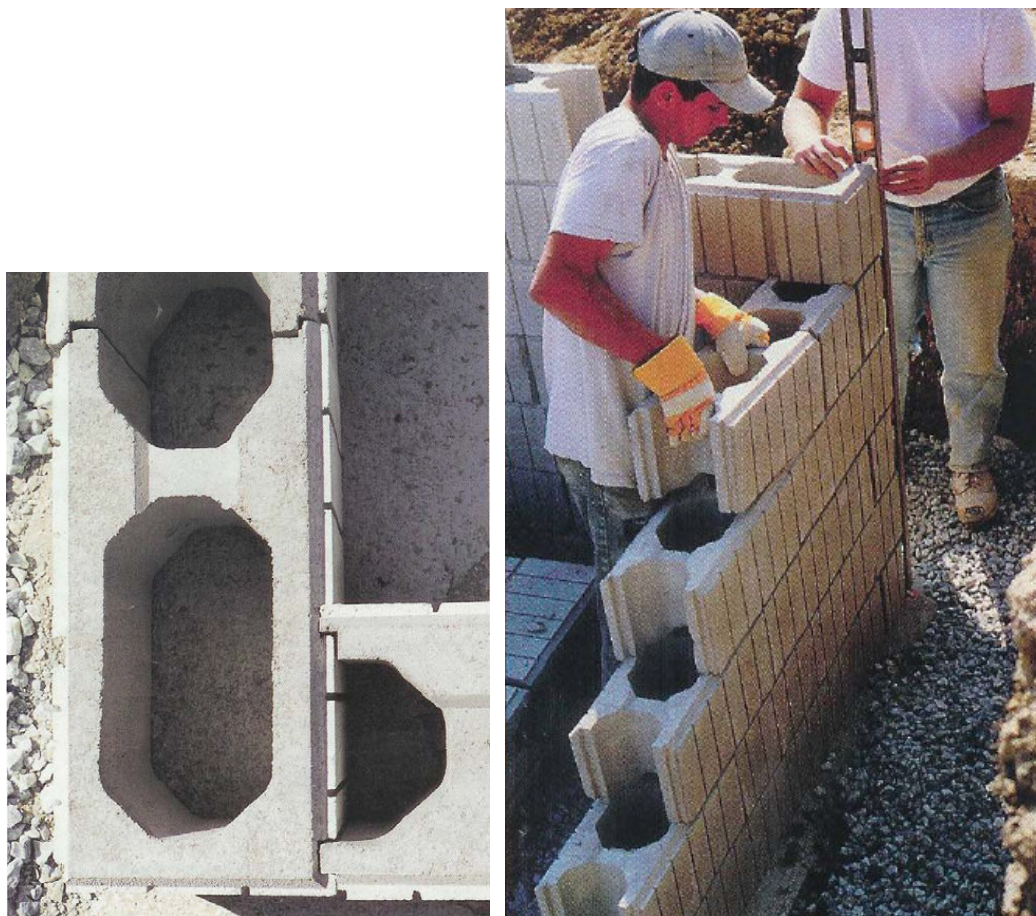
Figura N° 37: Colocación de las primeras unidades comenzando por las esquinas.
