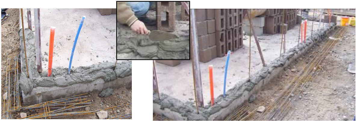
Figura N° 8: Colocación de mortero de junta sobre el cimiento.
