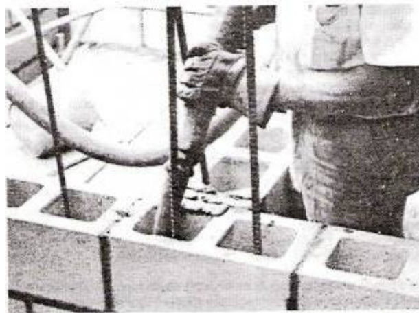
Figura N° 22: Llenado de pilares mediante bombeo.
