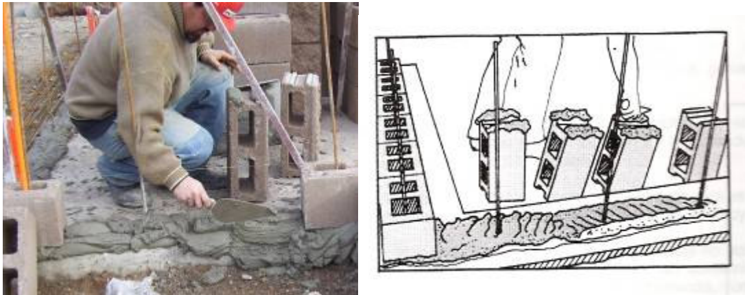
Figura N° 10: Esparcido de mortero en las caras laterales de los bloques.
