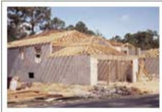
Imágenes del procedimiento constructivo utilizando el sistema de bloques Sparlock.
