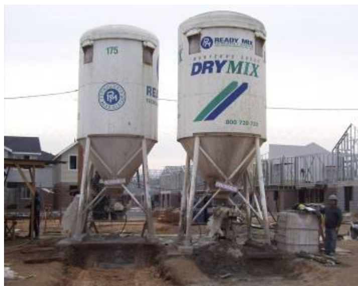
Figura N° 1: Silos de mortero y hormigón de relleno (grouting) presentes en obra.
