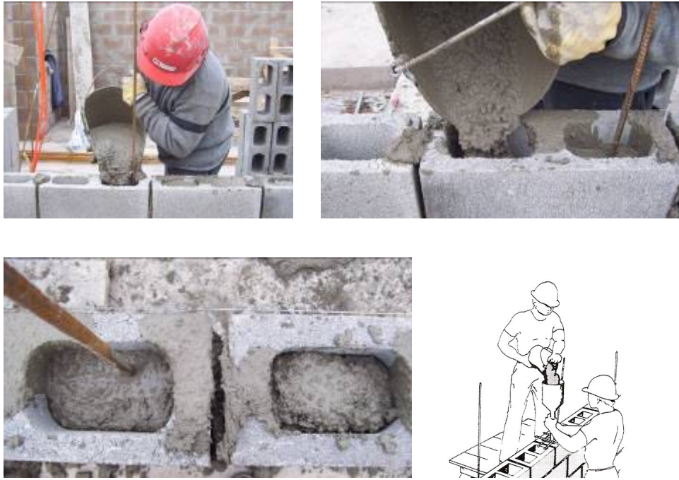
Figura N° 21: Llenado de pilares mediante embudo o manga.
