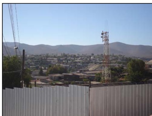
Depósitos de residuos mineros dentro de la ciudad de Andacollo”, IV Región
