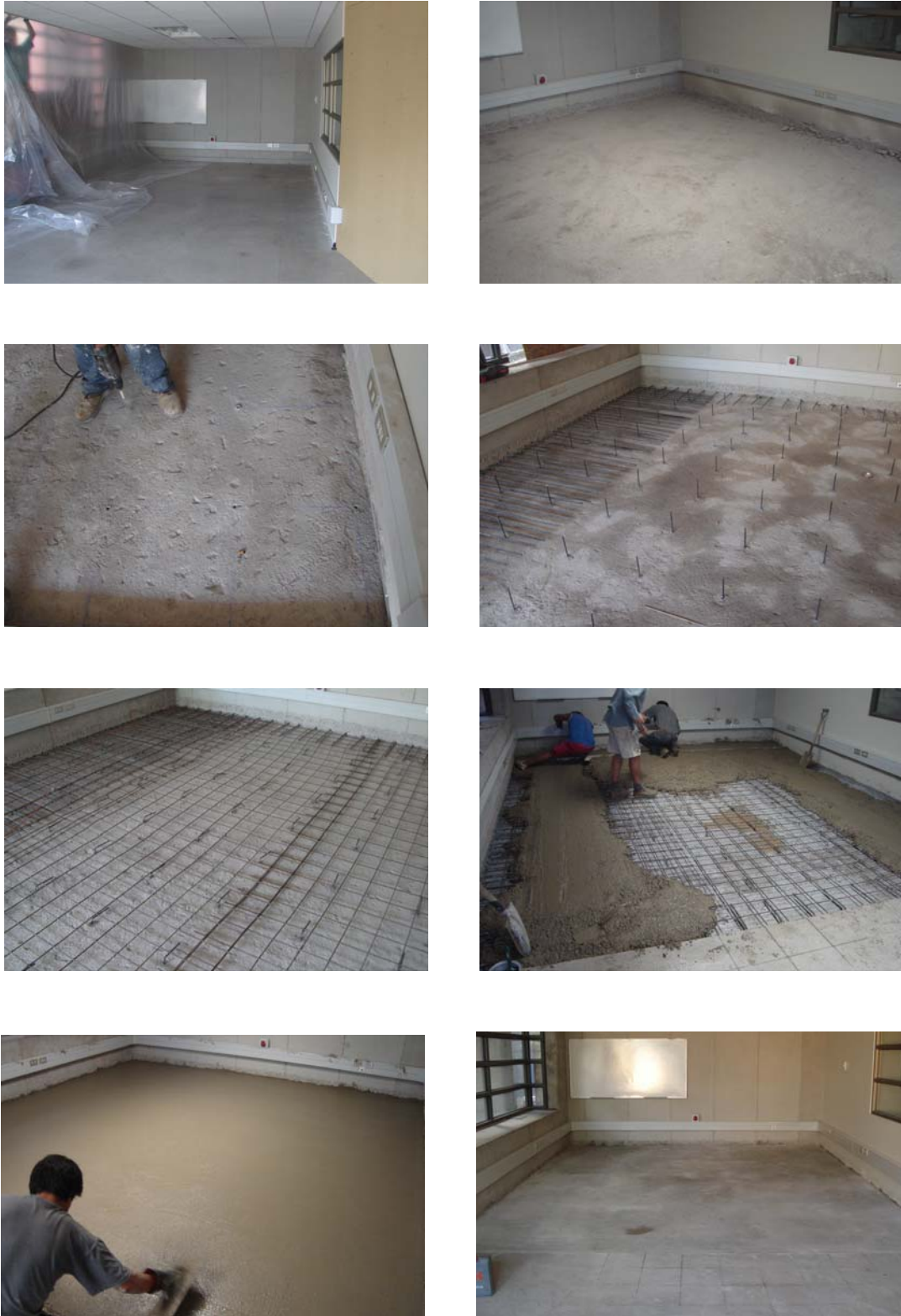
Figura B-2: Construcción refuerzo losa.
