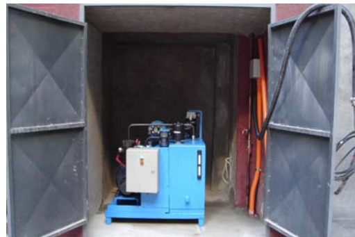
Figura B-3: Central Oleohidráulica.
