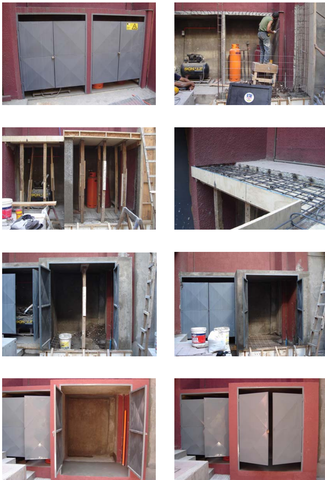
Figura B-1: Construcción ampliación caseta.
