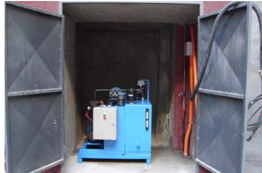
Figura 5-15: Central Oleohidráulica.
