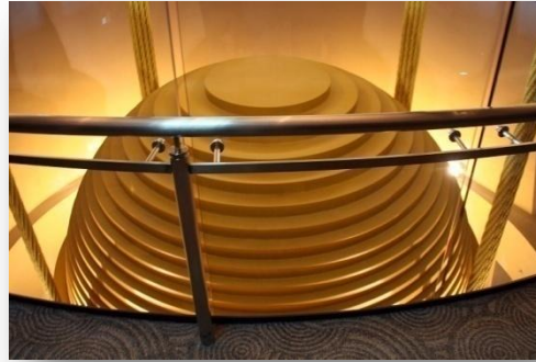
Figura 10. Amortiguador de masa sintonizada.
