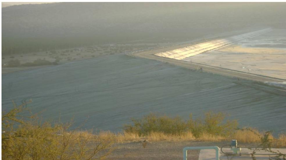
**Fig.1. 1: Embalse Ovejera: Muro de arenas y deposición de lamas.**
