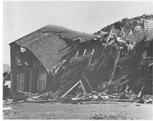
Daño en casa ubicada al pie de una zona de deslizamiento. (Dobrovlny et al., 1963)
