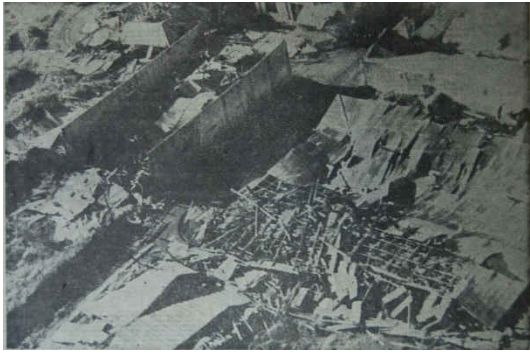
Edificio se ve totalmente derruido. Sólo quedaron en pie dos murallas laterales. (Fuente: El Mercurio)
