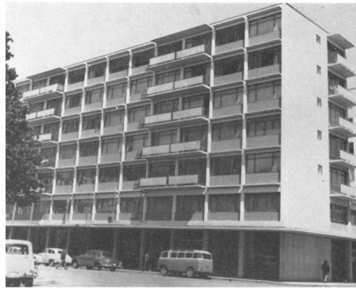
Edificio Prales (Steinbrugge and Flores, 1963)
