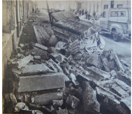
Una calle de Concepción, después de los dos terremotos. (Fuente: Revista Zig Zag)
