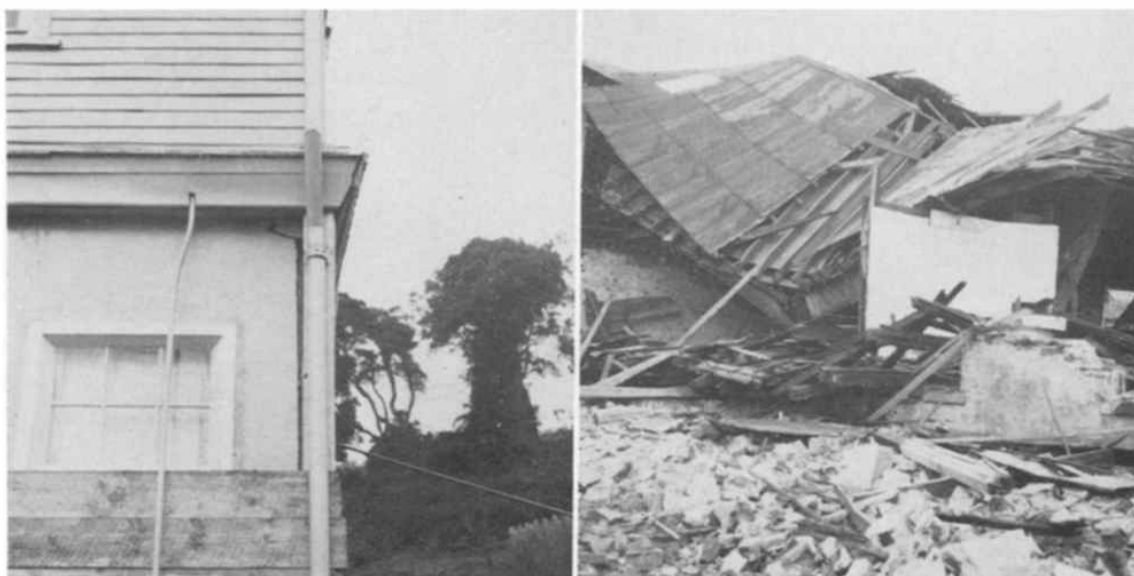
IZQUIERDA: Casa del administrador de la compañía carbonífera Victoria. DERECHA: Colapso escuela N°22, edificio de albañilería sin refuerzo.
