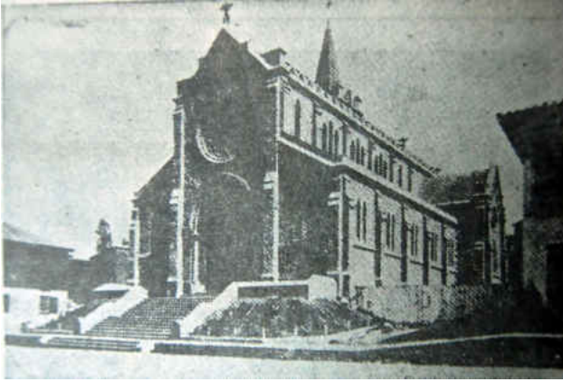
Parroquia de San Matías Apostol en Lota Alto (construida en 1928) antes del terremoto del 21 de mayo. Solo la torre quedó seriamente dañada. (Fuente: El Sur)
