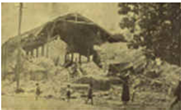
Iglesia de Bulnes luego del terremoto de 1939.
