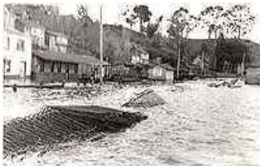
Figura 6.49. Daños en la ciudad de Castro.
