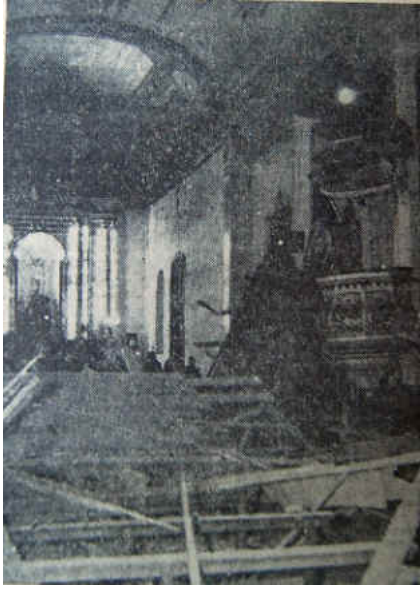
Estado en que quedó el interior de la Catedral de Los Ángeles. (Fuente: La Unión)
