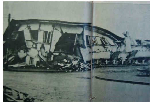
Estado en que quedó el edificio de hormigón armado de la Gobernación de Río Negro. En él funcionaban siete servicios públicos: Gobernación, Correos y Telégrafos, Tesorería, Gabinete de Identificación, Inspección Escolar, Dirección de Obras Sanitarias, Registro Civil y Juzgado del Crimen. (Fuente: Revista Zig Zag)
