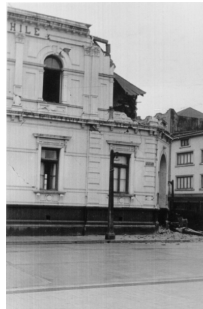
Figura 6.30. Daños en el edificio del Banco de Chile (Foto cortesía de E. Kausel)
