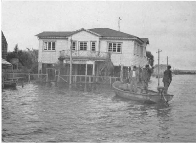
Figura 6.70. Vivienda inundada por subida del nivel de agua. (Sievers, Villegas, Barros, 1963)
