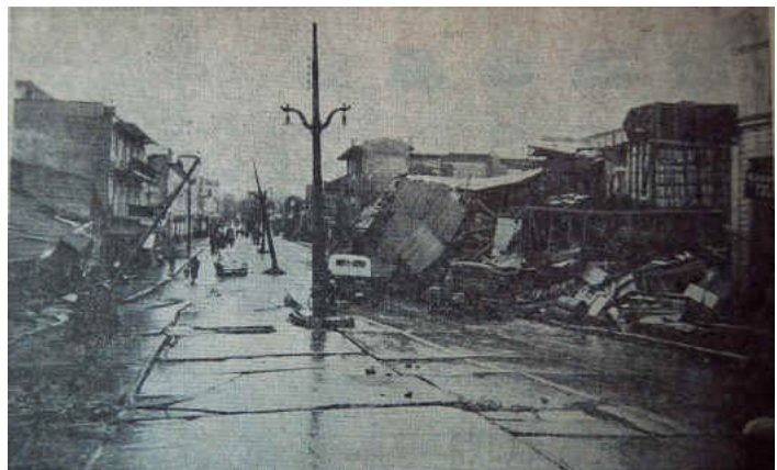
Calle Picarte, el pavimento se abrió en varios puntos, los postes quedaron inclinados. (Fuente: El Mercurio)
