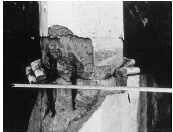
Daño en la base de un faro bocina. (foto cortesía E. Kausel)
