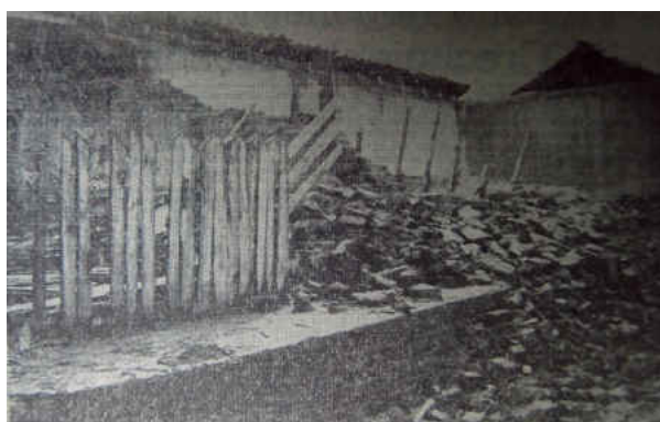
Forma en que quedó destruida una construcción de ladrillos y barro en la ciudad de Nacimiento. (Fuente: El Mercurio)
