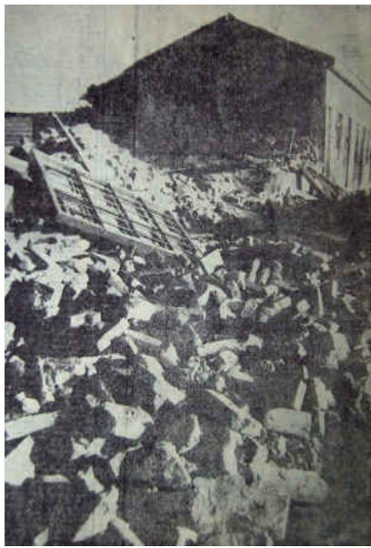
Una inmensa cantidad de piedras y ladrillos muestran cómo se derrumbó y desintegró esta casa después del terremoto del día 21 de mayo. La puerta que se ve sobre el hacinamiento, pertenecía a un segundo piso. La habitación vecina resistió a medias. (Fuente: La Unión)
