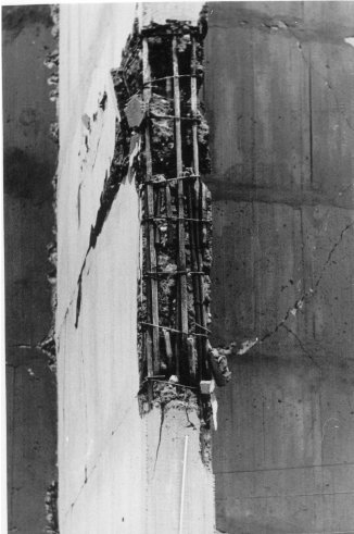
Figura 6.35. Daños en un estanque de agua de hormigón armado (Foto cortesía de E. Kausel)
