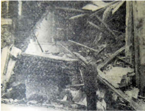
Colapso de un edificio de Los Ángeles. (Fuente: La Unión)
