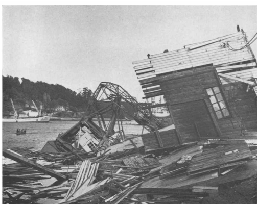
Daños en las grúas. (Dobrovoly et al., 1963)
