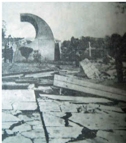
Pavimentos de sector de la Plaza de Puerto Montt. Se ve el busto de Prat semienterrado. (Fuente: La Unión)
