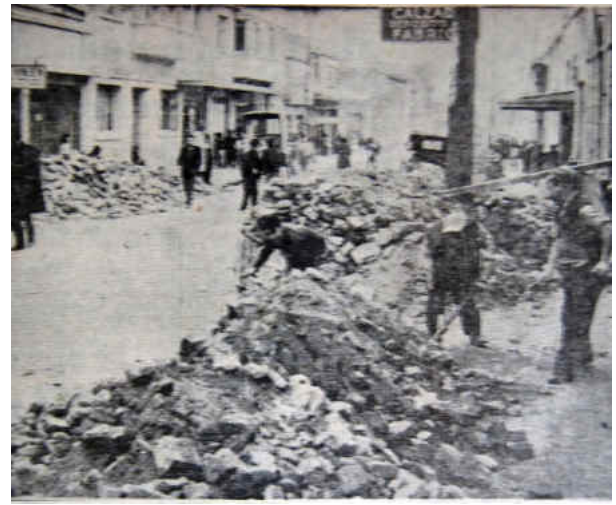
Trabajo de remoción de escombros en Colo Colo esquina Freire, frente al diario "El Sur". (Fuente: El Sur)
