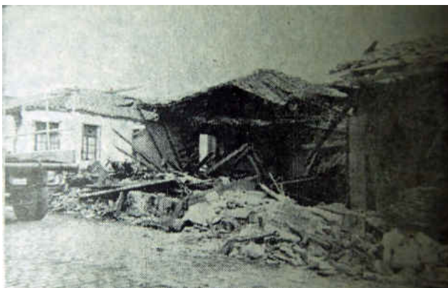
Daños en viviendas. (Fuente: El Sur)
