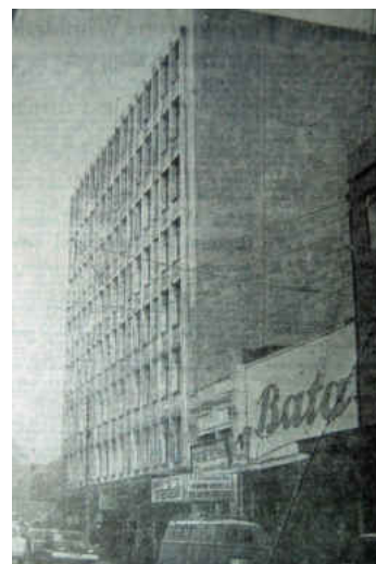
El edificio Aníbal Pinto, ubicado en la calle del mismo nombre, era un moderno edificio de 8 pisos y de construcción compuesta de hormigón armado y albañilería reforzada. Resistió el terremoto del 21 de mayo. Fue entregado el año 1957. (Fuente: El Sur)
