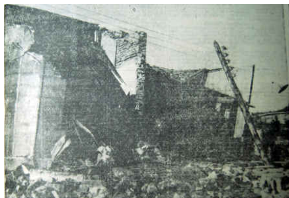
Derrumbe de la marquesina de la Tienda “La Gran Vía”, en el centro de Concepción. (Fuente: La Unión)
