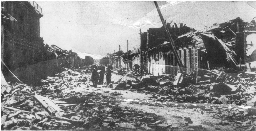
Figura 4.10. Daños en Chillán (Foto cortesía de E. Kausel).
