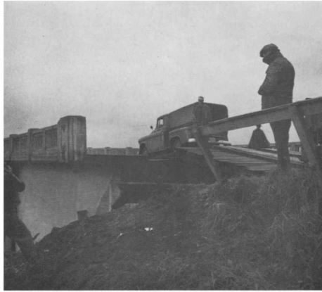
Figura 6.34. Vista del terraplén de acceso del lado de la isla Teja. Puente Pedro de Valdivia (Álvarez, 1993).
