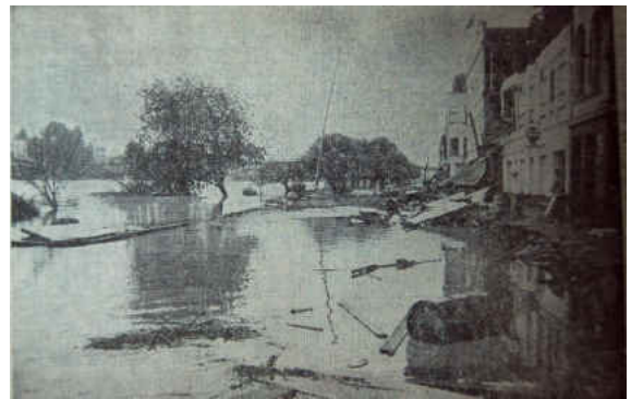
El grabado muestra, en primer plano, la ex Avenida Costanera y el lugar en que se encontraba el embarcadero que se empleaba para ir hasta Corral, cubiertos por el agua. (Fuente: El Mercurio)
