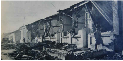
Calle en ruinas en Concepción. (Fuente: Revista Vea)
