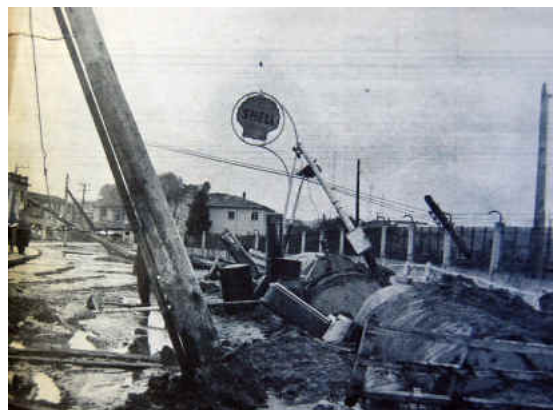
Levantamiento de los estanques de bencina enterrados. (Fuente: Revista Vea)
