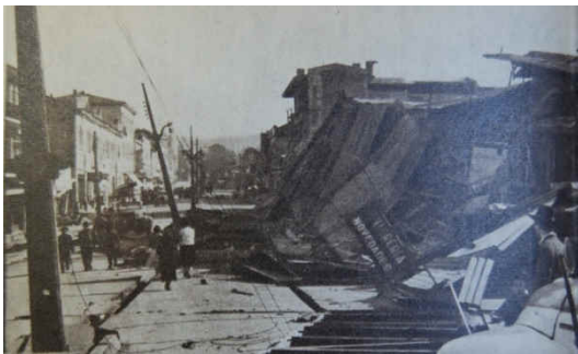
La calle Picarte, centro comercial de Valdivia. Al momento de tomar esta fotografía, los escombros ya habían sido despejados. (Fuente: Revista Zig Zag)
