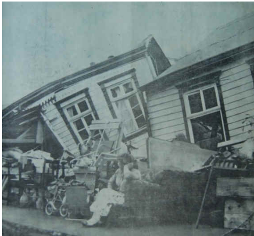
Vivienda dañada. (Fuente: La Unión)
