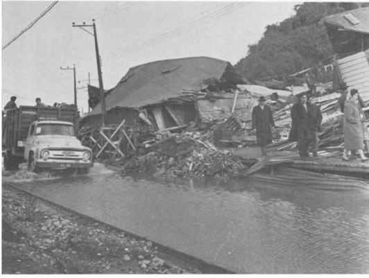
Daños cerca del sector de Angelmó. (Dobrovlny et al., 1963)
