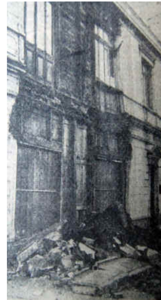
Edificio antiguo del centro de Temuco despojado del revestimiento de su fachada. (Fuente: La Unión)
