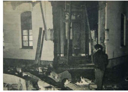
Vivienda destruida. (Fuente: Revista Ercilla)
