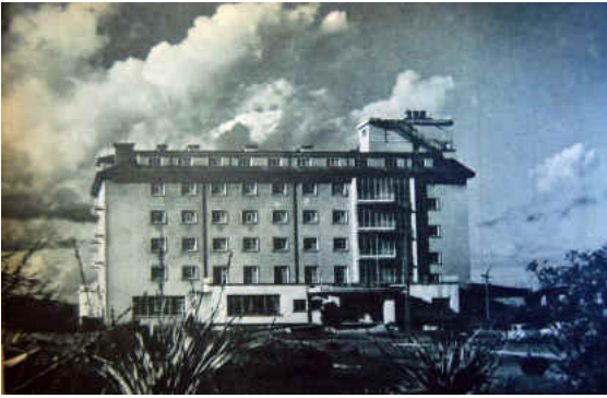
Hotel "Pedro de Valdivia". No sufrió daño alguno. (Fuente: Revista Zig Zag )
