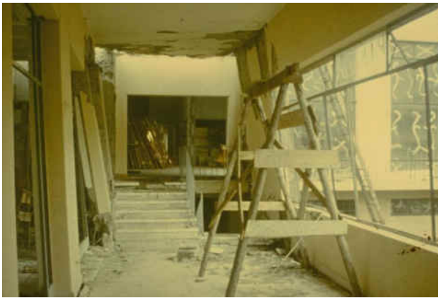
Hotel en reparaciones
