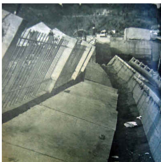
A la derecha, el molo nuevo de Puerto Montt. Los enormes bloques de concreto quedaron en medio del canal Tenglo. (Fuente: Revista Zig Zag)
