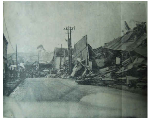
Vista de viviendas dañadas. (Fuente: La Unión)
