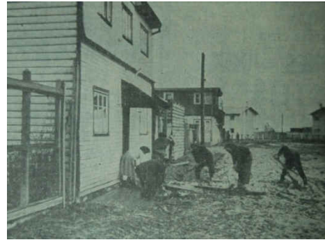
Habitantes se dedican a eliminar el barro de las casas, aceras y calles en la Población Arica de la ciudad de Valdivia. (Fuente: El Mercurio)
