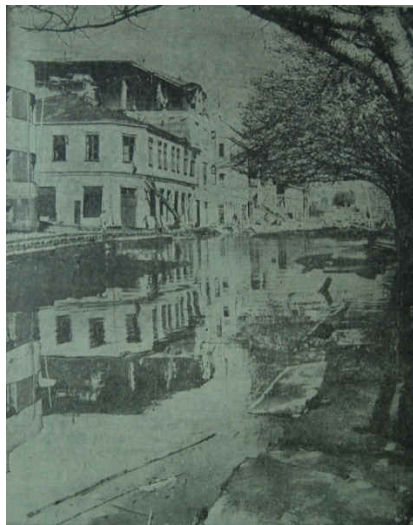
La Costanera de Valdivia. Pueden verse los efectos del terremoto y de la inundación. (Fuente: El Mercurio)
