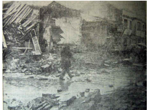
Casas destruidas en Calle Maipú, entre Colo Colo y Castellón. (Fuente: El Sur)
