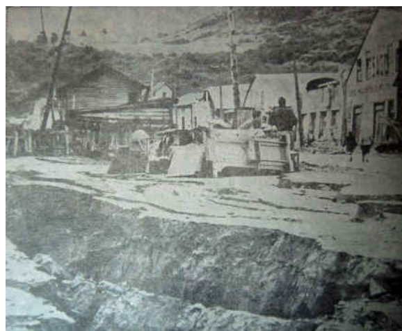
Grietas del terreno a lo largo de los caminos. (Fuente: El Sur)
