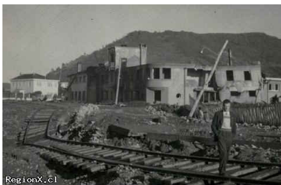
Daños de las líneas ferreas. (Fuente: Internet)
