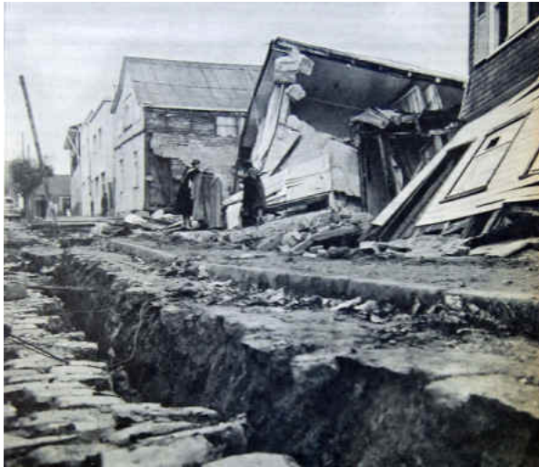
Grietas en las calles de Valdivia. La foto muestra las casas derrumbadas junto a un ancho tajo abierto en la calle. (Fuente: Revista Vea)
