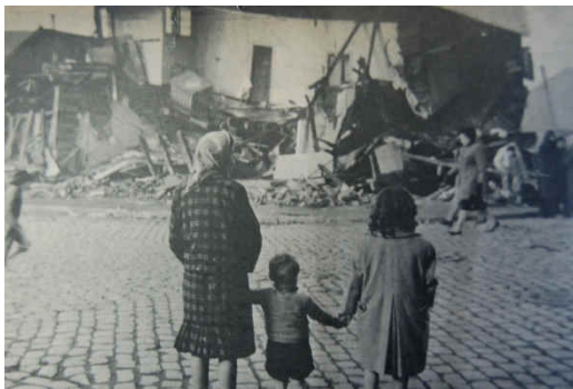
Casa destruida con los terremotos en Arauco. (Fuente: Revista Vea)
