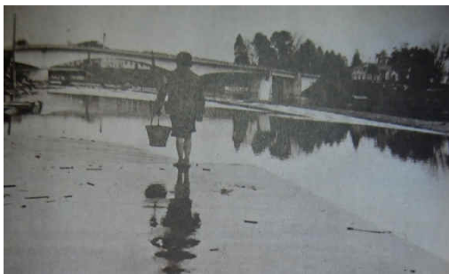
Vista de la costanera con el puente Pedro de Valdivia al fondo; el pavimento está bajo las aguas. (Fuente: Revista Zig Zag)
