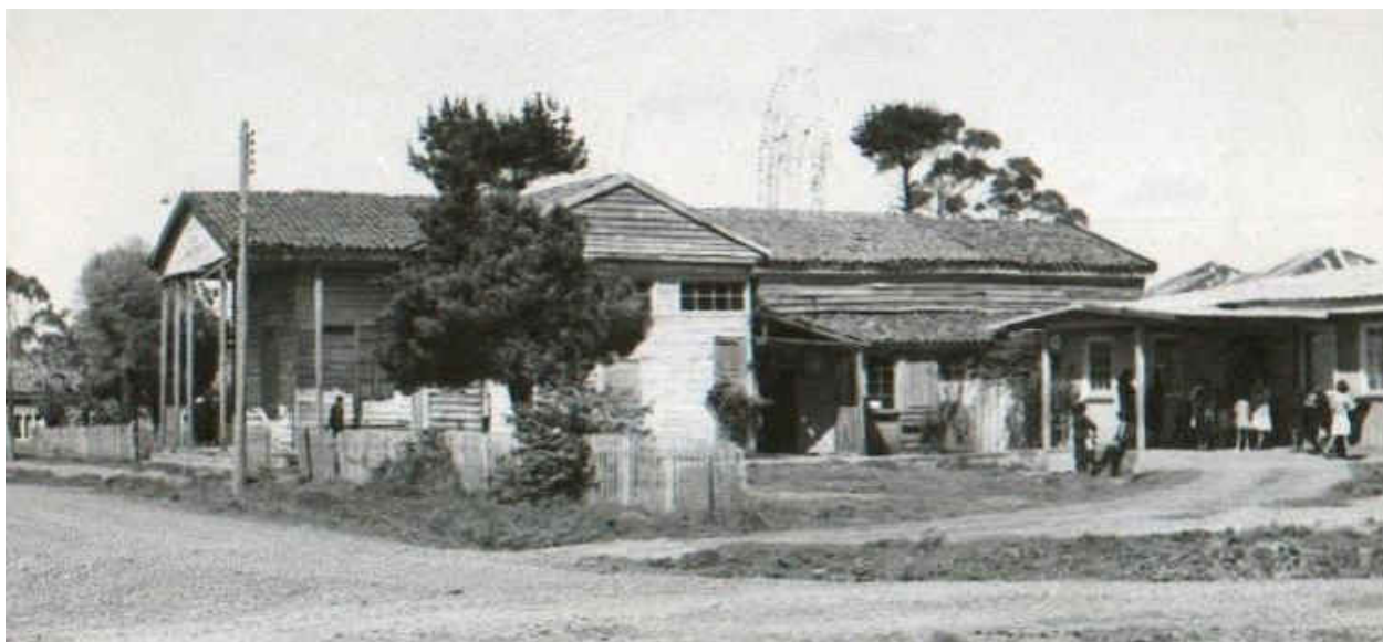
Figura 4.8. Techumbre de tejas en construcción de madera. Hospital antiguo de Cañete. (Fuente: www.miguelgonzalez.cl/fotos ).
