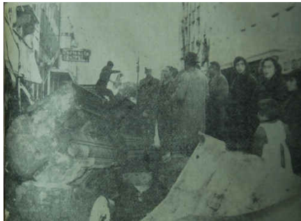
Esta inmensa cornisa de hormigón se desprendió de un edificio de la calle Aníbal Pinto y causó tres víctimas. (Fuente: La Unión)
