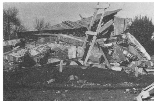
Colapso de escuela de dos pisos. (Steinbrugge and Flores, 1963)
