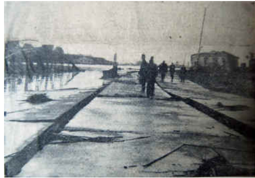
Grietas separaron el pavimento de la Avenida Costanera de Valdivia (Fuente: La Unión)
