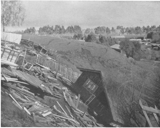
Deslizamiento de talud. (Duke y Leeds, 1963)
