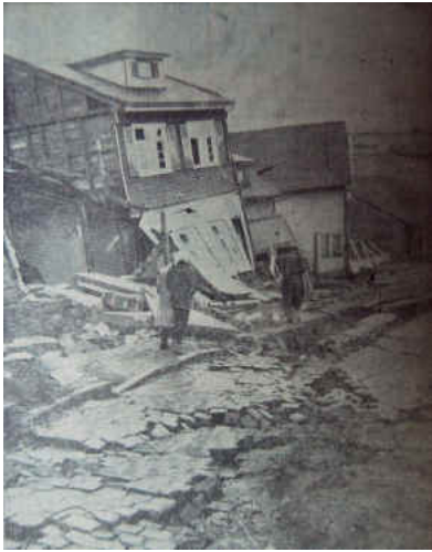
Ruinas en la ciudad de Valdivia. El terremoto abrió profundas grietas en las calles de Valdivia. (Fuente: El Sur)
