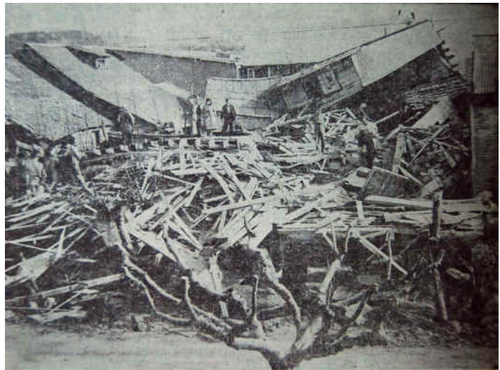
En el centro de la ciudad se desplomó un edificio de uso comercial de tres pisos colapsado (Fuente: El Mercurio).
