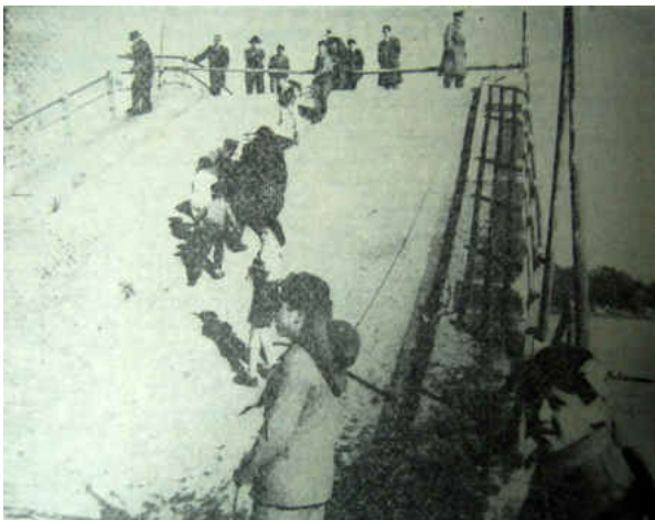
Para atravesar el Bío Bío usando el puente parcialmente derrumbado, había que hacer proezas de andinista ayudado por un cable desde arriba, como se ve en la fotografía. (Fuente: La Unión)
