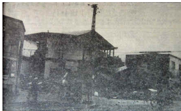
Casa esquina de la calle Ongolmo desmoronada completamente. (Fuente: El Mercurio)
