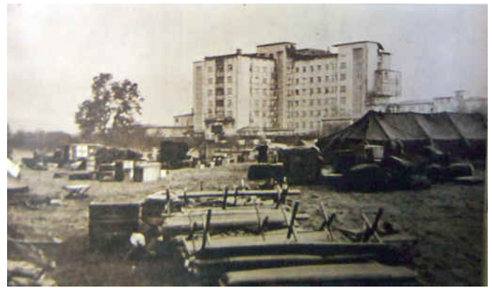
El moderno Hospital Regional de Valdivia. Sufrió daños irreparables y fue evacuado. En primer plano, el hospital de emergencia instalado con ayuda norteamericana. (Fuente: Revista Zig Zag)
