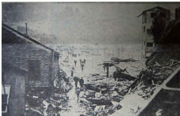
El edificio donde funcionaba la fábrica de calzados Rudloff, puede verse totalmente destruido por los terremotos y maremotos. (Fuente: El Mercurio )
