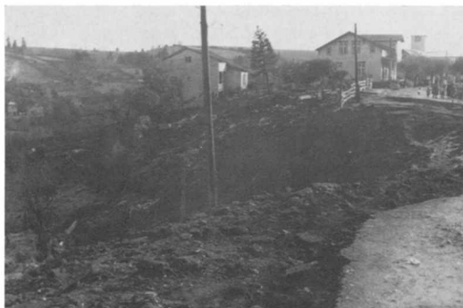
Vista de un deslizamiento en Río Negro. (Thomas et al., 1963)
