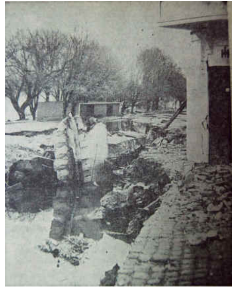
Hundimientos en la costanera de Valdivia. (Fuente: El Mercurio)
