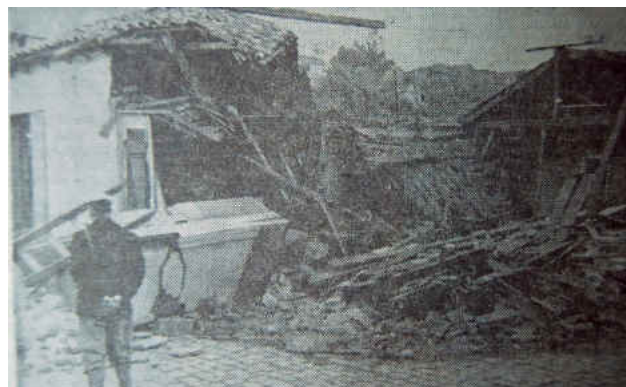
Edificio destruido en la calle Valdivia. (Fuente: El Sur)
