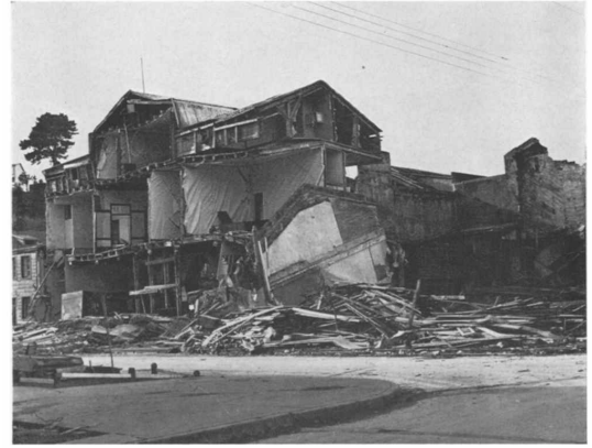
Daños en un banco, banco (Dobrovohny et al, 1963).
