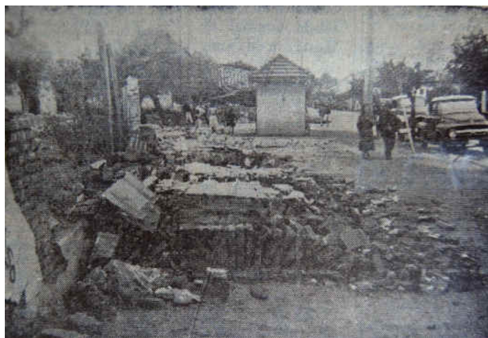
Figura 6.3. Derrumbes en Angol en la Avenida Bernardo O'Higgins. (Fuente: El Sur)
