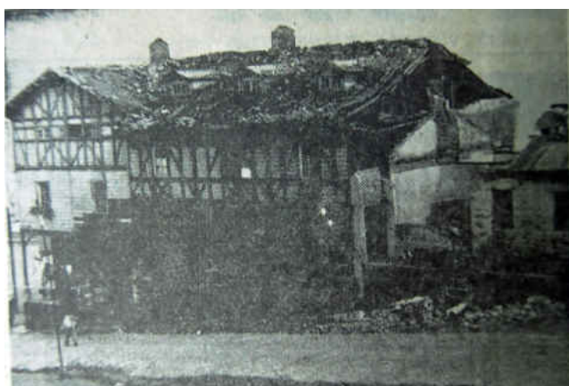
Daño en vivienda de Lota Alto que debió ser demolida. (Fuente: El Sur)
