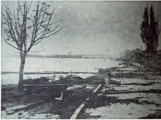
La costanera valdiviana. Aspecto de calle Prat; se puede apreciar el hundimiento de esa avenida ribereña, como resultado de lo cual las aguas del Calle Calle inundan varios puntos de la ciudad. (Fuente: El Mercurio)
