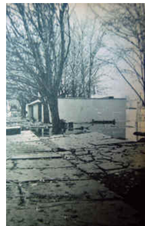
Estado de la Avenida Costanera, o Prat, de Valdivia. El pabellón de turismo se ve hundido hasta la mitad. (Fuente: Revista Zig Zag)
