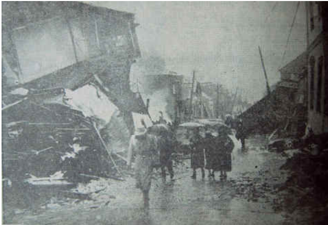
Calle Camilo Henríquez. En esta vista, se puede verificar el estado en que quedó la Confitería "Sur", y también el Centro de "Hijos de Chiloé". (Fuente: El Sur)
