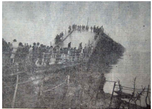
Destruída parte del puente al hundirse los pilotes que sostenían el puente carretero sobre el Bío Bío; 60 metros de la estructura quedaron inutilizados. De este modo, Concepción quedó aislada de Huachipato y Lota. (Fuente: El Mercurio)
