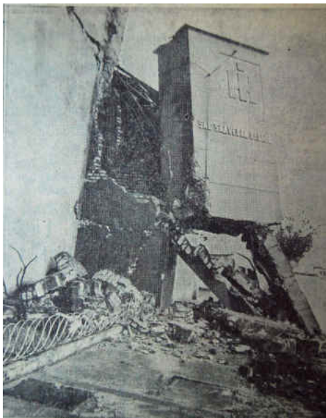
Estado en que quedaron las pilastras y la torre de cemento de la estación de servicio de la firma Saavedra Bernard. (Fuente: El Mercurio)
