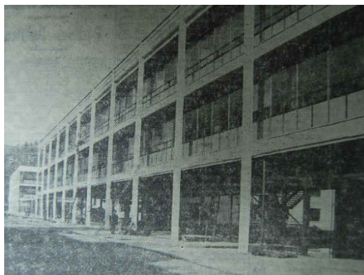
Edificio de la Facultad de Química de la Universidad de Concepción. La estructura de acero sufrió daños en las diagonales de arriostramiento. (Fuente: El Mercurio)
