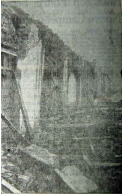
Estado de la Calle Los Carreras, entre Arturo Prat y Serrano, cuya edificación en su mayor parte había soportado ya el violento sismo de 1939. (Fuente: El Sur)
