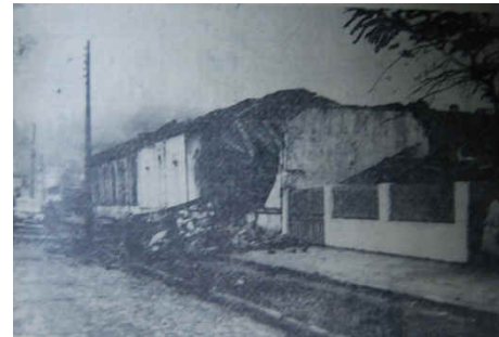
Casa derrumbada. (Fuente: La Unión)
