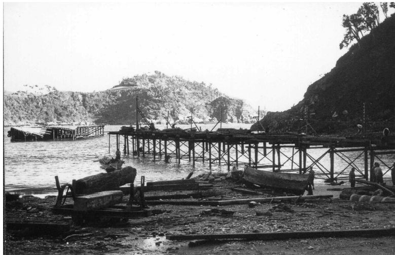
Figura 6.46. Daños en el muelle a raíz del maremoto. Una ola de 8 metros produjo el corte del muelle tal como se aprecia en la imagen. (Foto cortesía de E. Kausel)
