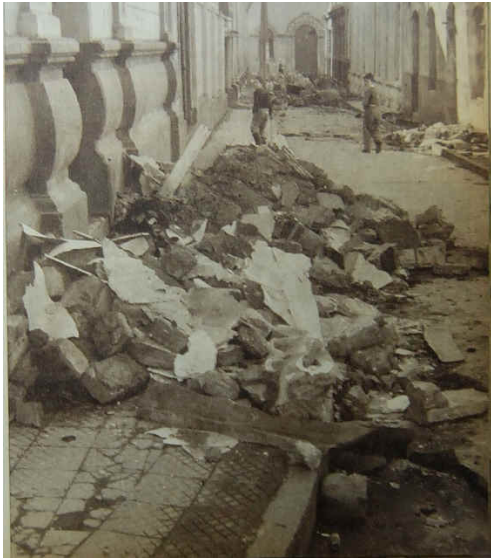
Escombros en las estrechas calles centrales de Talcahuano.
