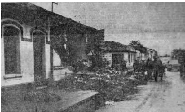
Derrumbe en casas de la calle Carrera. (Fuente: El Mercurio)
