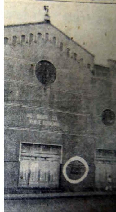
Figura 4.42. Daños en la Catedral de Los Ángeles.
