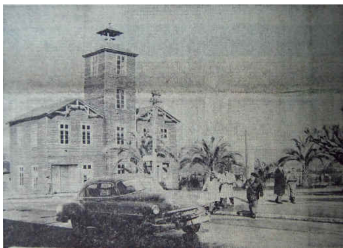
Figura 6.6. Daños de mediana consideración en el Cuartel de Bomberos, edificio construido de madera y ubicado en la Plaza de Loncoche.
