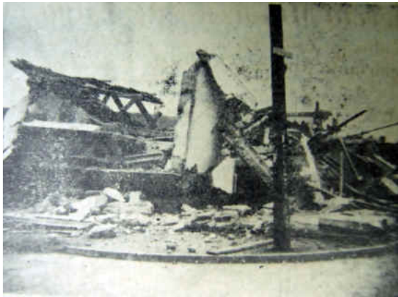
Estado en que quedó la Municipalidad de Río Negro. (Fuente: La Unión)
