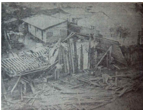
Una vivienda en el suelo, se observa la techumbre de la casa, totalmente hundida. Escenas como ésta se observaban en todos los sectores de Concepción. (Fuente: El Mercurio)
