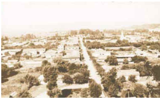
Vista de Arauco desde el Cerro Colo-Colo antes de los terremotos. (Fuente: Internet)
