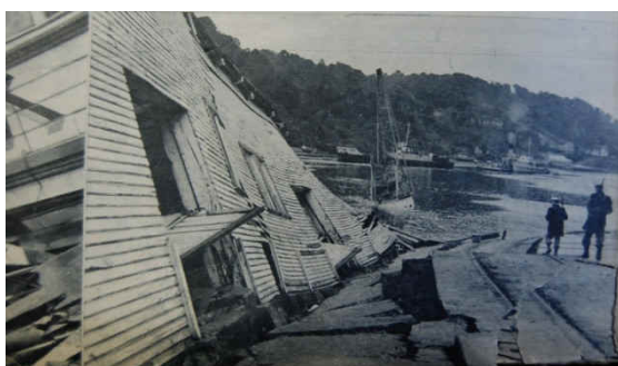
Colapso de los edificios de la Aduana. (Fuente: Revista Vea)
