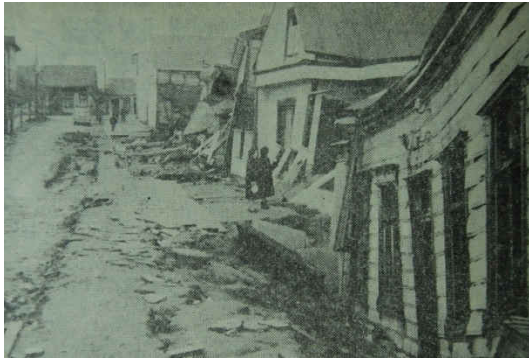
Hundimiento del terreno. En diversas ciudades de la zona devastada, se pueden apreciar fallas en el terreno de fundación, tales como la que se puede observar en la foto. La vista que se reproduce en la fotografía corresponde a una de las calles más dañadas de la ciudad de Valdivia (Fuente: El Mercurio)
