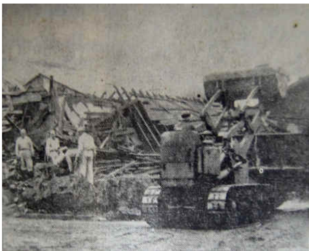
Mediante palas mecánicas, se procede a despejar la calle Colón, frente al antiguo edificio donde funcionaba el Correo de Talcahuano, que fue demolido. (Fuente: El Sur)
