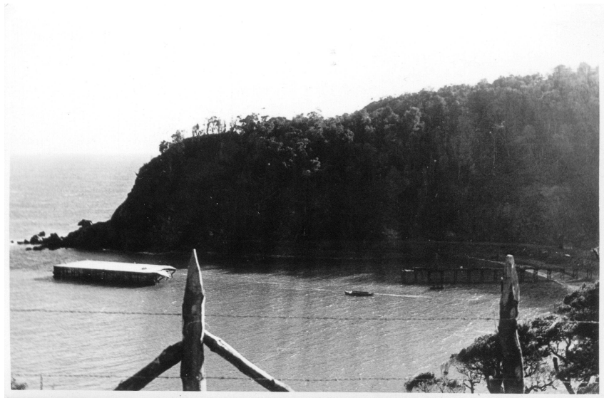
Figura 6.47. Vista del muelle de Bahía Mansa luego del maremoto.
