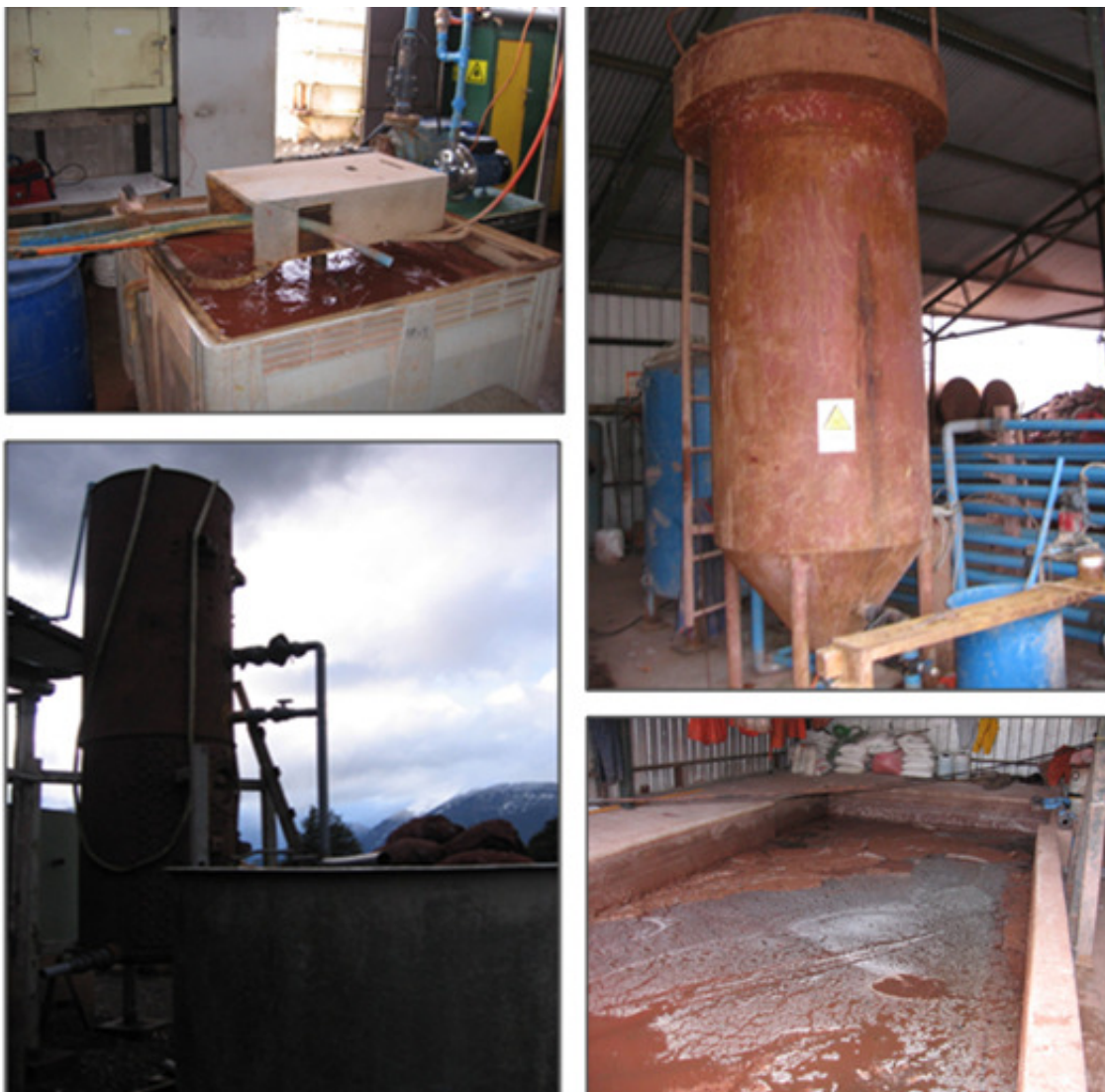
Ilustración 5: Imágenes (piscina de tratamiento de riles y torre de decantación): Izquierda taller de redes La Paloma, derecha taller de redes Vargas y Vargas
