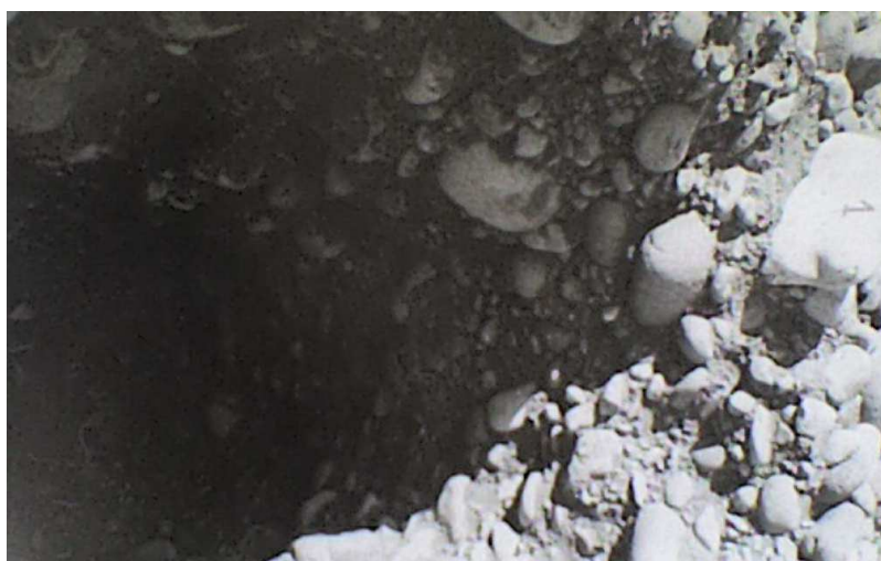
Figura 5.4: Foto de la excavación del Pozo N°1, año 1981
