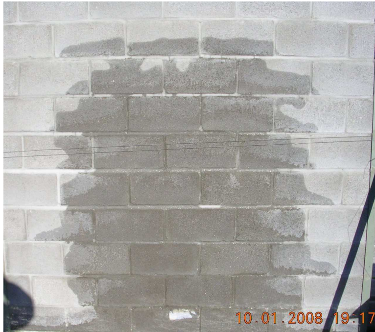
Fotografía 4.7: Muro 4 a 210 min de inicio de ensayo.
