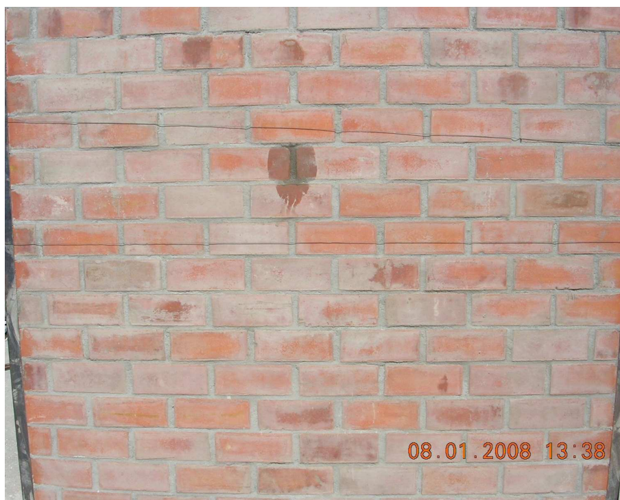
Fotografía 3.6: Muro 3 a 180 min de inicio de ensayo.
