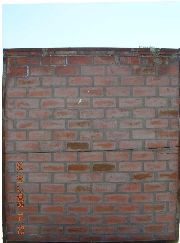
Fotografía 5.4: Muro 5 a 120 min de inicio de ensayo.
