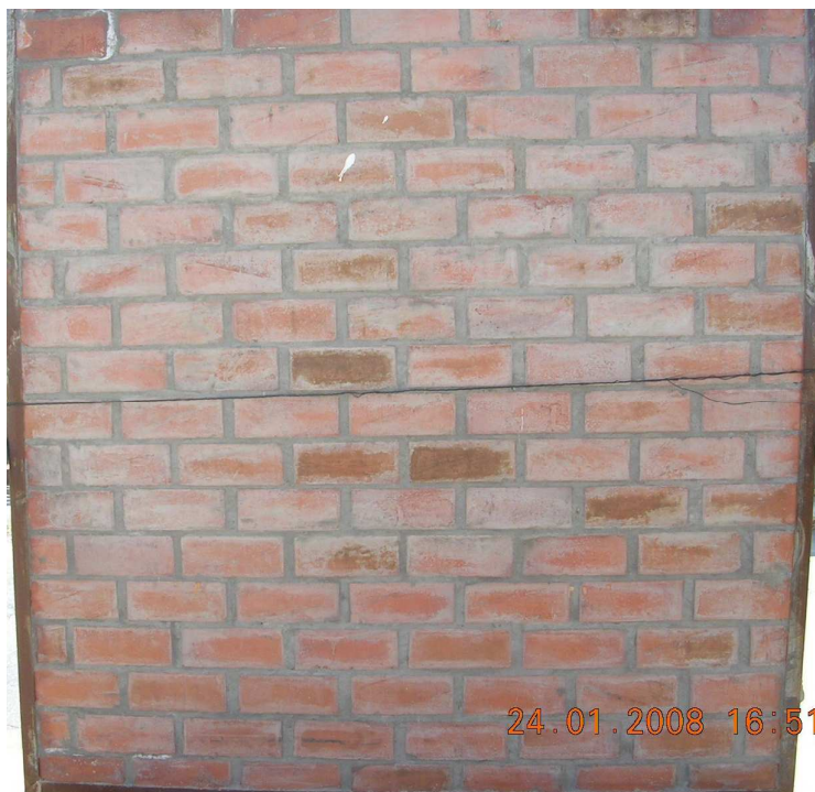
Fotografía 5.8: Muro 5 a 240 min de inicio de ensayo.
