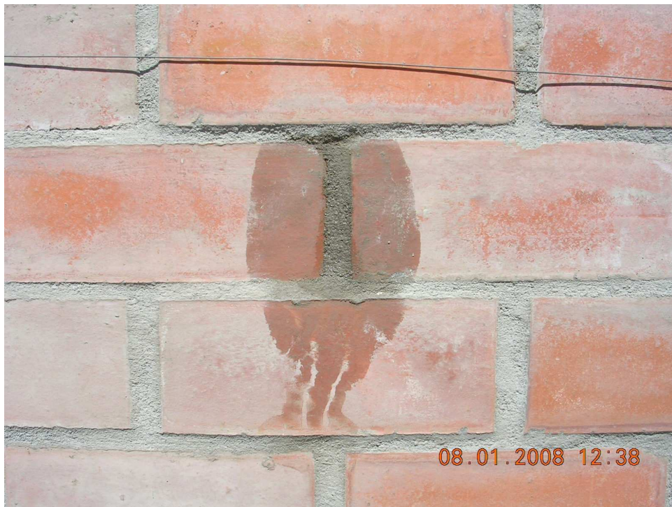
Fotografía 3.4: Muro 3 a 120 min de inicio de ensayo.
