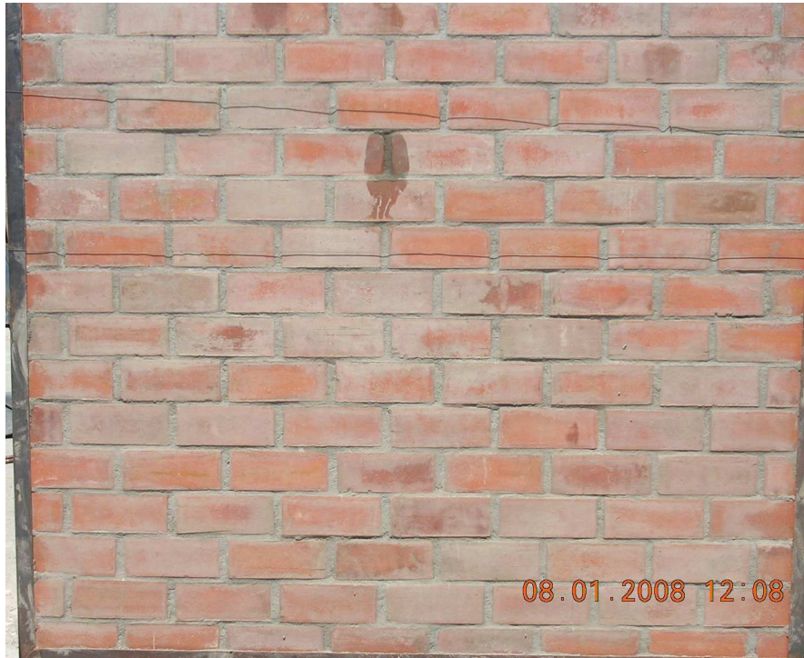
Fotografía 3.3: Muro 3 a 90 min de inicio de ensayo.
