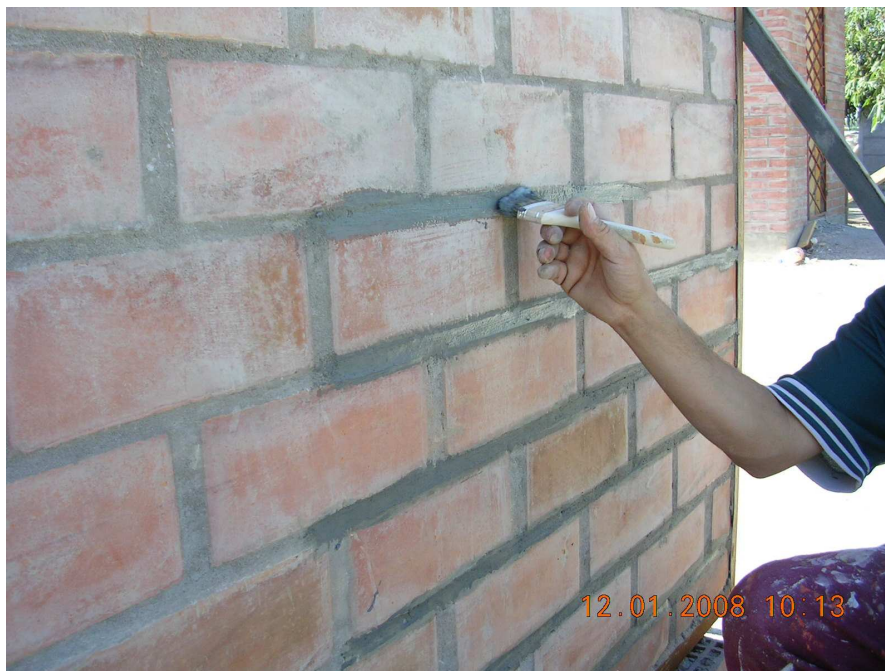
Fig.5.6.3 – Aplicación sellador de cantería
