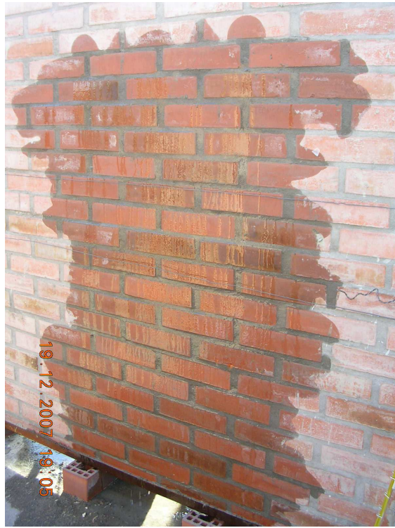
Fotografía 1.5: Muro 1 a 150 min de inicio de ensayo.
