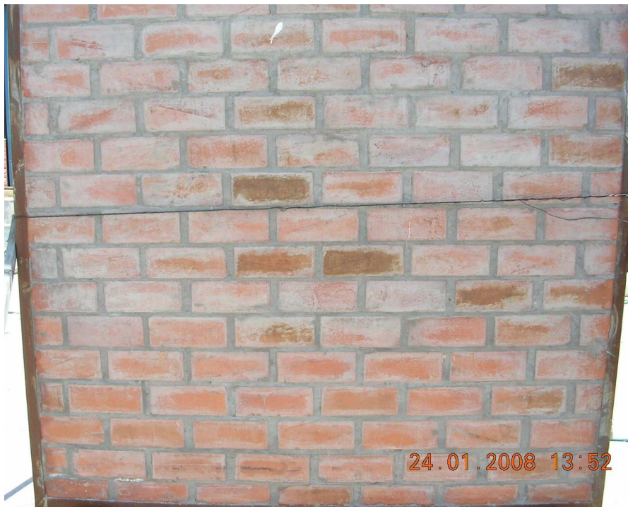
Fotografía 5.2: Muro 5 a 60 min de inicio de ensayo.
