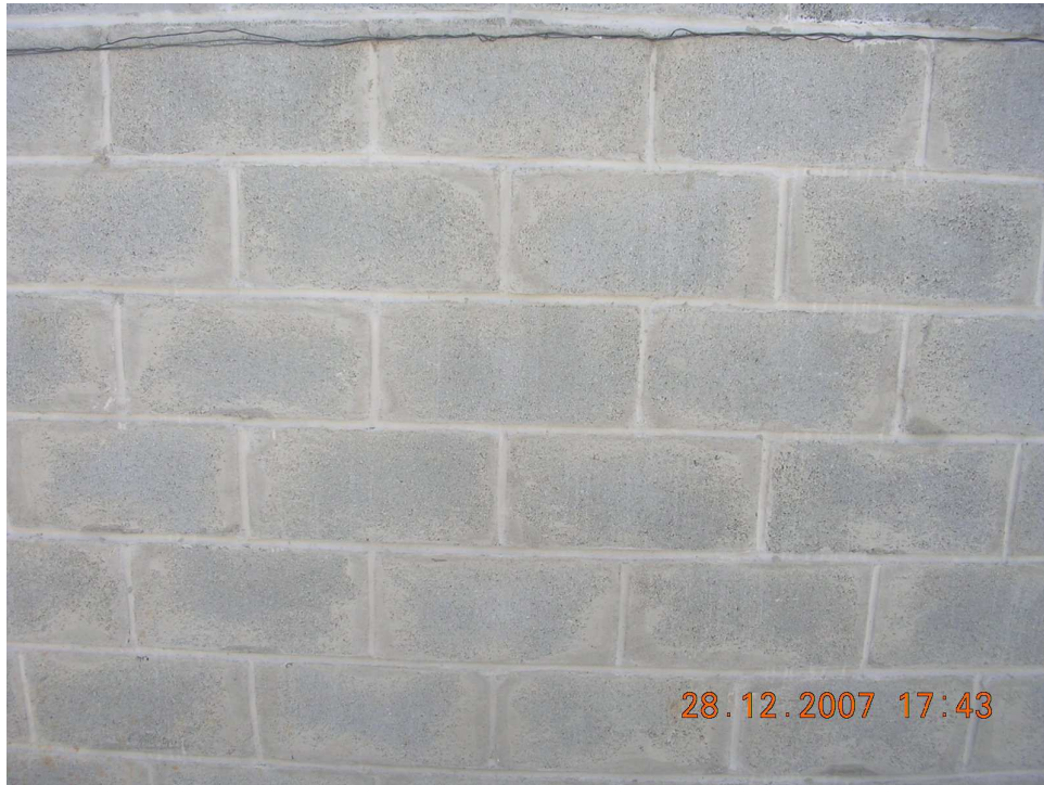
Fotografía 2.5: Muro 2 a 150 min de inicio de ensayo.
