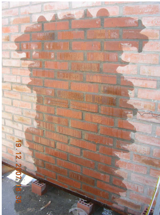
Fotografía 1.4: Muro 1 a 120 min de inicio de ensayo.
