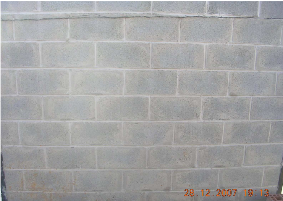
Fotografía 2.8: Muro 2 a 240 min de inicio de ensayo.
