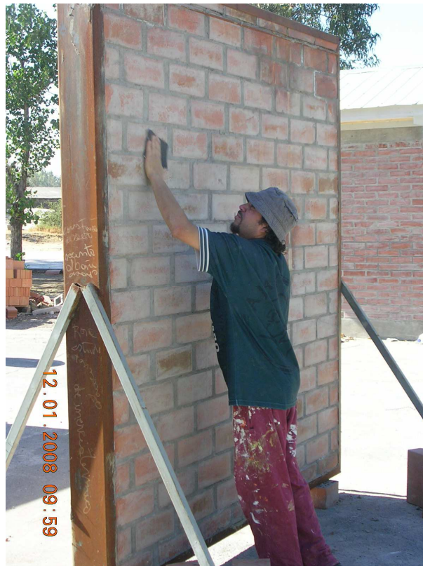
Fig.5.6.1 – Preparación de la superficie
