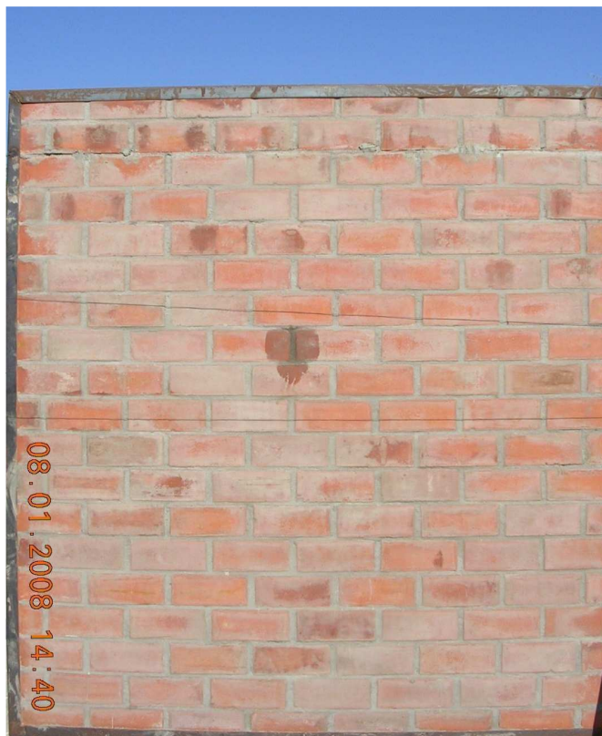
Fotografía 3.8: Muro 3 a 240 min de inicio de ensayo.
