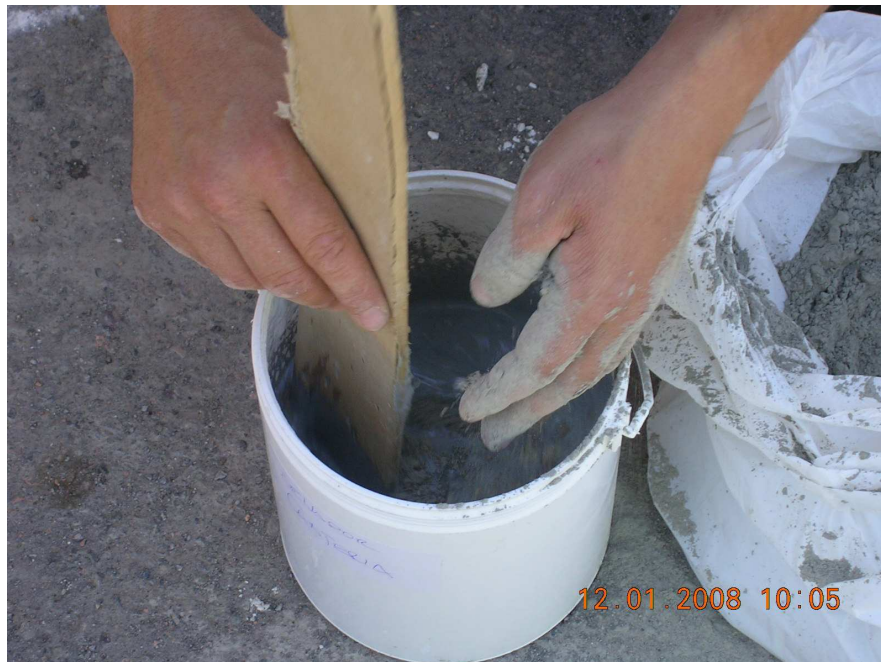
Fig.5.6.2 – Preparación sellador de cantería
