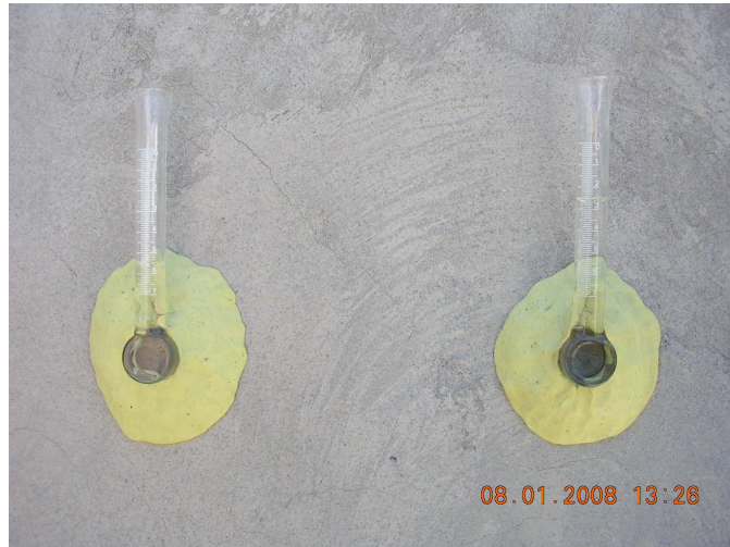
Fig.3.2.3 – Pipetas en muro de ladrillo estucado
