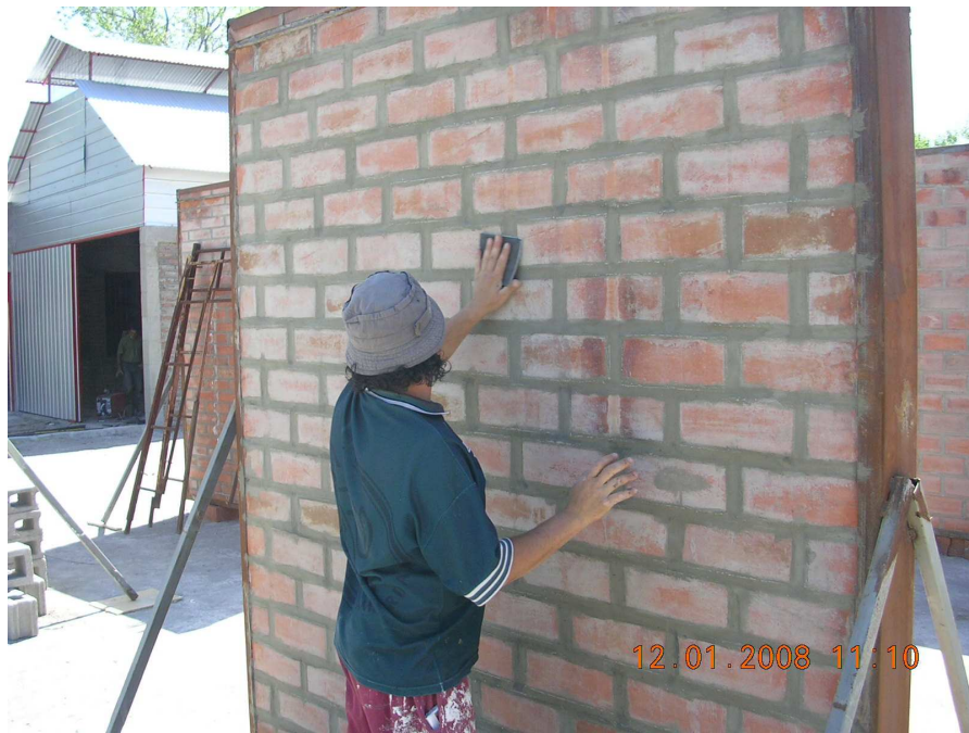
Fig.5.6.4 – Preparación de la superficie
