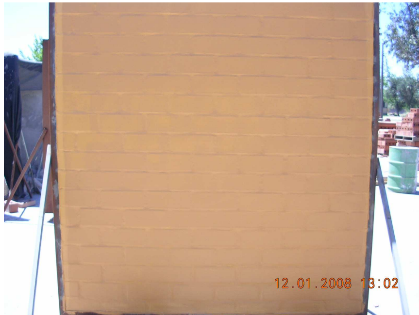
Fig.5.6.10 – Muro al finalizar tratamiento hidrorrepelente.
