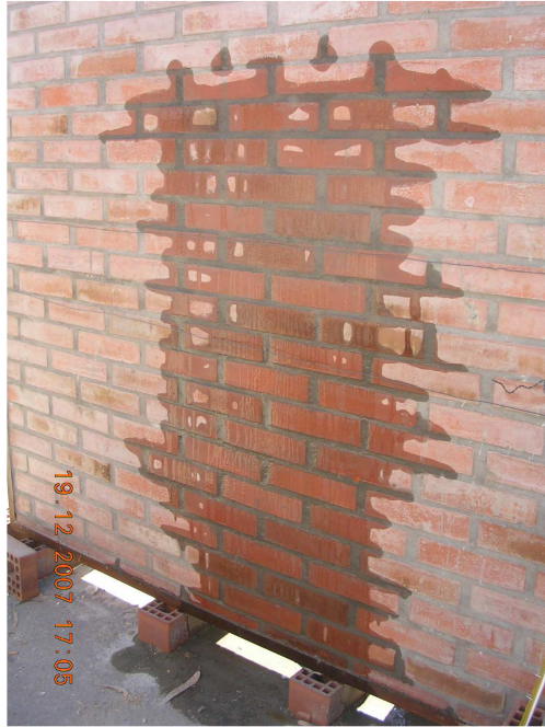
Fotografía 1.1: Muro 1 a 30 min de inicio de ensayo.
