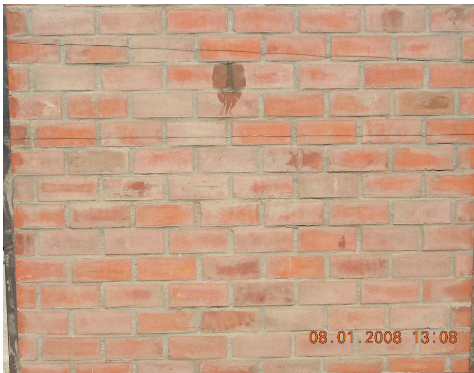
Fotografía 3.5: Muro 3 a 150 min de inicio de ensayo.
