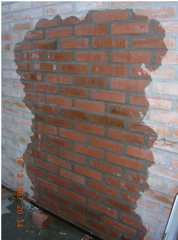
Fotografía 1.8: Muro 1 a 240 min de inicio de ensayo.
