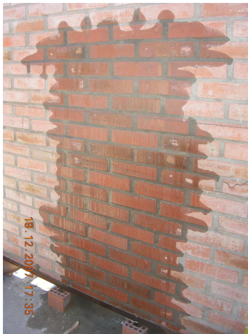
Fotografía 1.2: Muro 1 a 60 min de inicio de ensayo.
