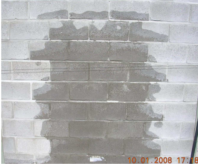
Fotografía 4.3: Muro 4 a 90 min de inicio de ensayo.
