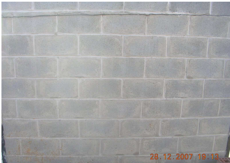
Fig. 6.2.2 Cara opuesta a la cámara luego de 4 h de ensayo en Muro 2
