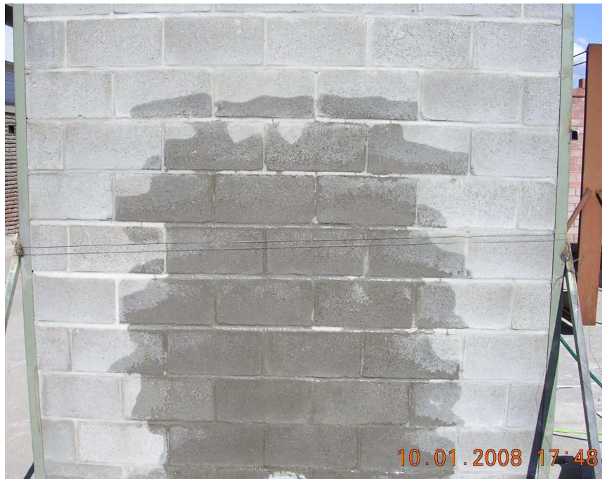
Fotografía 4.4: Muro 4 a 120 min de inicio de ensayo.
