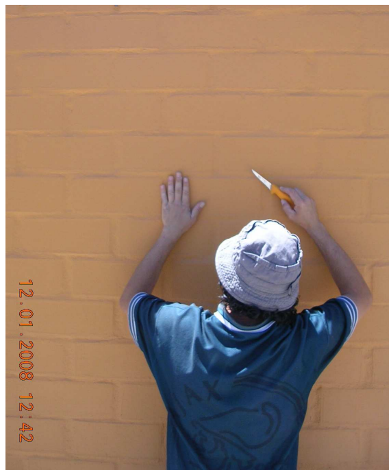
Fig.5.6.7 – Preparación de la superficie
