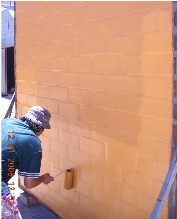
Fig.5.6.9 – 2ª aplicación de hidrorrepelente
