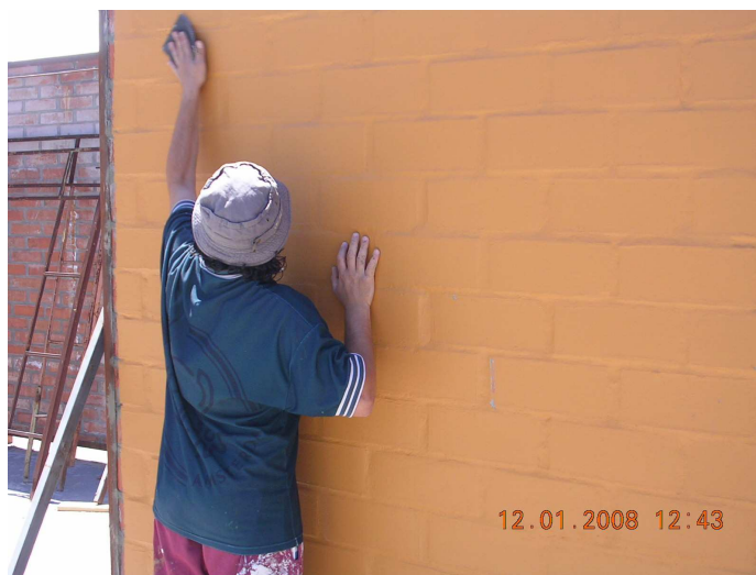
Fig.5.6.8 – Lijado de la superficie
