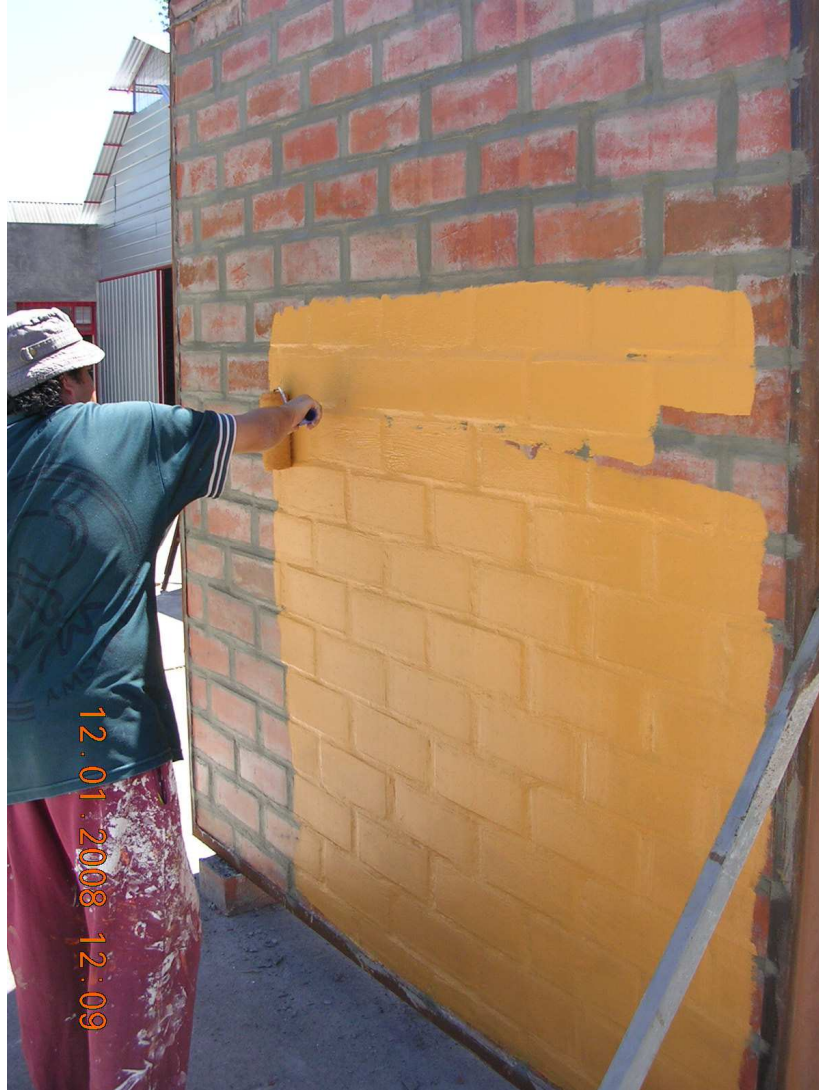
Fig.5.6.6 – Aplicación hidrorrepelente
