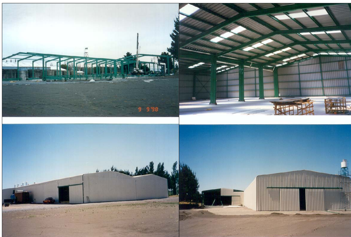
Foto 1 Galpones tipo tubular considerados para la instalación de la maquinaria y la bodega de la planta de pellets.
