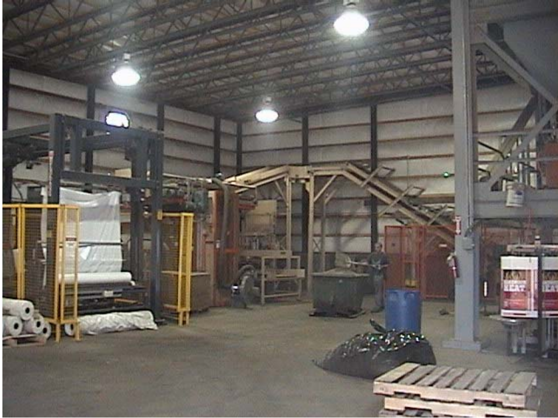
Foto 13 Vista general de las instalaciones destinadas al embalado de los pellets.
