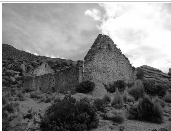
Figura 16: Callanca, muros N y E. Fotografía: Simón Urbina 2007.
