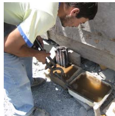
Cantero colocando los fierros desde la fragua en la enfriadera para temprarlas (2007).
