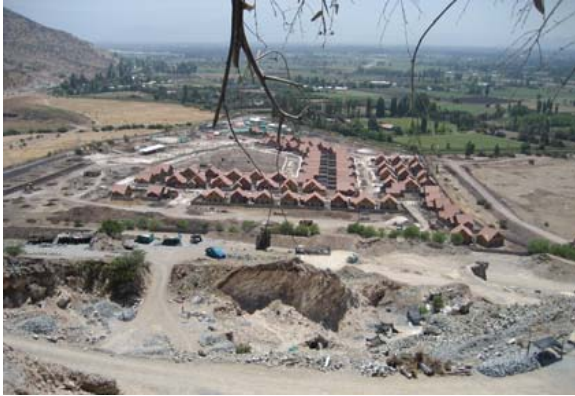
Vista de condominios El Alba en construcción en la entrada poniente de las canteras del cerro La Pedregosa (2007).
