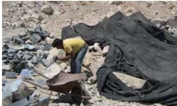
Cantero lajando piedras que estaban protegidas del sol con una malla (2007).
