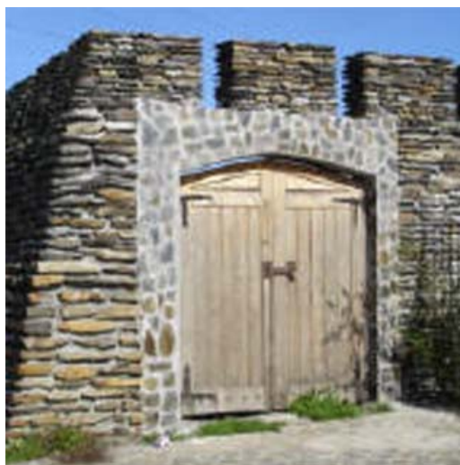
Muro restaurado del Fuerte Tucapel en la Comuna de Cañete, Región del Bío Bío. Portal de Turismo para el Cono Sur de la Provincia de Arauco. http://www.lanalhueturismo.cl
