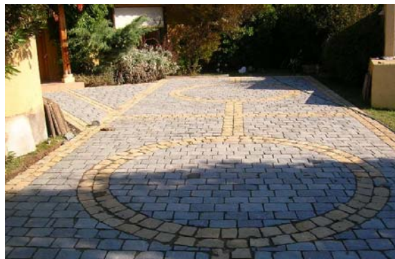
Decopiedras. 2006. Entrada de vehículos con adoquines de basalto azul y caliza amarilla. http://www.decopiedras.cl
