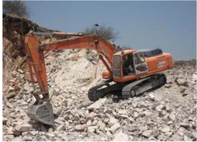
Máquina retroexcavadora recogiendo desmontes en la cantera de El Eucalipto (2007).
