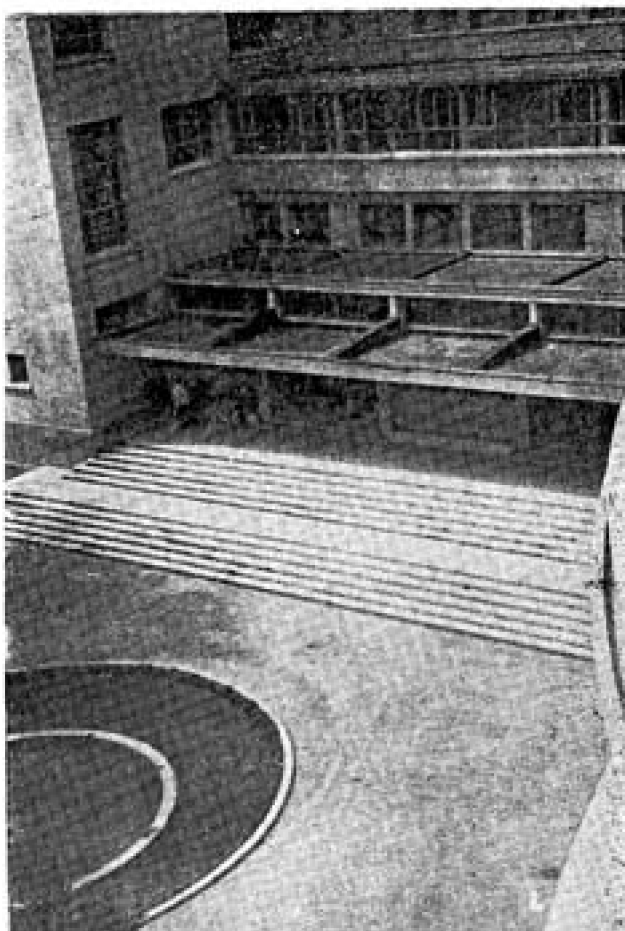
Foto. Vista del pabellón de aulas, desde el patio interior.
