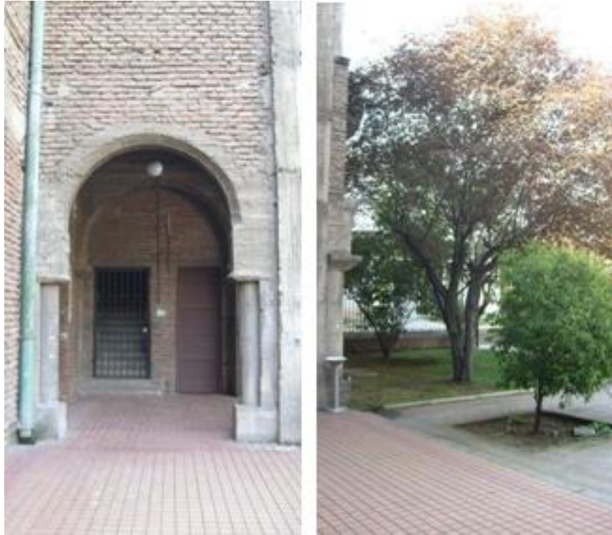
Foto 22: Acceso a bodegas Escuela de Arte Campus Oriente. Diciembre 2008. Fotos: Macarena Baeza.
