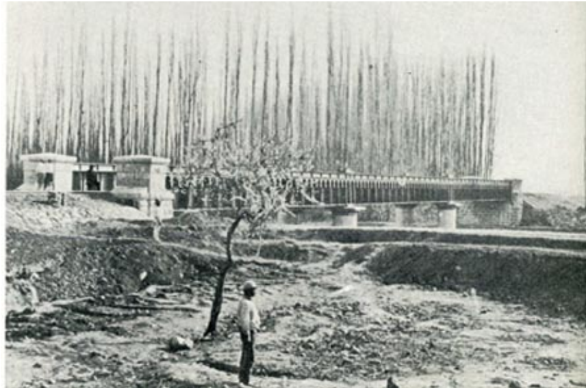
Puente ferroviario sobre el Mapocho en Renca. Álvaro Jara, Chile en 1860 . William L. Oliver: un precursor de la fotografía , Universitaria, Santiago, 1973, p. 62. Pese a su imponente aspecto, fue construido en madera, y originalmente estaba destinado al tráfico de carretas que se dirigían a la Vega y el Mercado Central.
