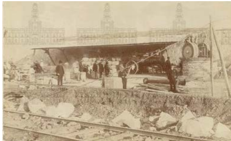
Dos aspectos de los trabajos de canalización del Mapocho en su parte urbana (c. 1888), uno de los mayores trabajos de ingeniería realizados hasta entonces en Chile, y llevado a cabo por el novel Ministerio de Industria y Obras Públicas (1887). Se aprecian los gruesos muros de piedra que debían contener las fuertes corrientes mapochinas, así como el uso de un ferrocarril y máquinas pocas veces vistas en la capital. Colección Museo Histórico Nacional.
