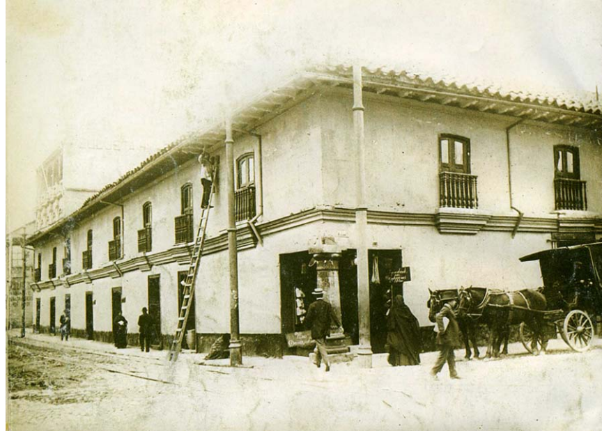
Esquina de calles Puente y San Pablo, c.1900. La edificación es una muestra de "las vetustas esquinas con vórtices de piedra y guardacantones del mismo material; los balcones y corredores salizidos de los puentes altos...", construcción típica del Santiago de finales de siglo, según testimonio de Vicuña Cifuentes (op. Cit., p. 180). Nótese que tras el pilar hay un establecimiento comercial, mientras en la esquina de la izquierda se levantó un improvisado y poco común tercer piso, posiblemente construido bajo el impulso de la activa vida económica del sector. Colección Museo Histórico Nacional.
