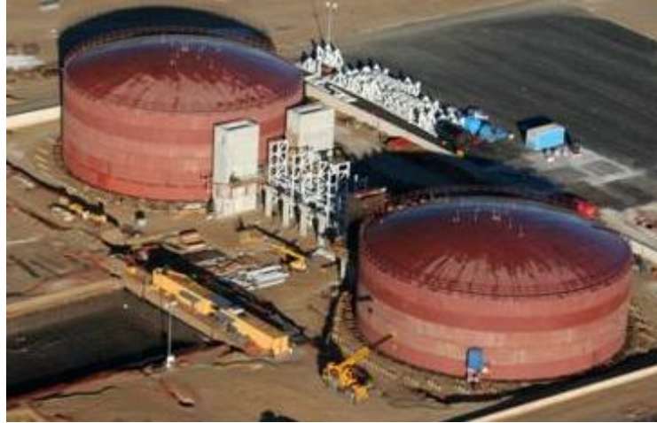
Figura 2.6: Almacenamiento de Sales en dos Tanques (central Andasol 3).
