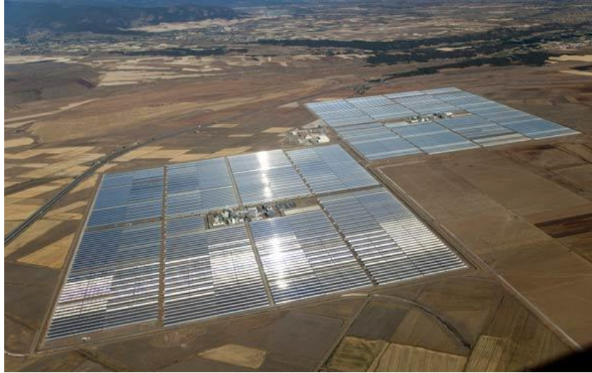
Figura 2.13: Centrales Andasol 1 (izquierda) y Andasol 2 (arriba-derecha), Granada, España
