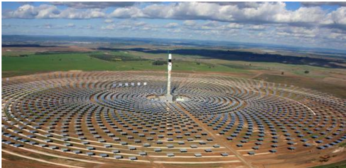
Figura 2.14: Central de Torre central Gemasolar.
