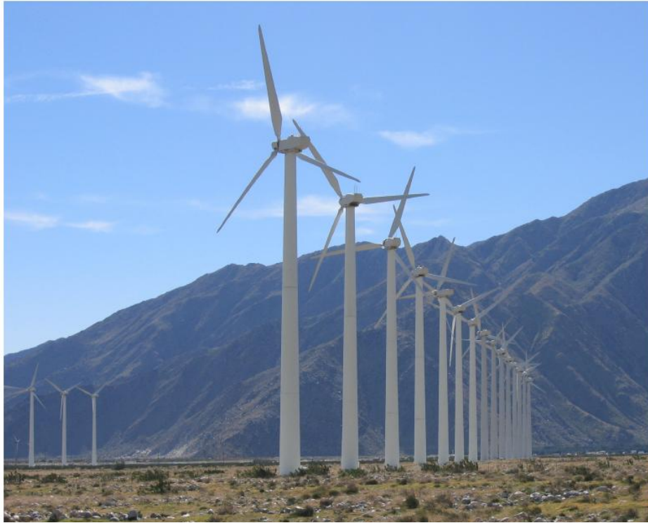
Ilustración 2: Aerogeneradores de gran tamaño.
