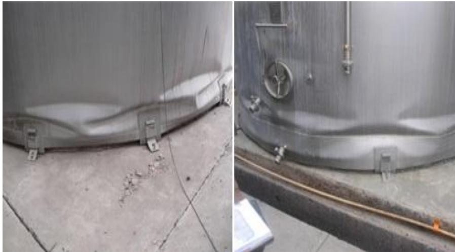
Figura 3.3-3: A la izquierda: Anclajes individuales. A la derecha: Zona anclaje con sistema rigidizador.
