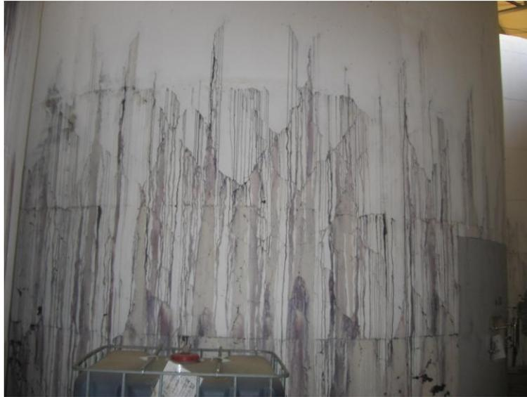
Figura 3.2-31: Falla en pared de estanque de hormigón por esfuerzos de corte
