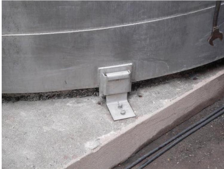
Figura 3.2-6: Silla de anclaje en L enganchada
