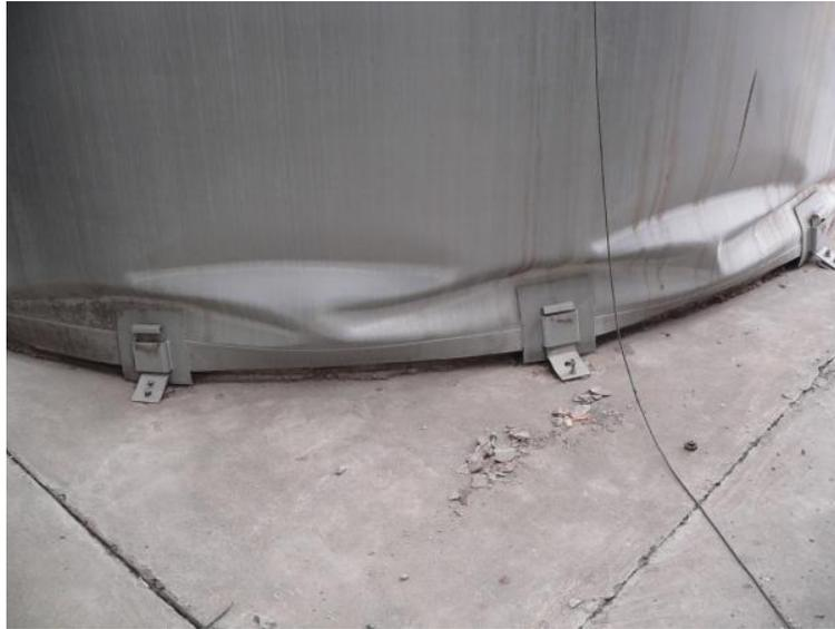
Figura 3.2-12: Pandeo punta adiamantada, anclajes individuales
