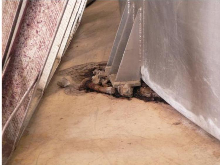
Figura 3.2-22: Corrosión en anclajes
