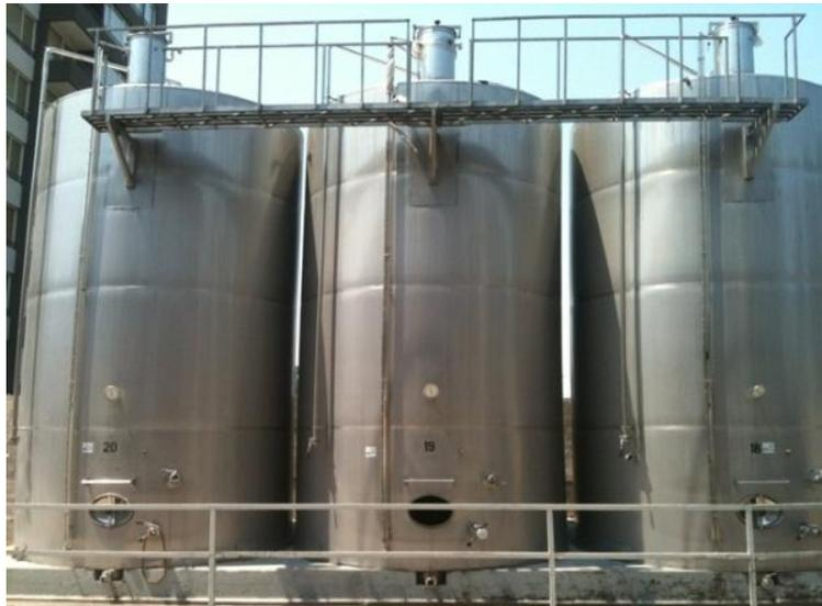
Figura 3.2-1: Estanques de apoyo continuo (acero inoxidable)
