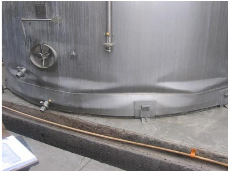
Figura 3.2-11: Pandeo punta adiamantada, anclajes con anillo rigidizador
