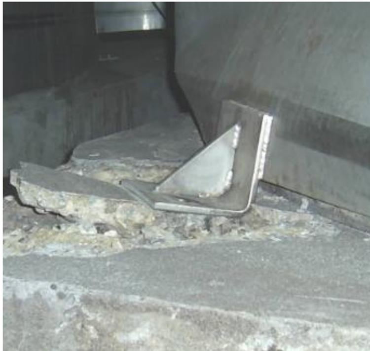
Figura 3.2-7: Silla de anclaje en L con atiesador
