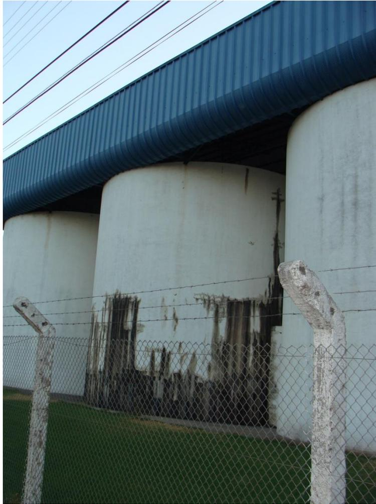
Figura 3.2-30: Falla en pared de estanque de hormigón por esfuerzos de flexión
