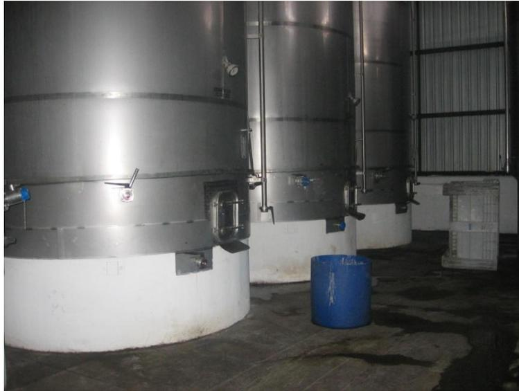
Figura 3.2-10: Estanques emplazados sobre tortas.
