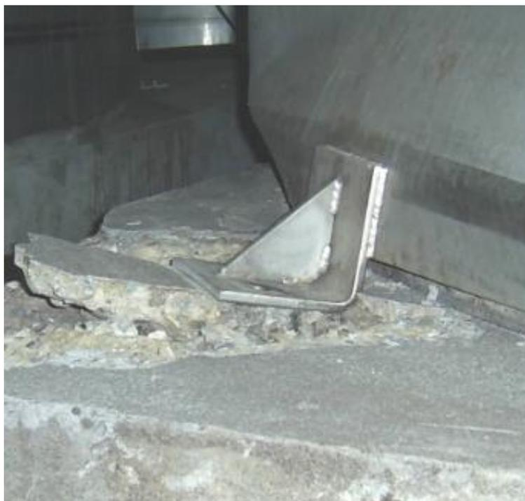
Figura 3.2-21: Falla de hormigón de fundación
