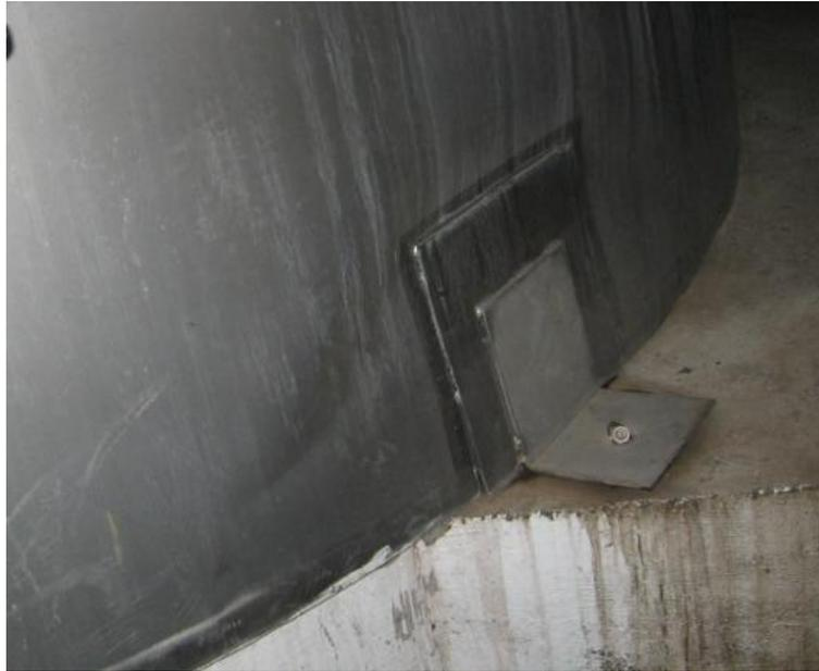
Figura 3.2-4: Silla de anclaje en L
