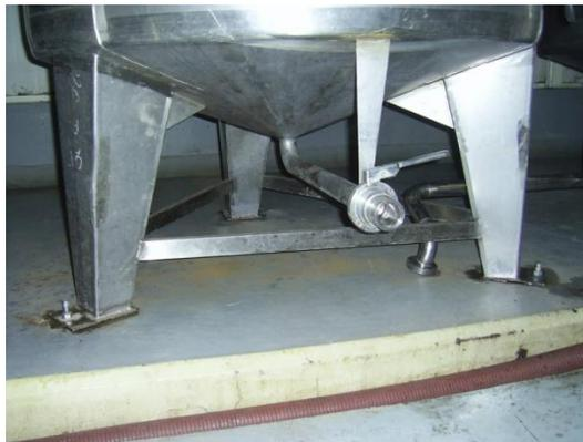
Figura 3.1-3: Estanque Montado Sobre Patas con Fondo Cónico
