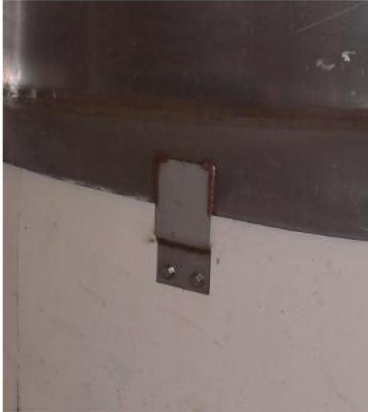
Figura 3.2-8: Plancha de anclaje
