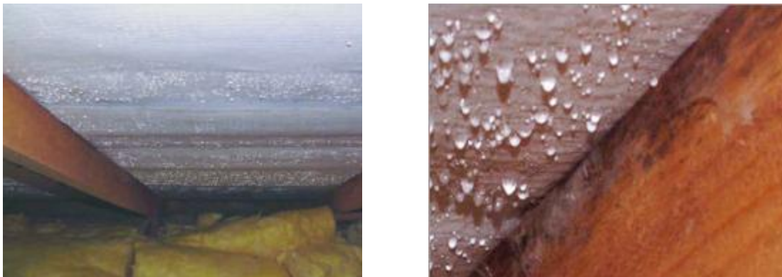
Figura 2.2 Condensación superficial en techumbre fría.
