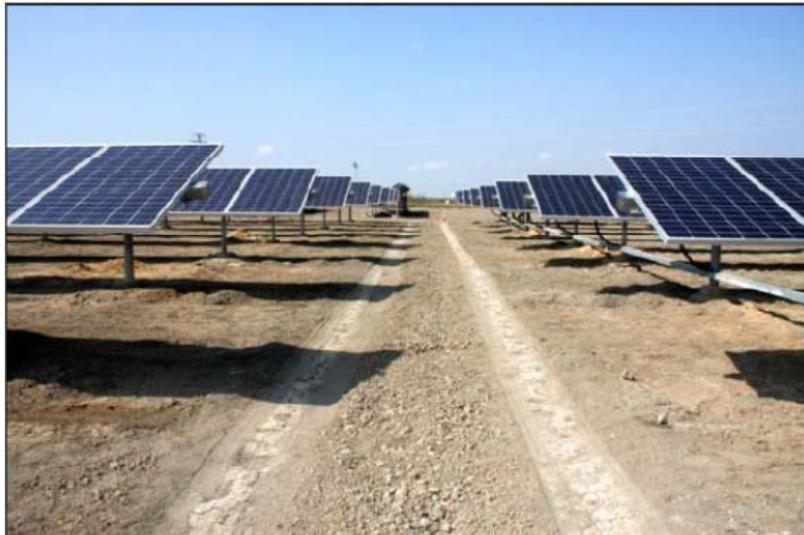
Figura 3.12: seguidor de un eje Horizontal.
