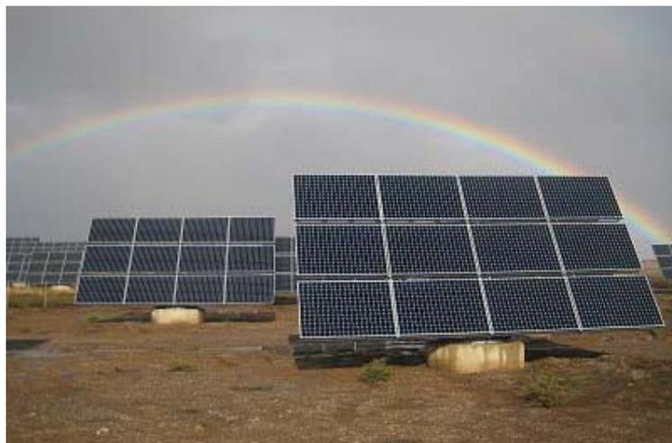
Figura 3.14: Seguidor de 2 Ejes.
