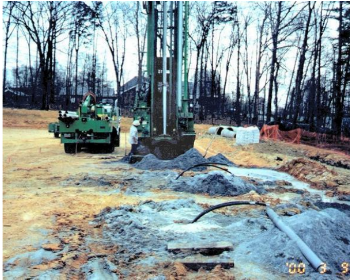
Figura 5.14: Se muestra la instalación de tubos U en dos sondajes. Hay un tercero en perforación, notar que del primer sondaje se retiró el encamisado temporal. Fuente http://www.geo4va.vt.edu
