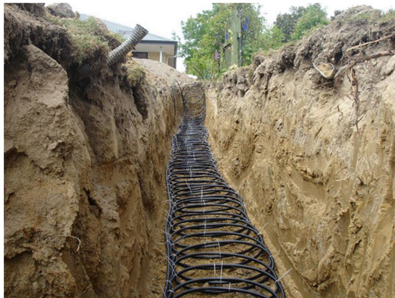
Figura 5.11: Instalación de cañería en espiral para sistema horizontal de circuito cerrado en una trinchera.
