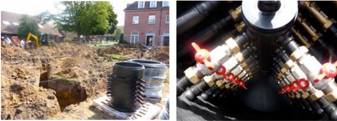
Figura 5.16: Cámara prefabricada manifold para administrar múltiples pozos. Fuente http://www.synergyboreholes.co.uk
