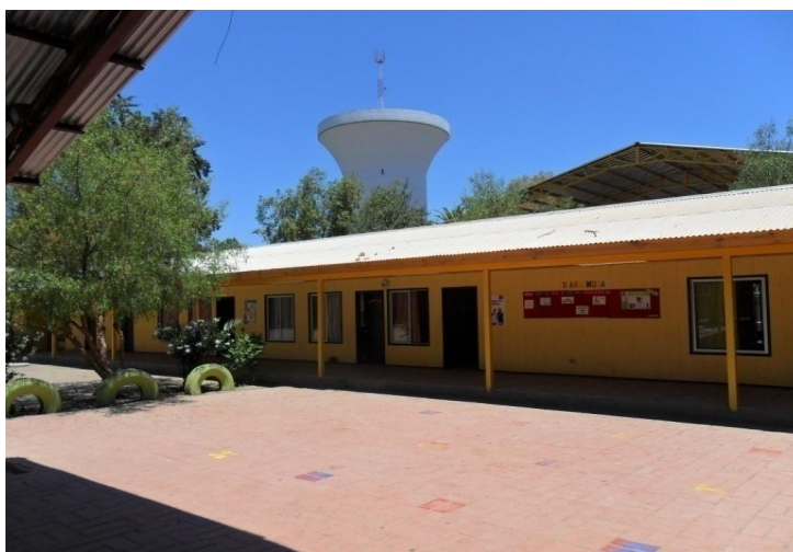
Foto 24: Construcción de madera levantada en el colegio de Santa Sara. La anterior construcción de ladrillo se derrumbó post terremoto
