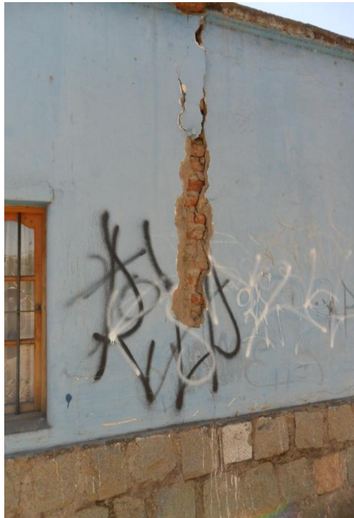
Foto 27: Fachada de construcción de ladrillo y barro. Batuco.
