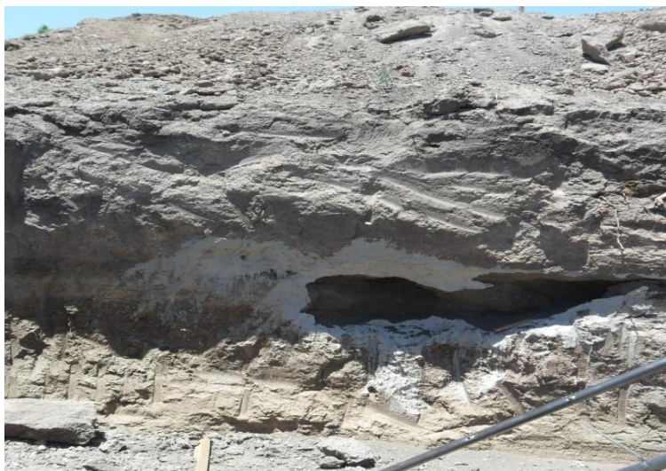
Foto 22: Calicatas en construcción de colegio en Santa Marta de Liray. Se observó arenas y finos con una unidad blanquecina de 1 metro (ceniza)
