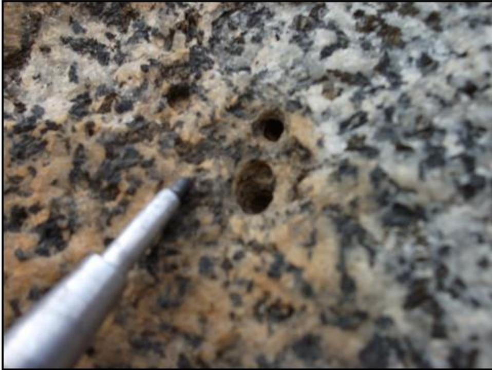
**Figura 6: Desagregación granular incipiente.**
