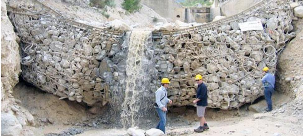
**ILUSTRACIÓN 16:** BARRERA FLEXIBLE POSTERIOR A LA OCURRENCIA DE UN FLUJO
