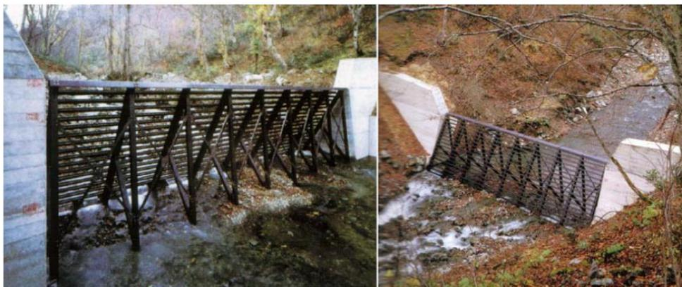
**ILUSTRACIÓN 14:** PRESA DE APERTURA HORIZONTAL (BEAM-DAM) (MIZUYAMA, 2003).
