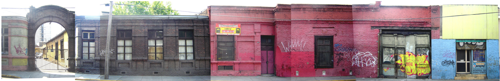
2- Fachada hacia calle Purísima
