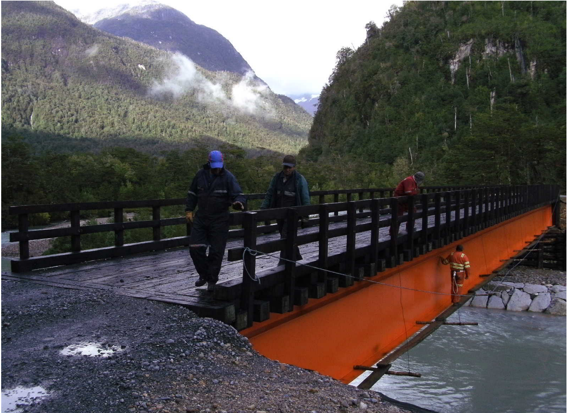
Mantenimiento Puente Lago Bayo. Km. 52 camino Exploradores. Fuente fotográfica personal
