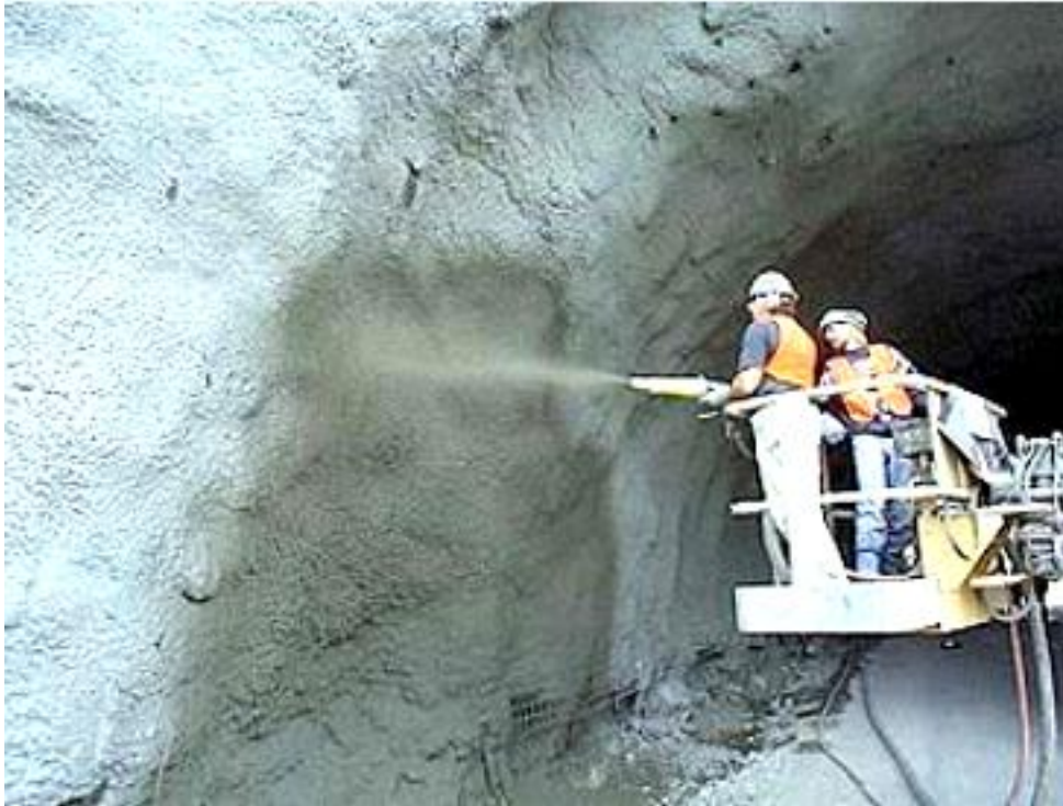
Figura IV.3: Aplicación de Hormigón Proyectado
