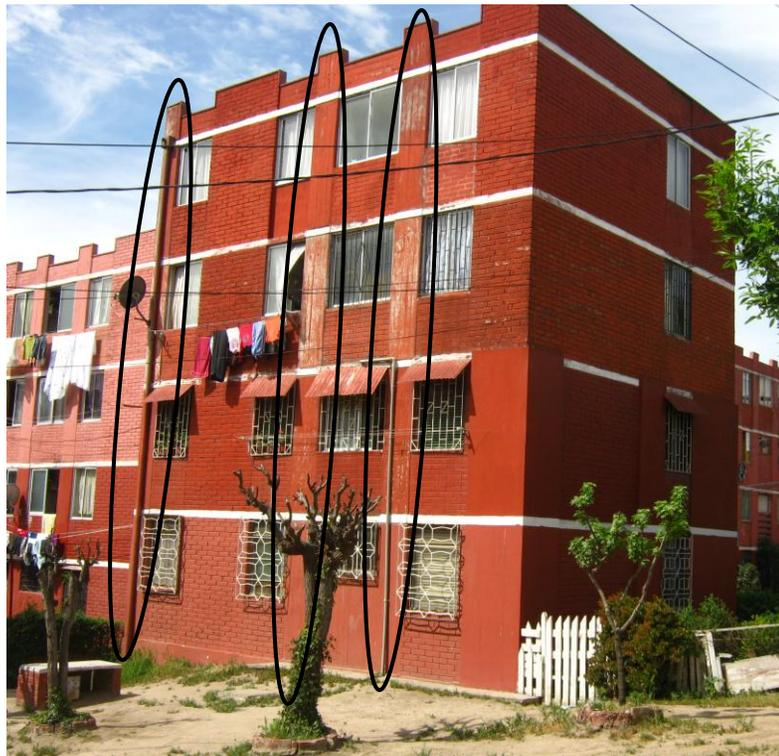
Figura 2.6: Columnas de hormigón armado en edificios de albañilería
