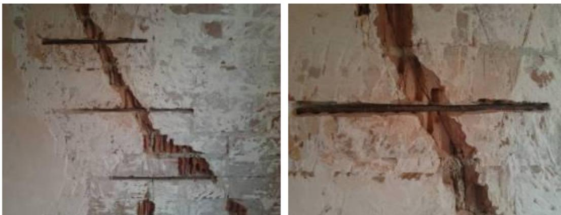
Figura 6.61: Inserción de barras horizontales en reparación de grietas.
