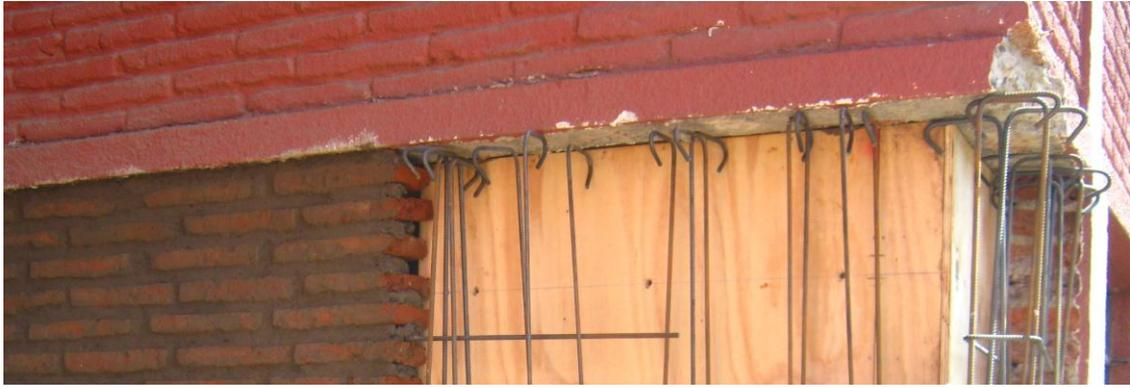
Figura 6.27: Detalle armadura machón
