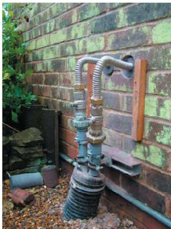
**Figura 3.26: Conexión de vivienda particular a la red.**
