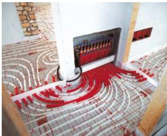
**Figura 3.28: Esquema de instalación de losa radiante en una vivienda.**
