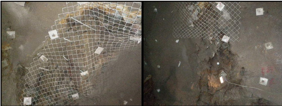
Figura 60: Fotografía de falla de dip/dipdir: 55/141 en la frente del Pk 5297.
