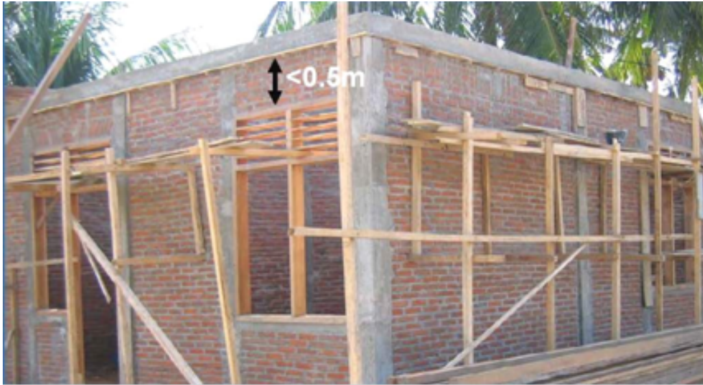
Figura 2.38: Aberturas de ventanas desplazadas (BuildChange, 2006)
