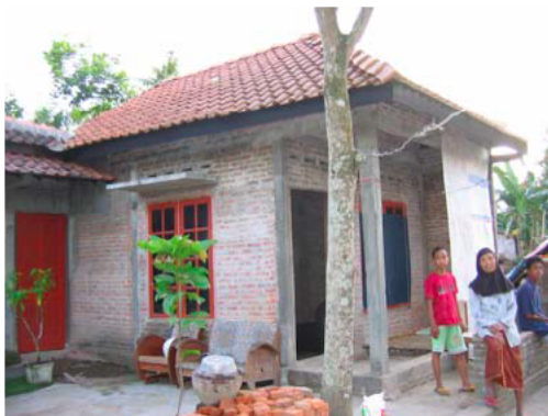
Figura 2.1: Albañilería confinada bien diseñada y construida (Hausler, 2008)
