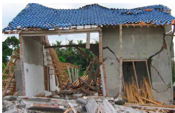
Figura 2.2: Albañilería confinada mal diseñada y construida (Hausler, 2008)
