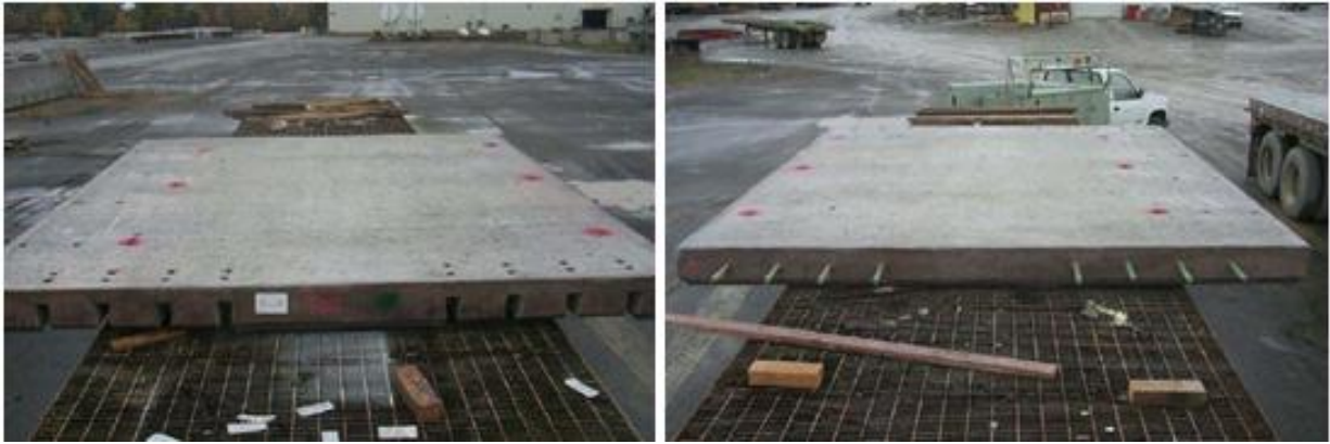
Figura II.12. A la izquierda: panel Super-Slab cara con ranuras. A la derecha: panel Super-Slab cara con barras.
