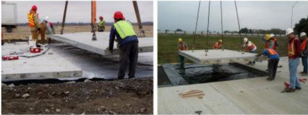
Figura II.36. Montaje de paneles sobre material reductor de fricción.
