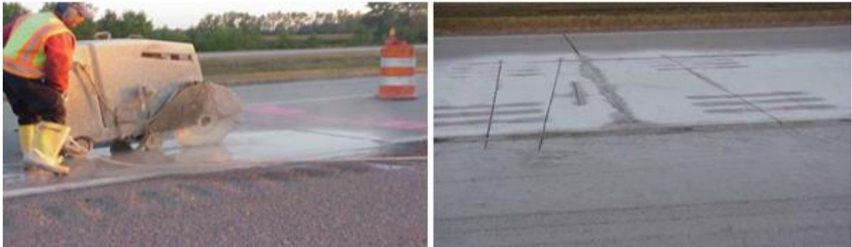
Figura II.4. A la izquierda: corte de losa a remover. A la derecha: cortes en la losa.
