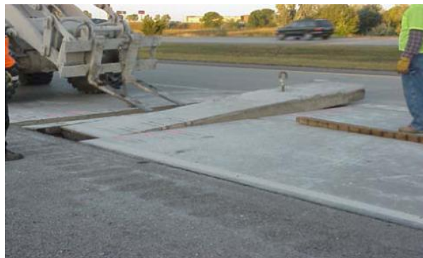
Figura II.5. Extracción losa dañada.
