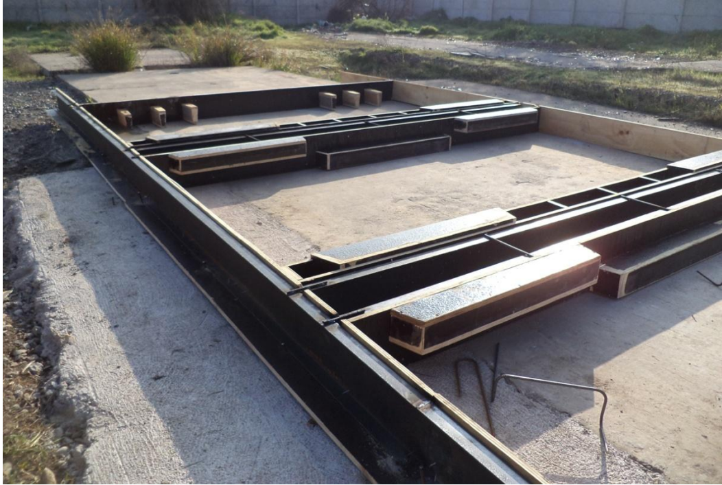
Figura V.5. Ubicación de moldajes fijados a la base.
