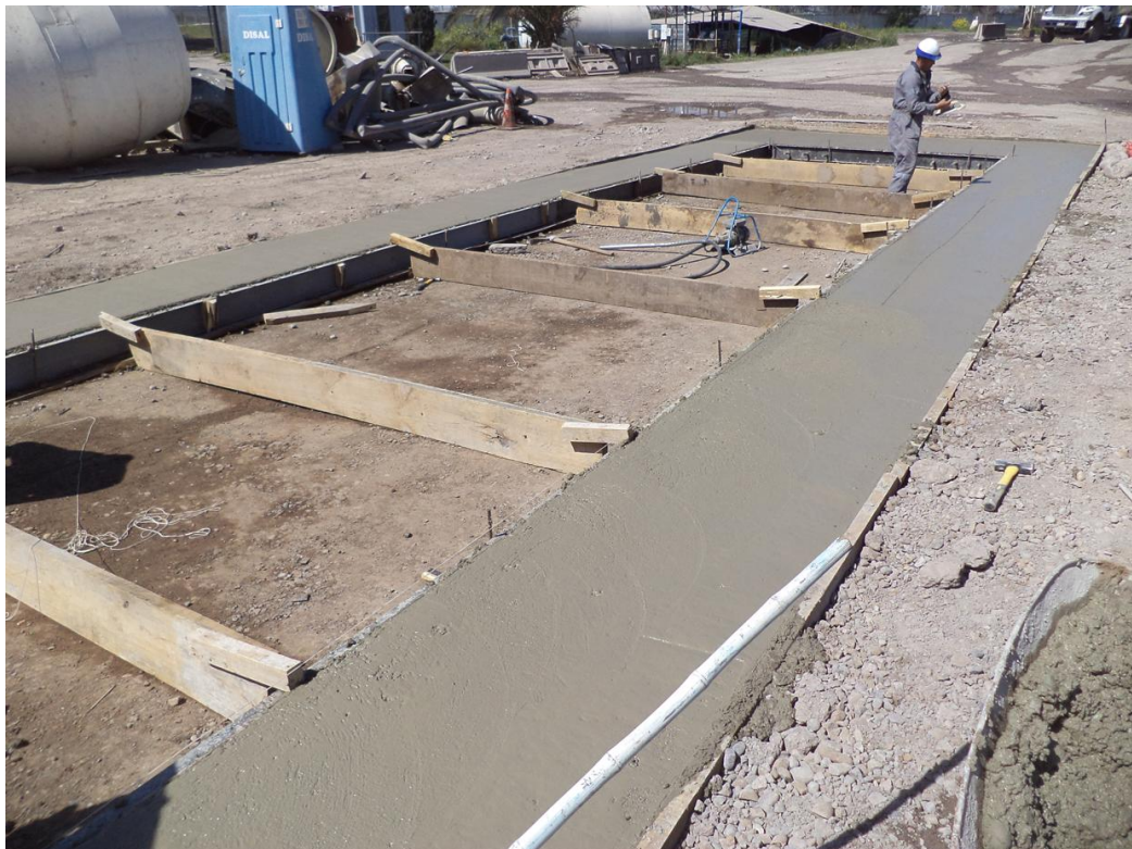
Figura C.6. Hormigonado de bermas y losas de los extremos.
