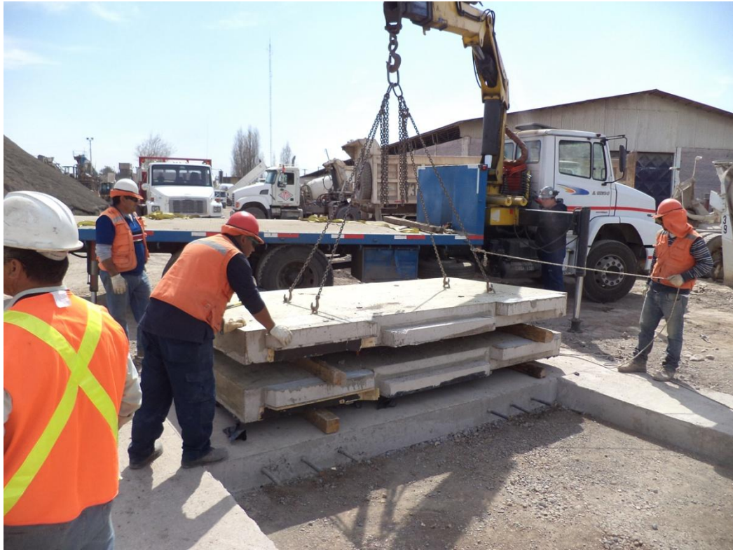
Figura C.9. Descarga de losas prefabricadas a un costado del tramo de prueba.
