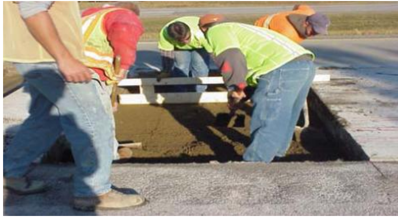
Figura II.6. Preparación base que recibirá al panel de hormigón prefabricado.
