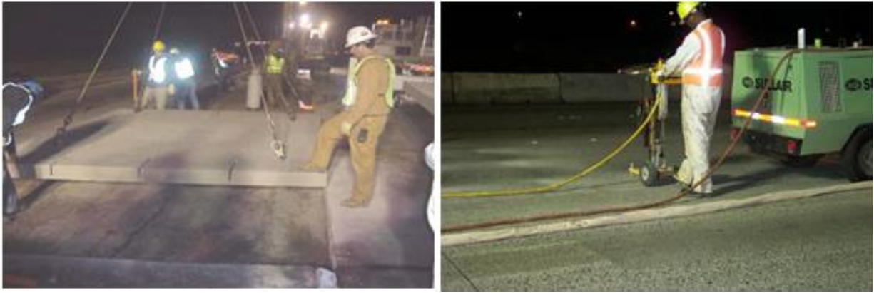
Figura II.19. A la izquierda: montaje panel. A la derecha: perforación agujeros de nivelación.
