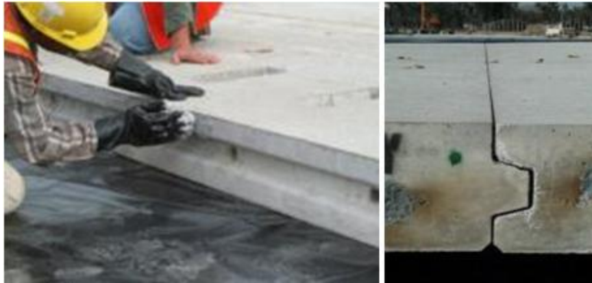
Figura II.34. A la izquierda: colocación material epóxico. A la derecha: llave de corte (machihembrado).
