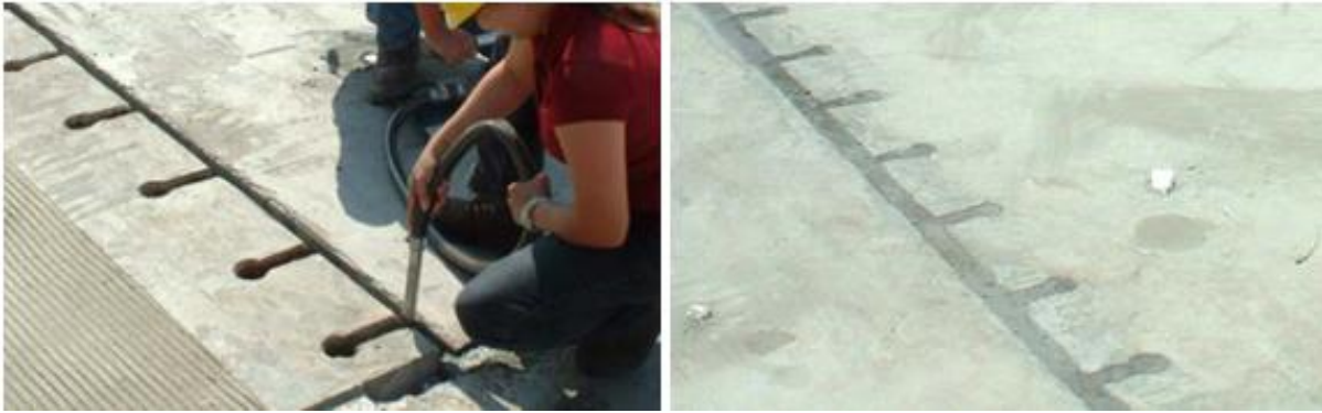
Figura II.28. Sellado de uniones mediante grout.
