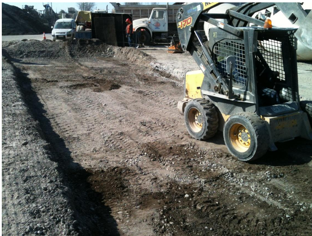
Figura C.2. Excavación tramo de prueba.
