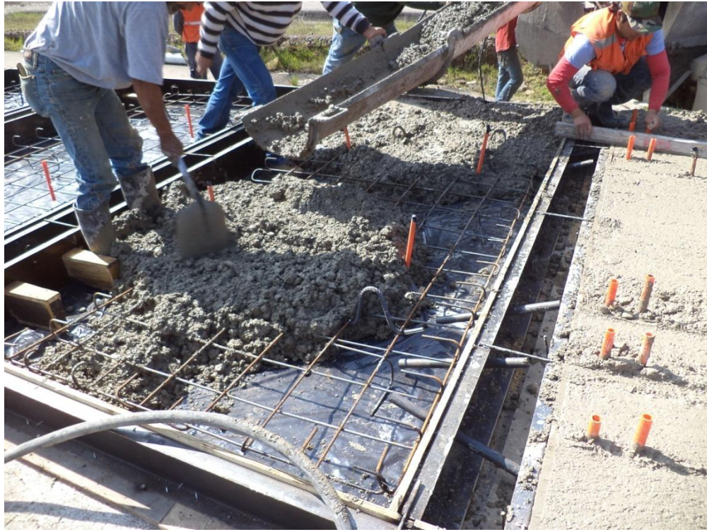
Figura V.7. Hormigonado de losas, hormigón que posteriormente fue vibrado y enrazado.
