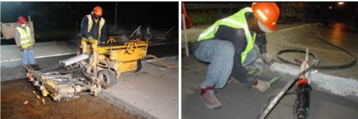
Figura II.13. A la izquierda: Perforación agujeros para barras de transferencia. A la derecha: Inserción de barras de transferencia en pavimento existente.
