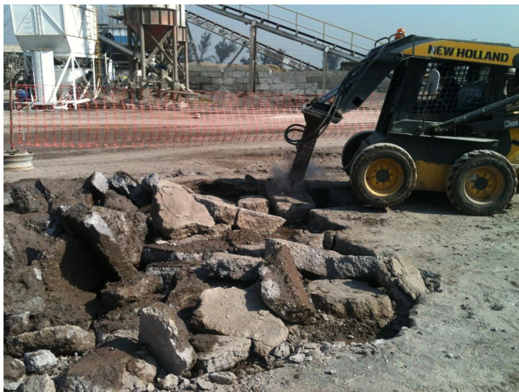
Figura C.1. Remoción paño de hormigón existente en terreno.
