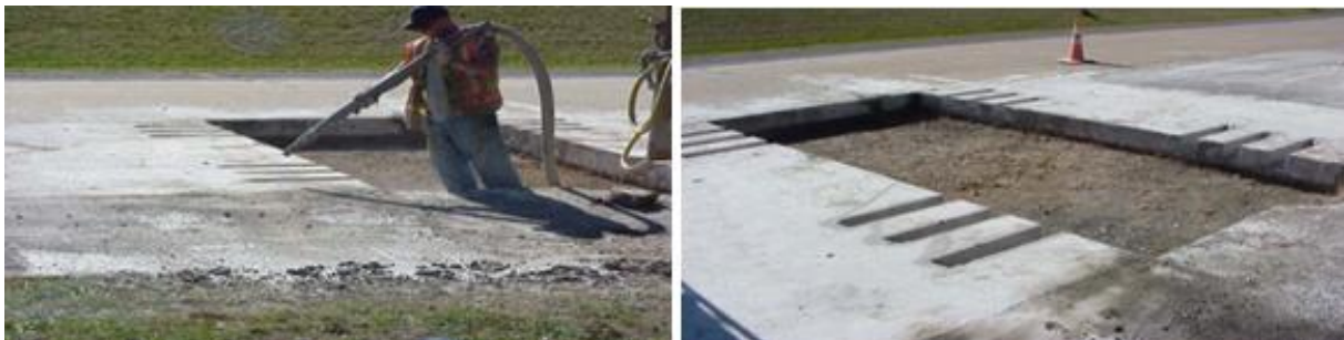
Figura II.8. Limpieza de ranuras mediante aire comprimido y chorro de arena.
