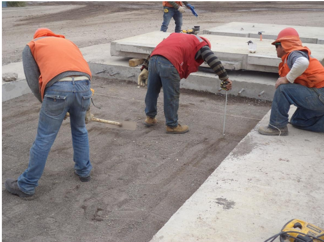
Figura C.10. Colación capa de arena sobre base estabilizada.
