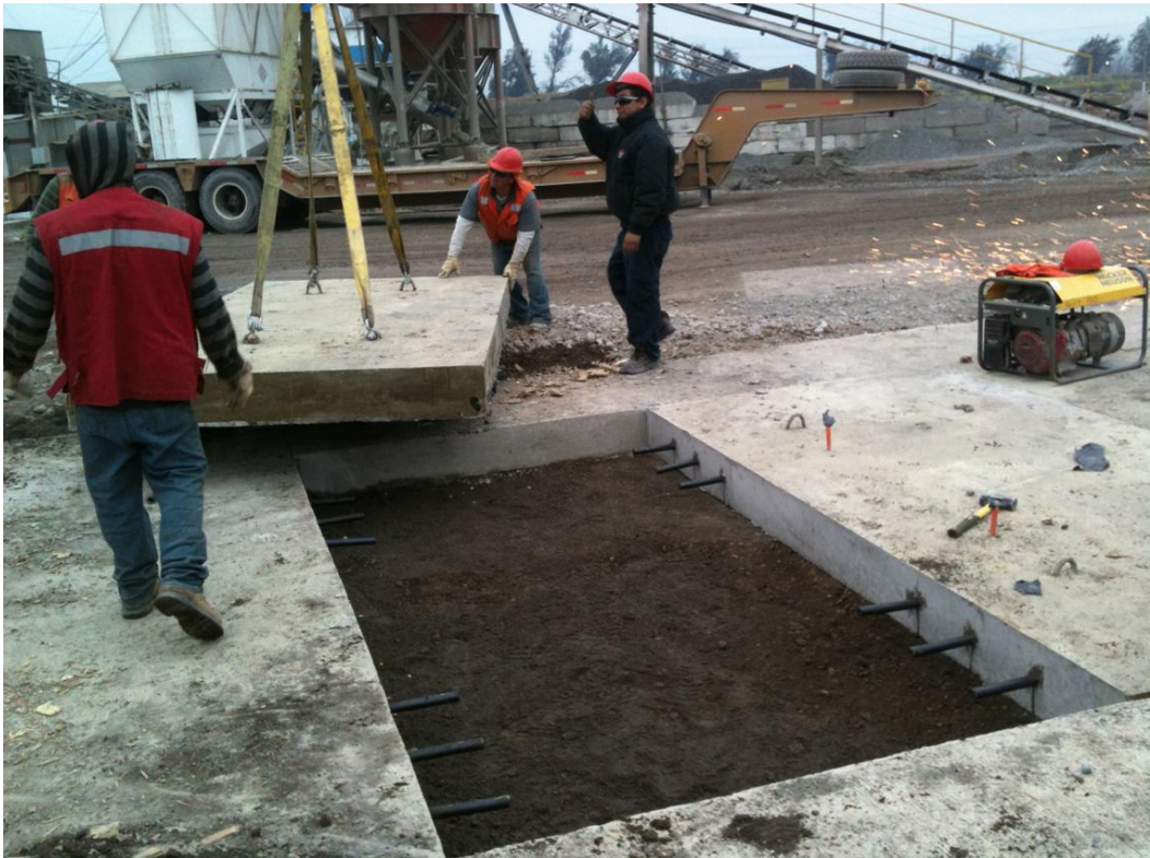
Figura C.12. Montaje de losa con sistema barra-ranura.
