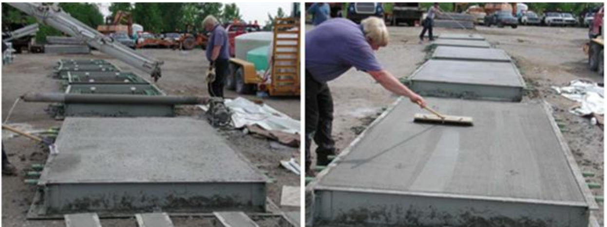
Figura II.2. A la izquierda hormigonado, y a la derecha aplicación textura superficial.
