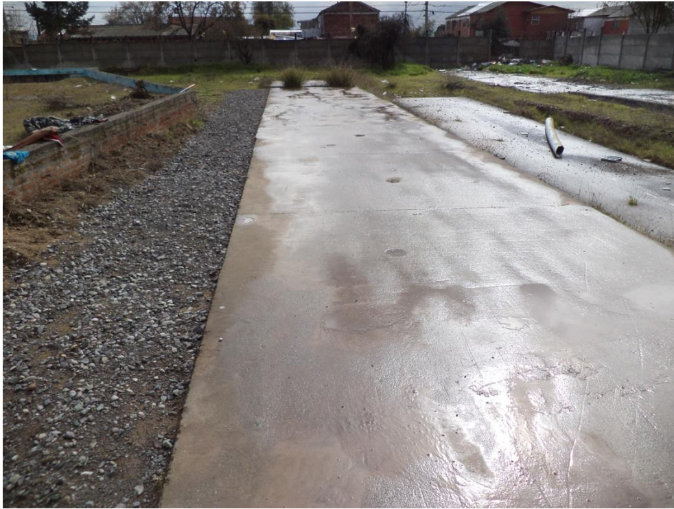
Figura V.3. Pavimento de prueba en IDIEM Cerrillos utilizado como base.
