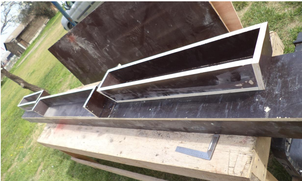
Figura V.2. Pieza de moldaje que da forma a la conexión tipo macho.
