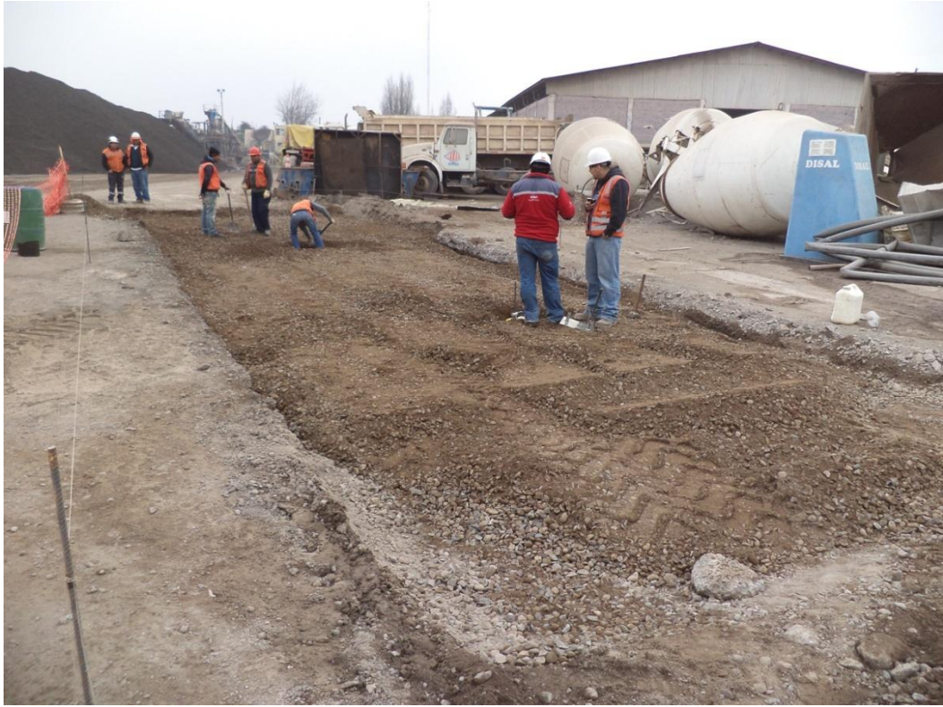
Figura C.3. Colocación capa de base estabilizada..
