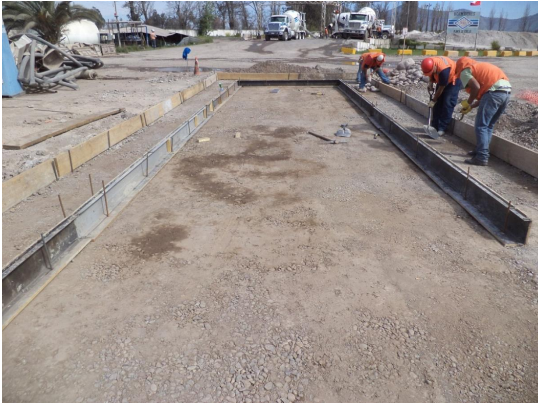
Figura C.5. Colocación de moldajes para bermas y losas de los extremos.
