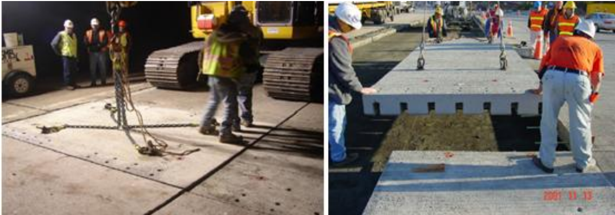
Figura II.14. Montaje de paneles sistema Fort Miller Super-Slab.
