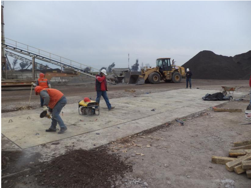
Figura C.13. Corte de azas para finiquitar el montaje.
