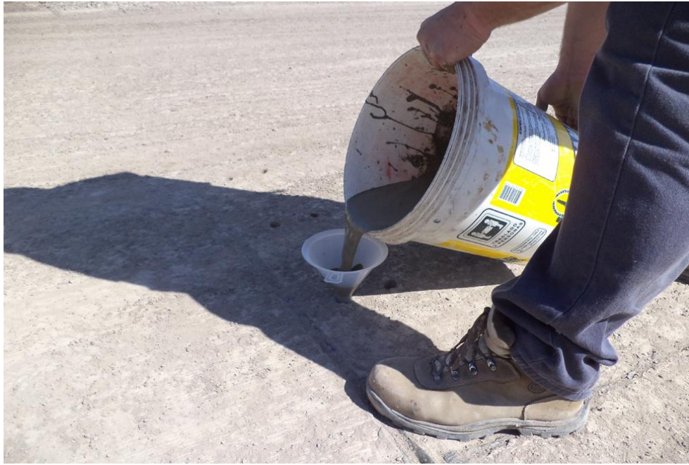
Figura C.15. Inyección de grout en ranuras sistemas barra-ranura.
