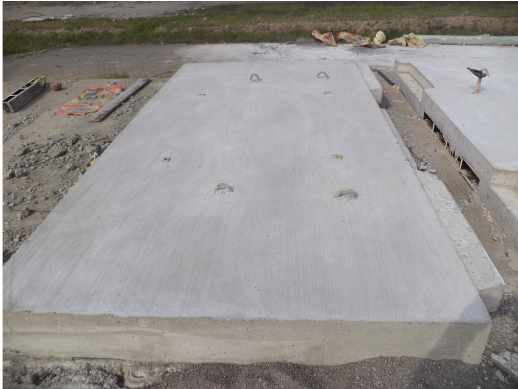
Figura V.9. Losa descimbrada con sistema machihembrado.
