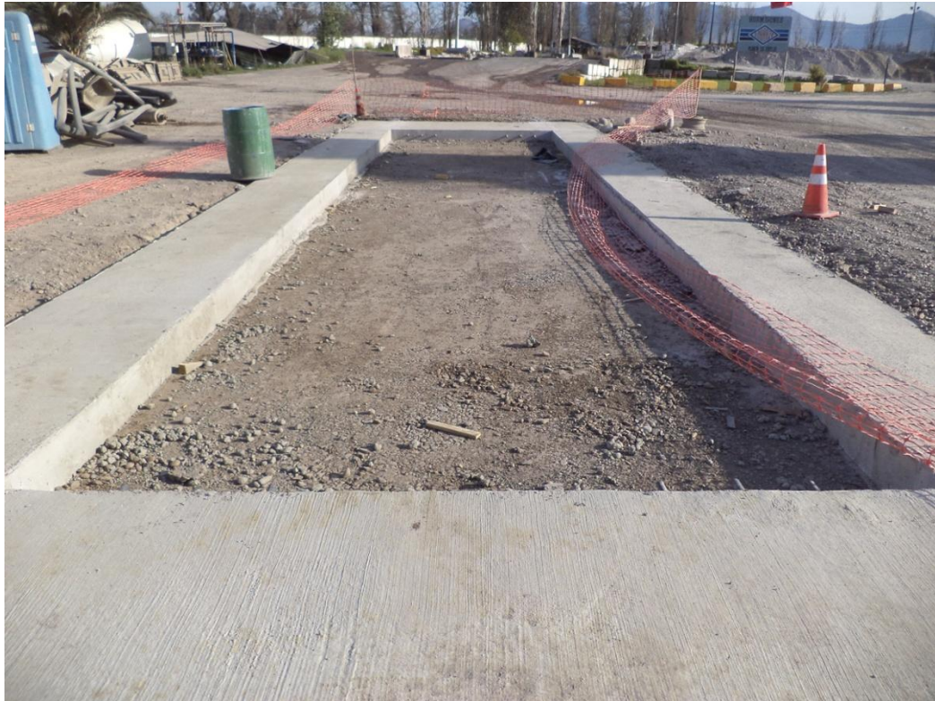
Figura C.7. Tramo de prueba que albergará las losas prefabricadas.
