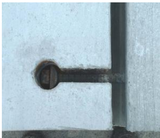
Figura II.26. Sistema de acople método Kwik.
