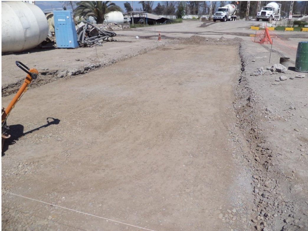
Figura C.4. Compactación base estabilizada.
