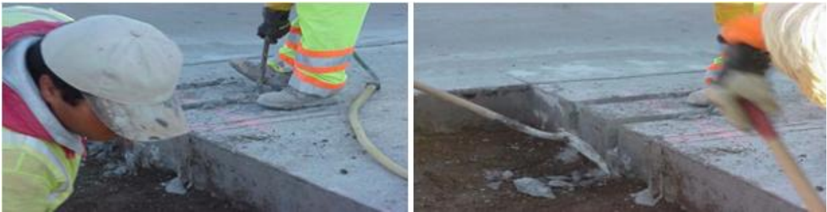
Figura II.7. Extracción de hormigón (ranuras).
