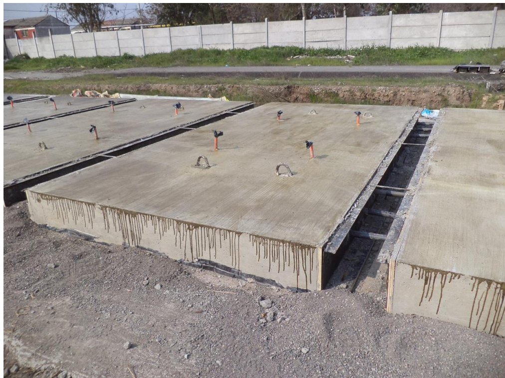
Figura V.10. Losa sistema barra-ranura con prácticamente la totalidad de moldaje retirado.
