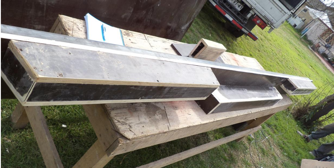
Figura V.1. Pieza de moldaje correspondiente a la conexión tipo hembra.
