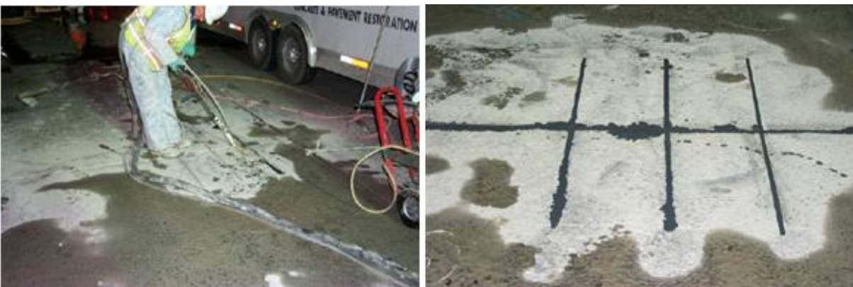
Figura II.23. A la izquierda: sellado de ranuras. A la derecha: unión finalizada.
