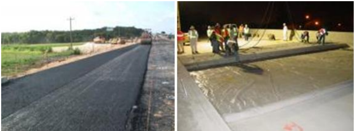
Figura II.33. A la izquierda: capa de asfalto para base. A la derecha: colocación de material reductor de fricción.
