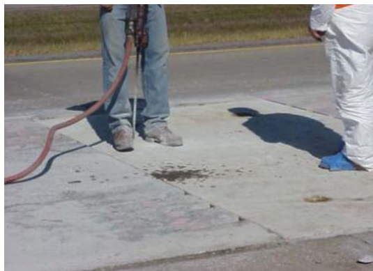
Figura II.10. Inyección de espuma de poliuretano para nivelación
