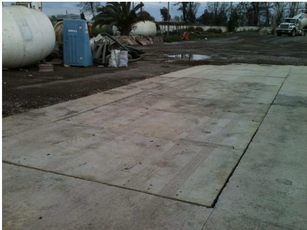
Figura C.14. Tramo de prueba con losas instaladas.
