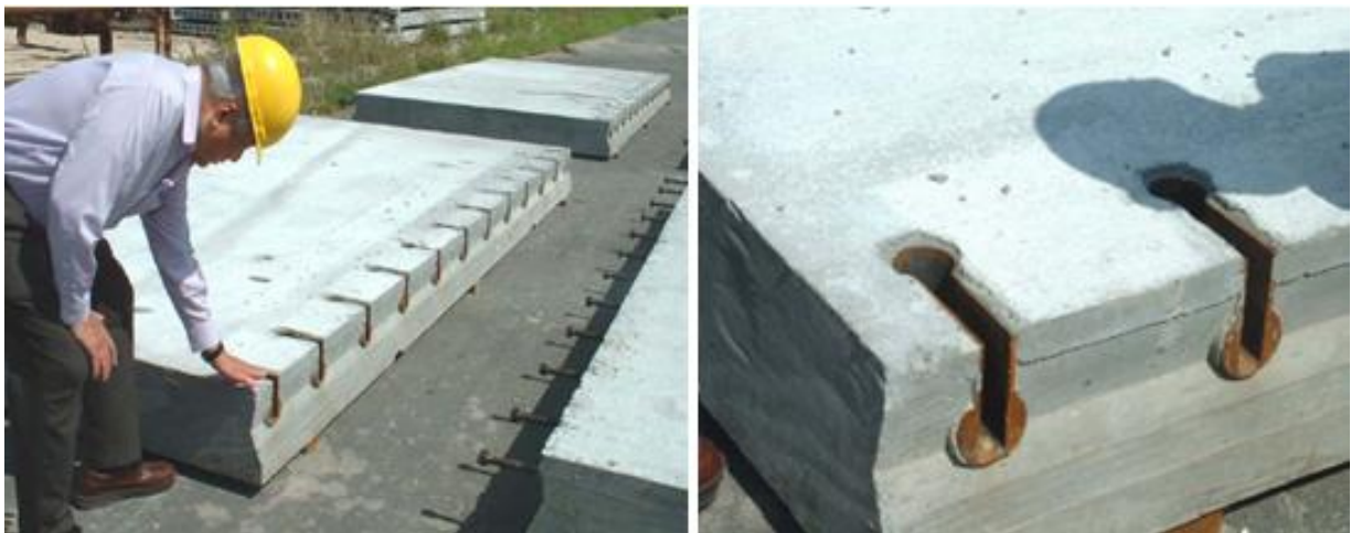
Figura II.25. Sistema de ensamblaje método Kwik.
