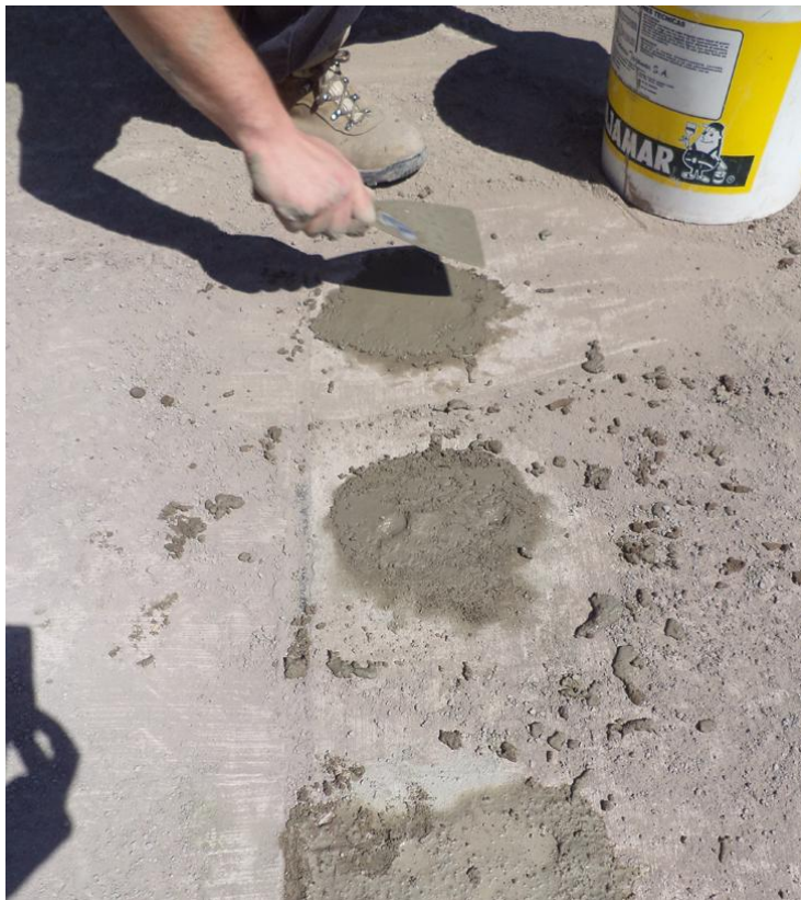
Figura C.16. Terminación de grouteado para posterior apertura del tramo.
