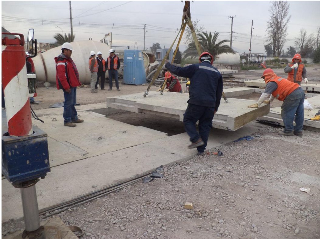
Figura C.11. Montaje de losas con sistema machihembrado.
