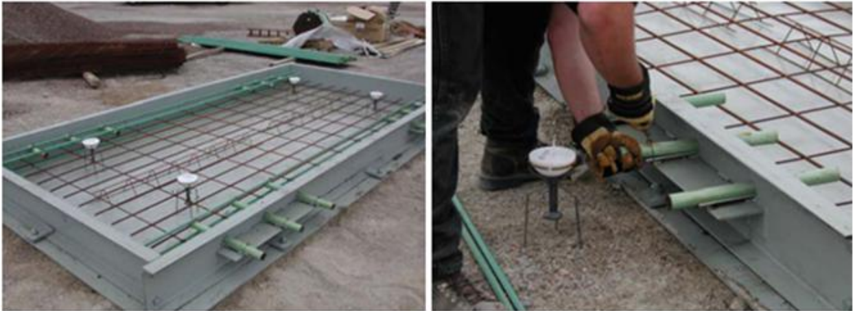
Figura II.1. A la izquierda moldaje con armadura y dowel bars, y a la derecha fijación de barras de transferencia.
