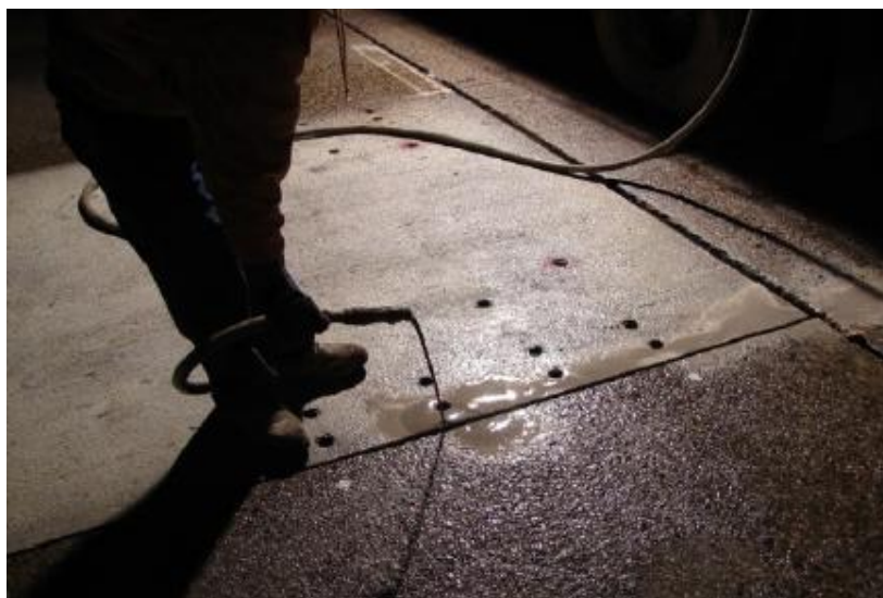
Figura II.17. Sellado de ranuras con grout de alta resistencia.
