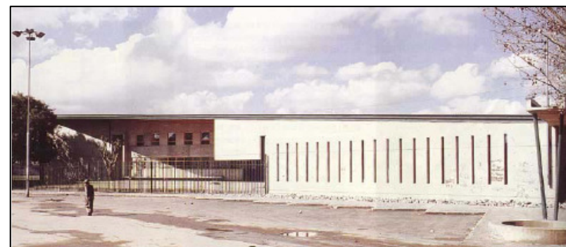
Fig. 02 Colegio Enrique Alvear, Cerro Navia, 2001. Arq. Gubbins Arquitectos Consultores Fuente: Nuevos espacios educativos
