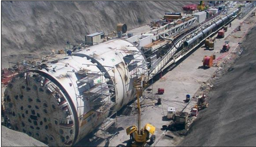
Figura C - 2. TBM de doble escudo marca Herrenknecht utilizada para la construcción de un túnel en Guadarrama, España. (Fuente: www.herrenknecht.com )
