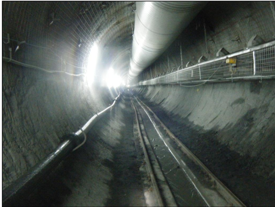
Figura C - 9. Vista de una sección del túnel pasada la máquina tunelera
