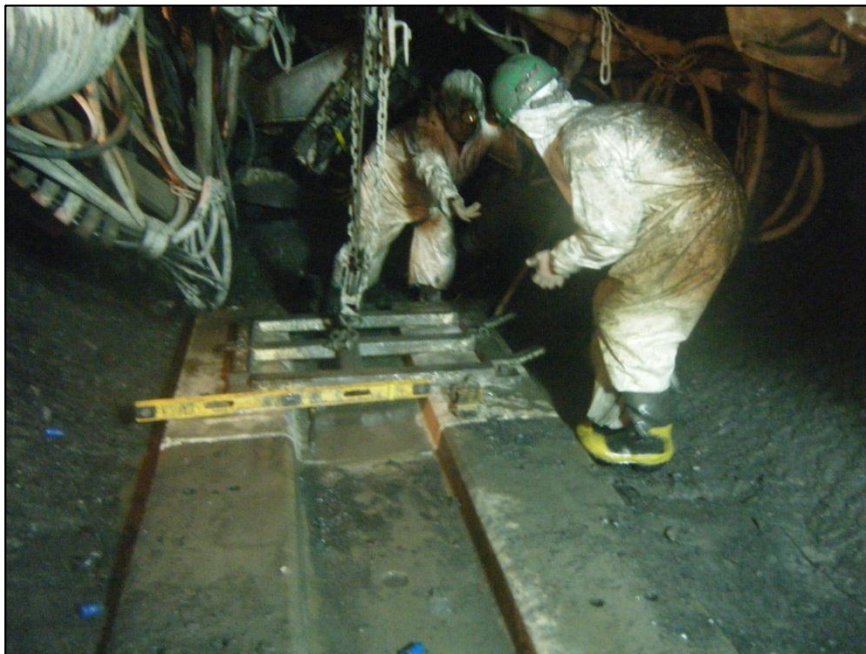
Figura C - 8. Vista de la parte inferior de la zona de fortificación, donde se colocan las dovelas de hormigón y posteriormente los rieles.
