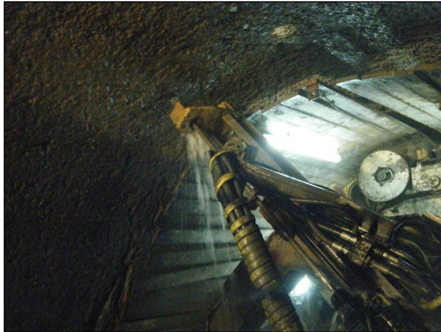
Figura C - 7. Vista de perforación de paredes para posterior colocación de barra de anclaje.
