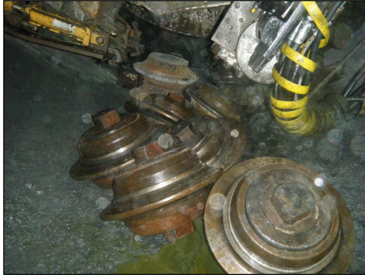
Figura C - 3. Discos de corte (simple) en faena dispuestos a ser colocados en la TBM.
