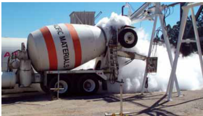
Figura 2.14. Enfriamiento Previo del Hormigón con Nitrógeno Líquido. (Fuente: Gajda. 2006)
