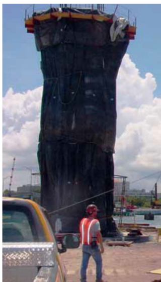
Figura 2.13. Columna de Puente con Aislación Térmica. (Fuente: Gajda. 2006)
