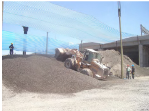
Figura 2.18. Acopio de Áridos Protegidos de la Radiación. (Fuente: Lagos. 2009)
