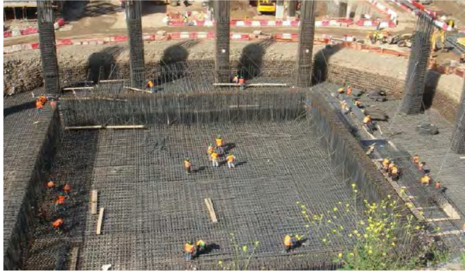
Figura 2.16. Colocación de Armadura Losa de Fundación Torre 1 Costanera Center. (Fuente: Lagos. 2009)
