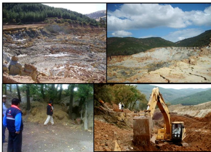
Figura IIb. Tranque después del colapso (arriba), y limpieza post colapso (abajo). Fuente: Ramírez (2010) y Ramos (2011b).
