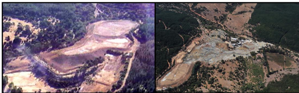
Figura IIa. Tranque de relave antes del terremoto (izquierda), y después del terremoto (derecha)
