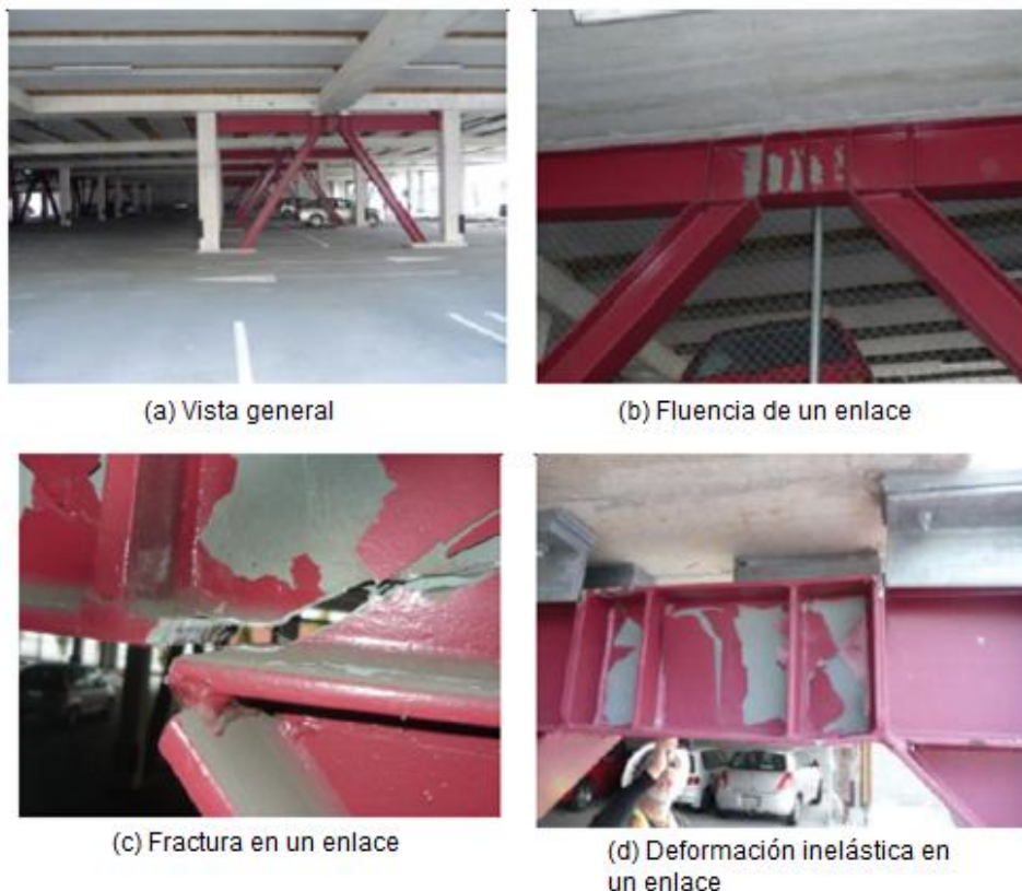
Figura 2-6: Edificio de estacionamientos [17]
