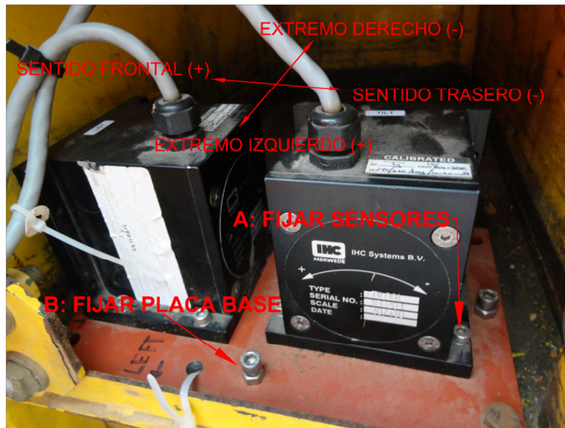
Imagen 3.6: Instalación de sensores de inclinación
