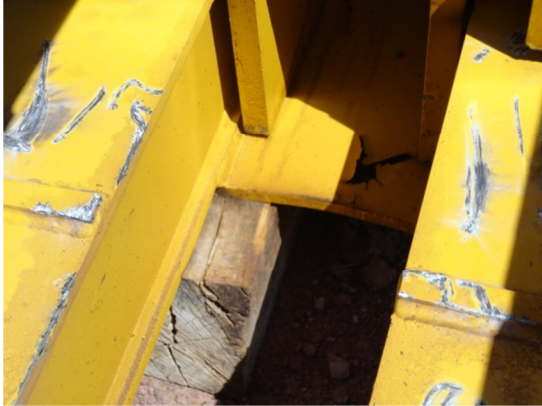
Imagen 4.3: Plancha flexionada
