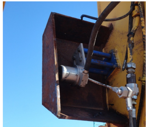
Imagen 3.26: Protección sensor del balde
