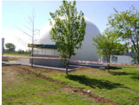
Figura 20. Gasómetro implementado en la planta CCU Temuco.
