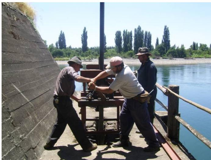
Figura 9. Operación de compuerta de la bocatoma del canal matriz Biobío Negrete. Se puede observar que se necesita de dos personas para regular la apertura de la compuerta.
