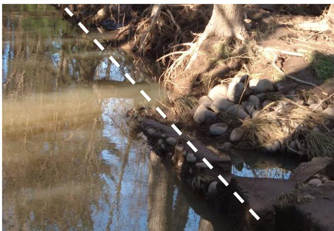
Figura 15. Tramo del canal Huingán Las Garzas destruido. La línea segmentada indica el trazado original del muro norte del canal revestido en mampostería, de la cual solo se puede distinguir una parte en mal estado. Asociación de Canalistas del Canal Biobío Norte (2006).
