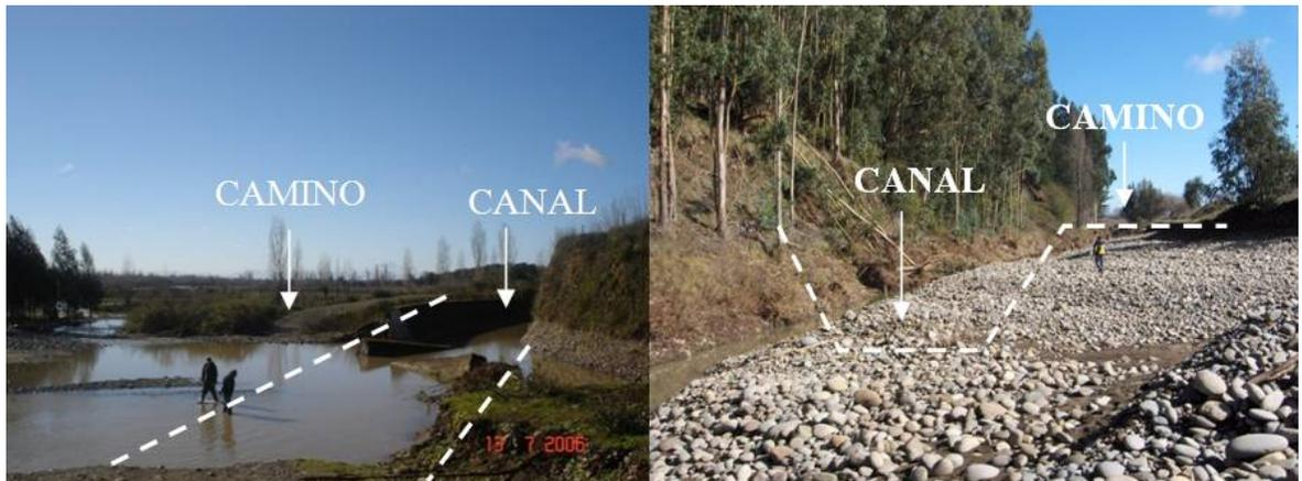
Figura 19. Destrucción canal matriz Biobío Negrete en dos tramos. Las líneas segmentadas indican la ubicación original del trazado del canal y la división con el camino de acceso. Fuente: Asociación de Canalistas del Canal Biobío Negrete (2006).
