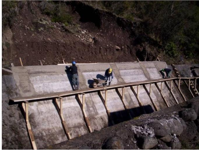
Figura 17. Reconstrucción de sector canal Biobío Sur afectado por derrumbes.
