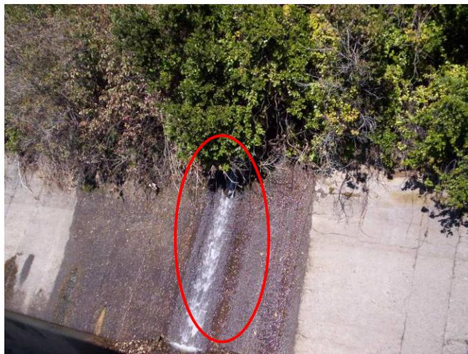
Figura 8. Falla por “piping” en canal matriz Biobío Sur. En el área encerrada por el círculo se observa la entrada de agua desde fuera del canal.
