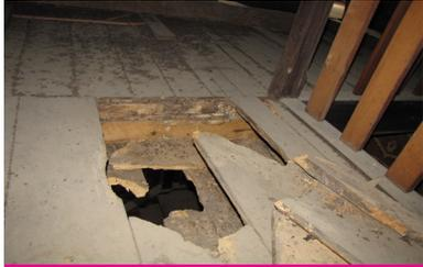
Lesión mecánica debido a la debilidad de las piezas con pudrición por constante agua proveniente de filtraciones del techo.
