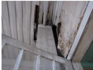
A través del extractor de humo, la humedad atraviesa todos los niveles, generando daños en cielos y pisos.
