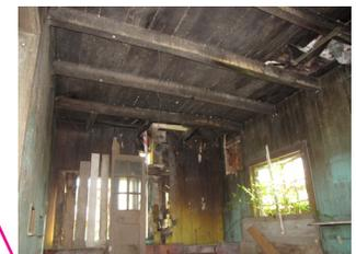
El cielo de la cocina se encuentra en un buen estado estructural, sin embargo, existen orificios en él provocados por la humedad que entra en la junta del entramado de madera con el extractor de humo de cemento o con las cañerías del baño superior.
