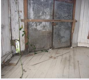
La esquina ochavada se encuentra muy deteriorada, especialmente atacada por la zarzamora, cuyo poder destructivo ha desarmado parte del paramento.
