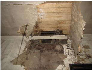
Pérdida de parte de muro y cielo debido a filtración de aguas lluvias. La humedad ha desprendido completamente el sistema de empapelado del cielo
