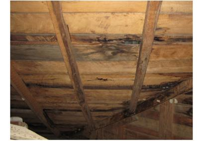
Encamizado con sectores de grave pudrición debido a filtraciones, que a su vez afectan a algunas vigas.
