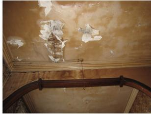
La humedad filtrada desde el techo ha traspasado el entramado de suelo, llegando a humedecer el cielo del segundo nivel, especialmente grave es el daño sobre el hall.
