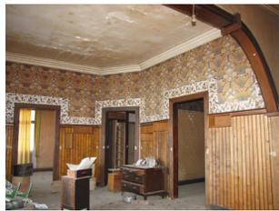
Un arco deprimido de maño enmarca el hall del segundo piso. Junto con los pisos y revestimientos de maño de este nivel, se encuentran en buen estado de conservación.
