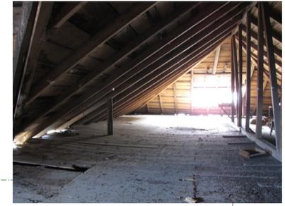
El suelo de la mansarda se encuentra, en general, bastante deteriorado: las filtraciones del techo han generado la pudrición y rotura del mismo además de estar siendo atacado por insectos xilófagos. Este debilitamiento ha generado un leve hundimiento del diafragma superior del entramado.
