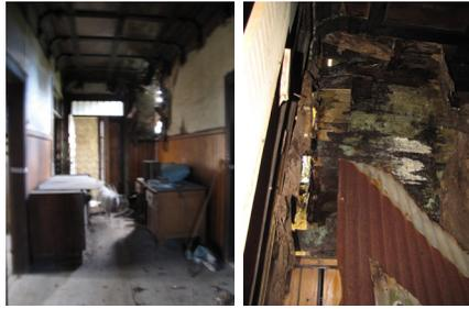
La esquina del muro, por su cara oriente, queda expuesta a la intemperie. Es tal el grado de humedad que los hongos han desintegrado parte del muro, quedando un orificio que permite el acceso directo del agua, acelerando aún más el deterioro.
