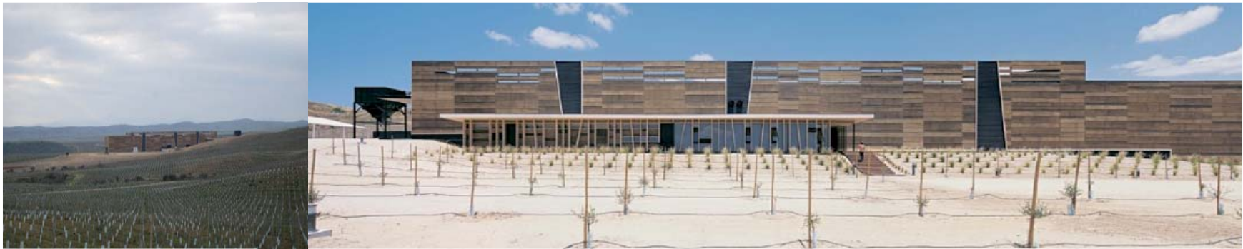
FIG 6 Y 7 ALMAZARA OLISUR FUENTE: WWW.PLATAFORMAARQUITECTURA.CL
