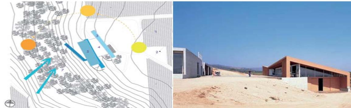
FIG.2 EMPLAZAMIENTO VISTA DEL CONJUNTO DE INTALACIONES DE BODEGA VINTOLERA WINERY, SAN ANTONIO, REFERENTE DE ORIENTACION Y USO DE LA PENDIENTE EN PROCESO GRAVITACIONAL
