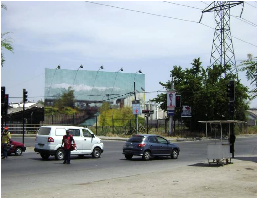
Fig. 32. Vista de la pintura ya terminada.
