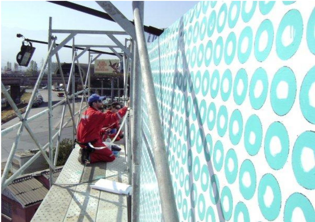
Fig. 30. Pintando junto a Luis Guzmán en el quinto piso del andamio
