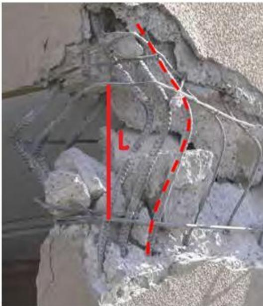
Figura 11: Largo pandeo, Figura obtenida de los daños del terremoto.
