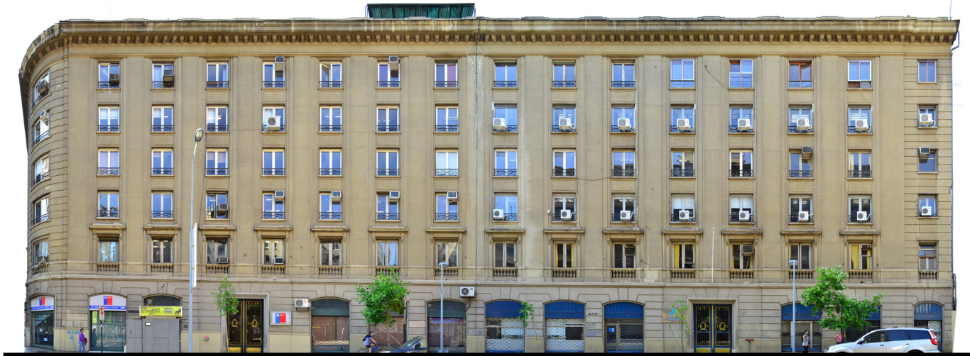
Fachada Edificio Neoclásico Mac-ver Fuente: Elaboración personal
