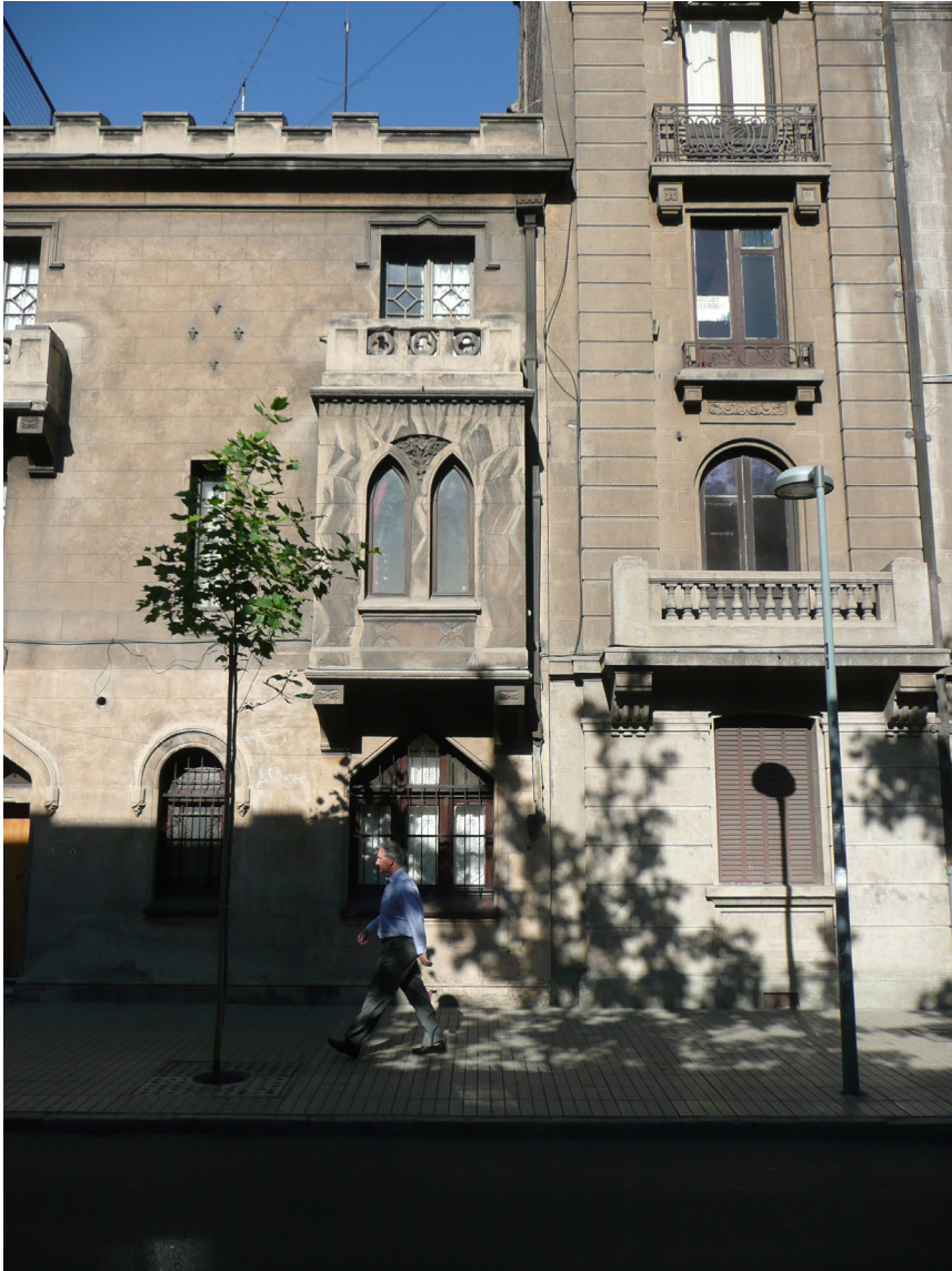
Conjunto Ecléctico Miraflores Fuente: Propia
