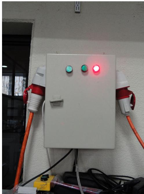
*Figura 4.1:* Tablero de alimentación trifásica.
